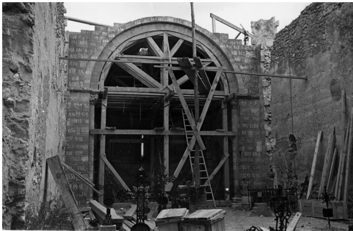
Fig. 3.54. Una vez instalado el andamio, se elevaron las cimbras hasta su posición correspondiente. The Cloisters Archive
