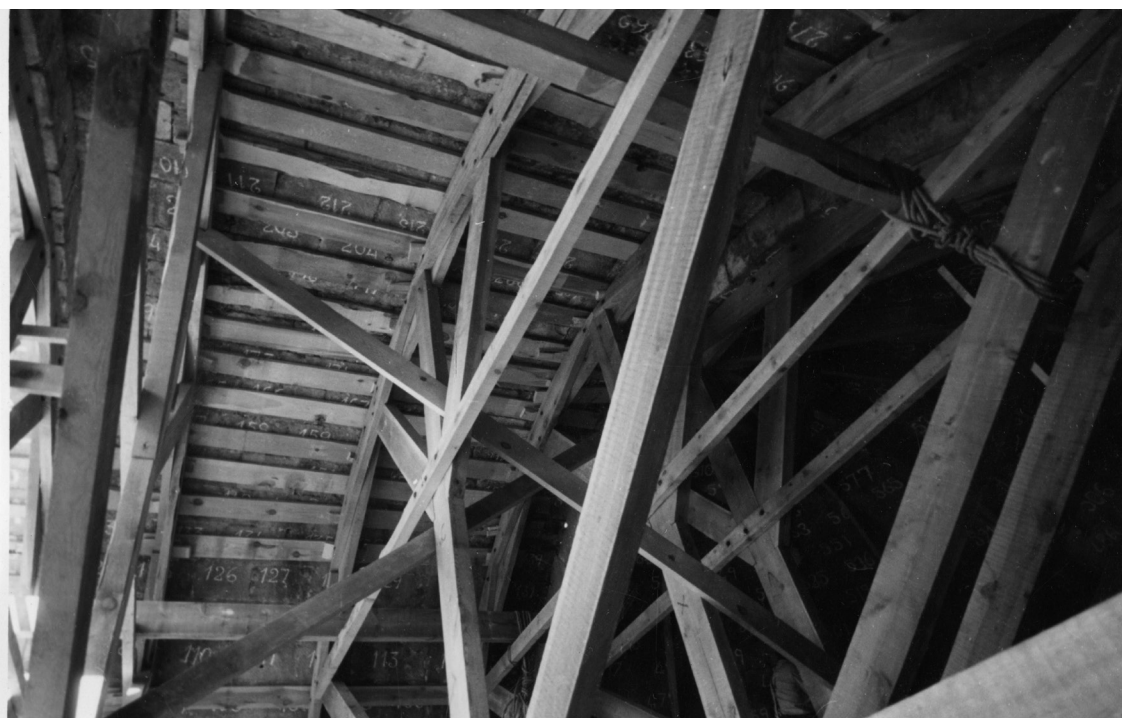
Fig. 3.55. Estado final de la cimbra y apeo total de las bóvedas, en los momentos previos al desmontaje. The Cloisters Archive
