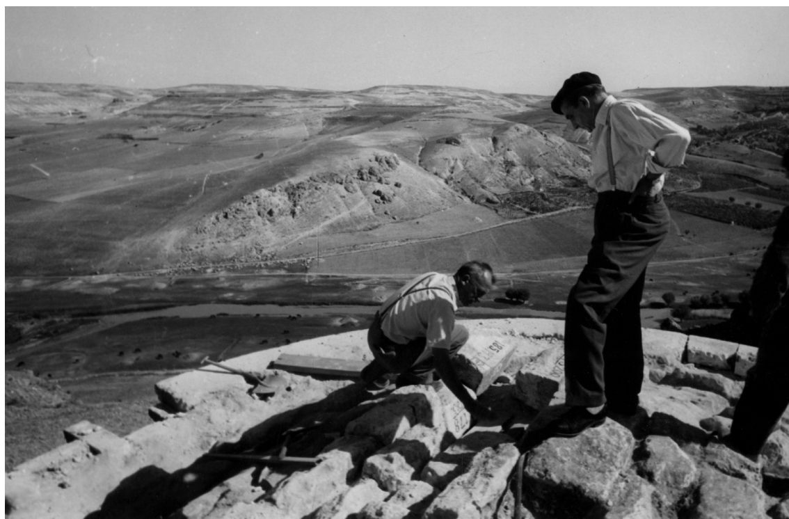
Fig. 3.45. Ferrant y Severino (encargado) mientras inspeccionan la colocación de las dovelas de la bóveda de nicho. The Cloisters Archive
