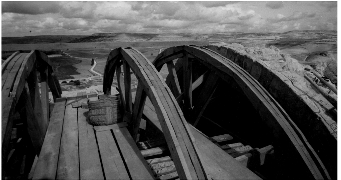
Fig. 3.56. Bóveda de cañón desmontada, en la que solamente resta desmontar las cimbras. The Cloisters Archive
