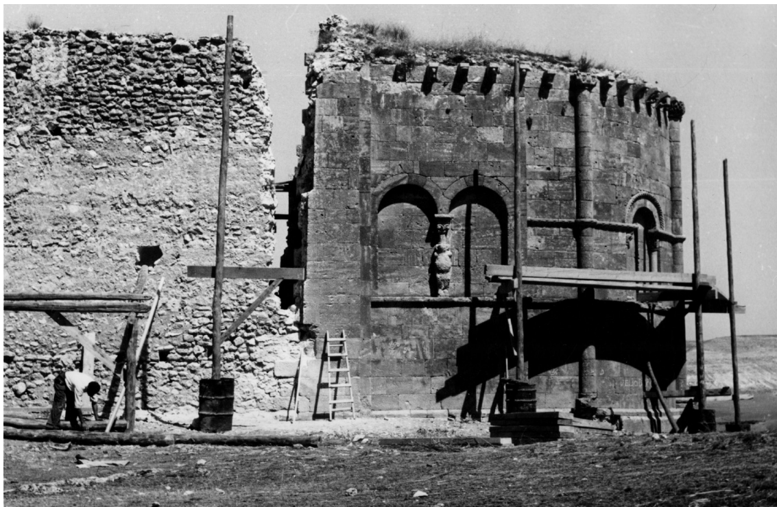
Fig. 3.49. La separación del cuerpo del ábside respecto de los muros laterales permite el inicio del procedimiento de desmontaje. The Cloisters Archive
