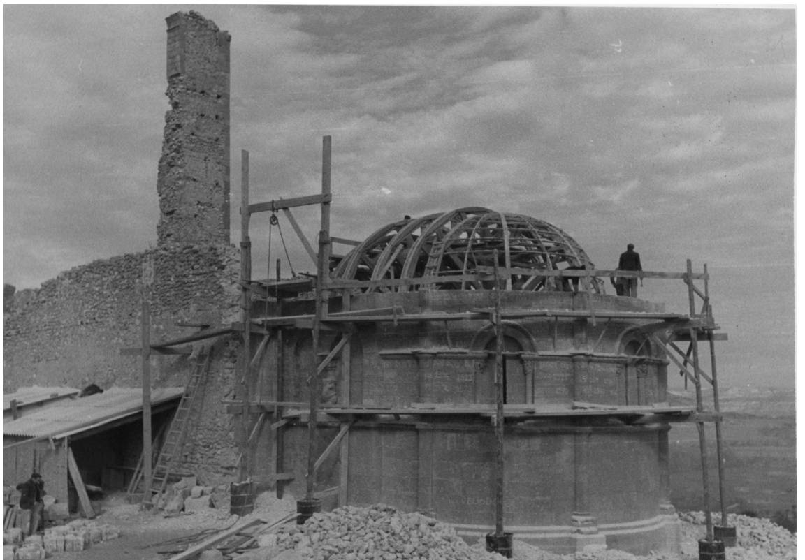
Fig. 3.57. Ábside sin su sistema de bóvedas, antes del desmontaje final de los medios auxiliares. The Cloisters Archive
