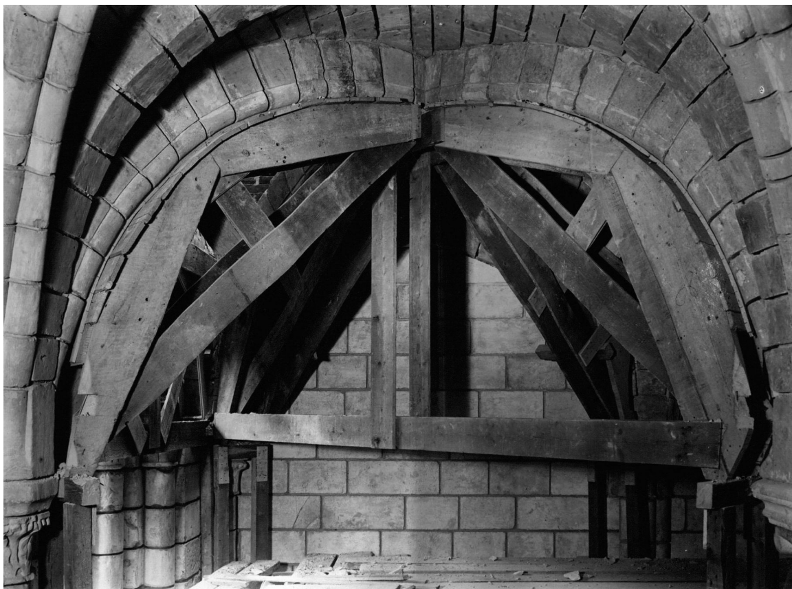
Fig. 1.17. Vista del intradós de la bóveda de Pontaut con la cimbra de los nervios. The Cloisters Archive
