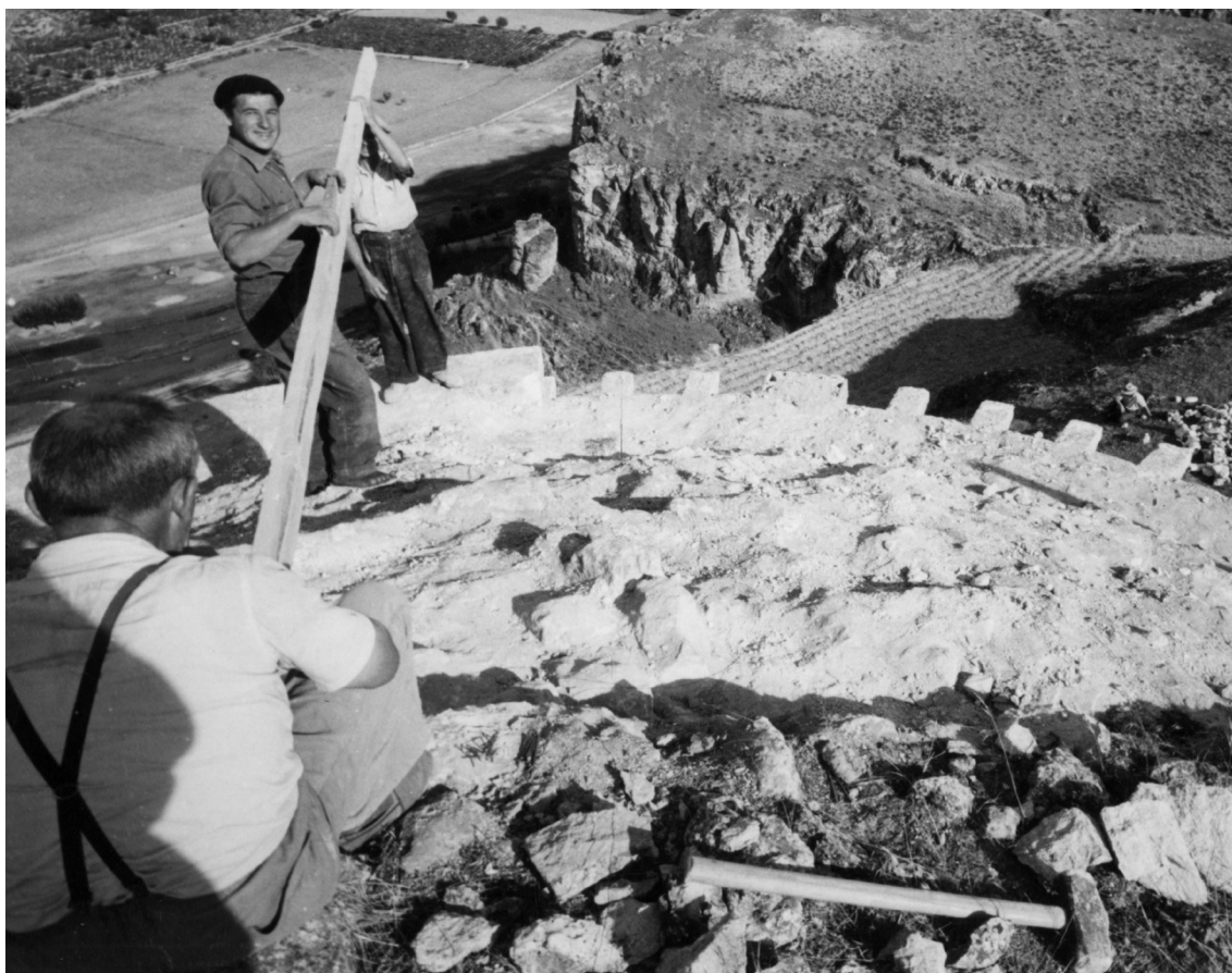
Fig. 2.16. Izquierda: Técnica del Opus Emplectum o de dos hojas. The Cloisters Archive
