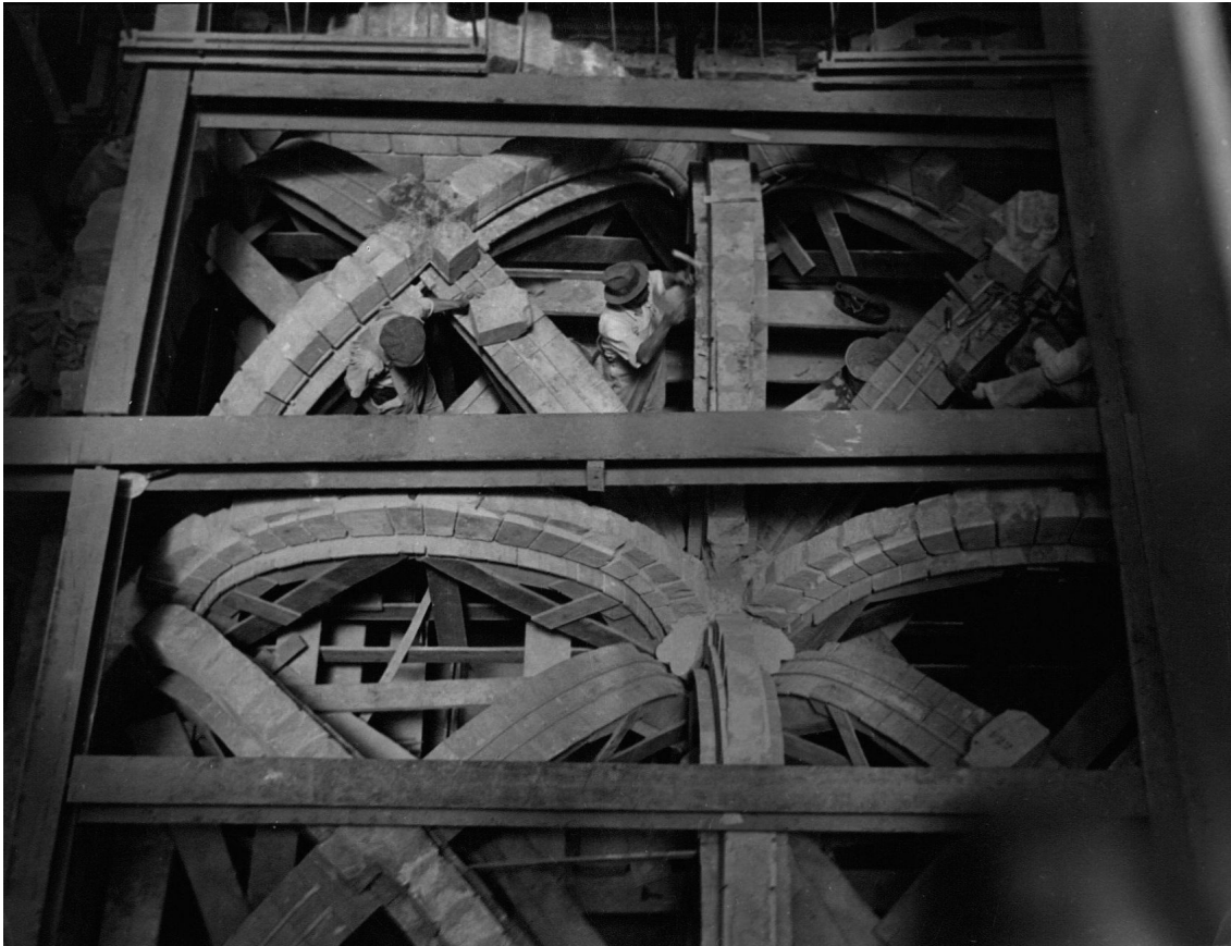
Fig. 1.14. Reconstrucción de los nervios de la bóveda del aula capítular de Pontaut. The Cloisters Archive
