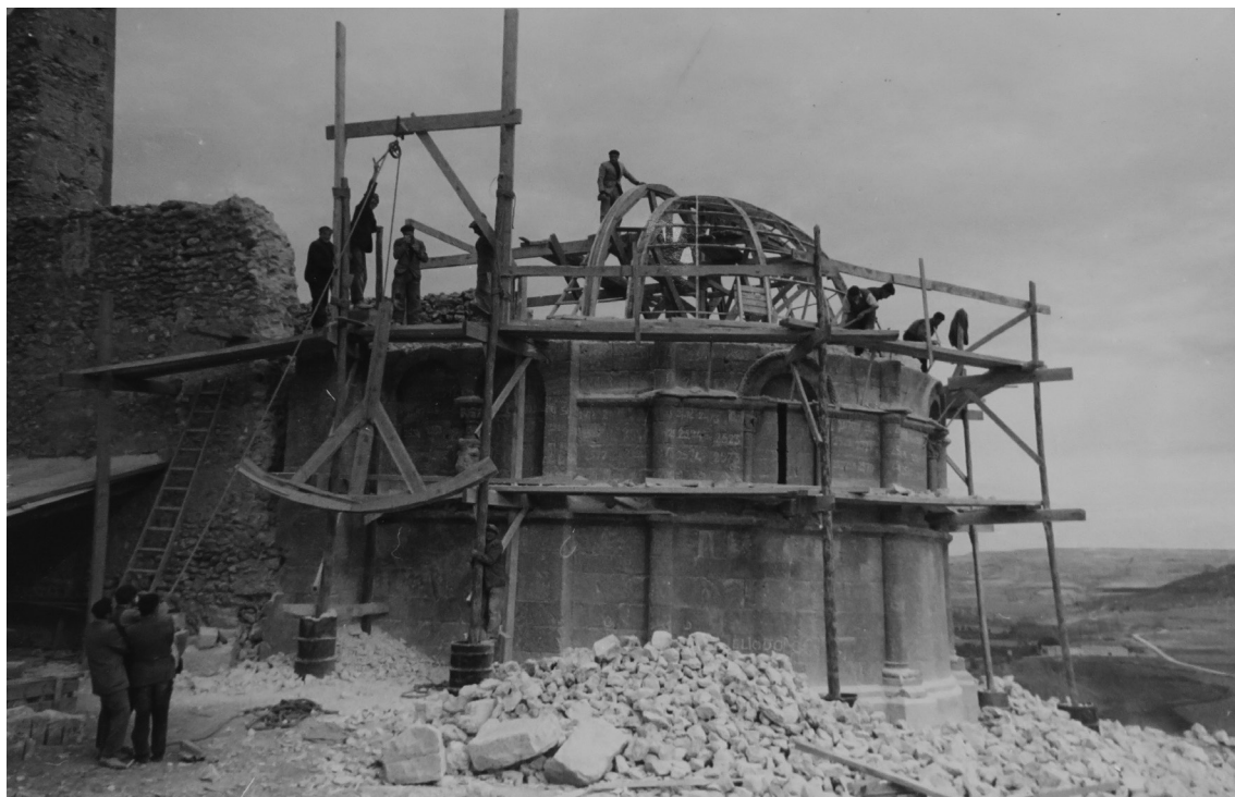
Fig. 3.61. Retirada y descenso de las cimbras utilizadas para el desmontaje de las bóvedas. CAC Demarcació de Lleida
