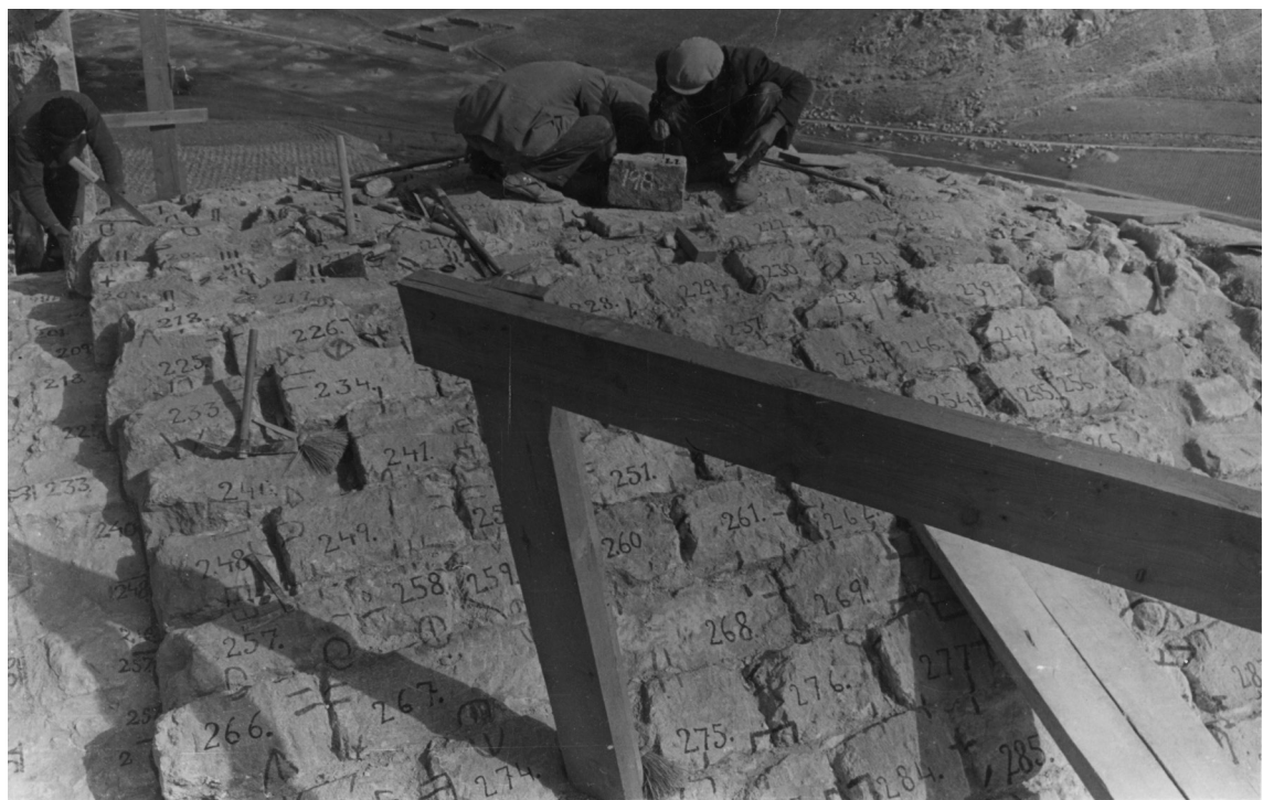
Fig. 3.48. Proceso de limpieza de las juntas de mortero, de numeración de las dovelas y de colocación de marcas que permiten relacionar cada pieza con la contigua. The Cloisters Archive
