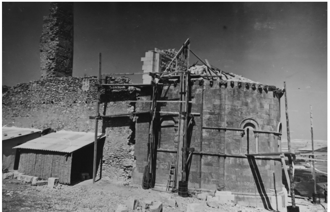
Fig. 3.50. Terminación del cierre superior del arco de triunfo del ábside. The Cloisters Archive
