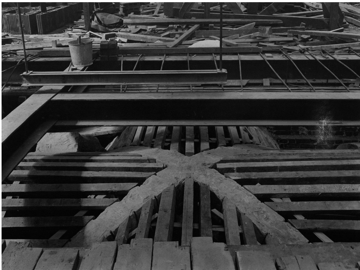
Fig. 1.16. Vista desde el extradós, donde se aprecia la cimbra para construir la plementería de la bóveda de Pontaut. The Cloisters Archive
