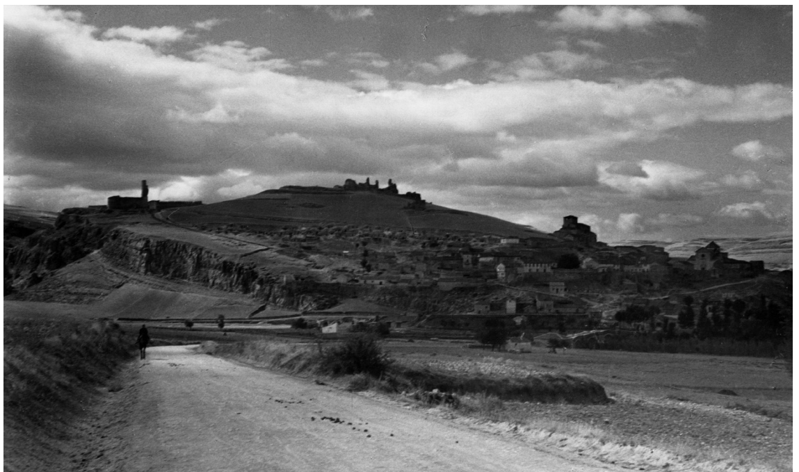
Fig. 2.2. Imagen de la localidad de Fuentidueña, en 1957. The Cloisters Archive
