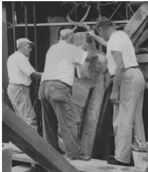
Fig. 3.77. Comprobación de dovelas. The Cloisters Archive
