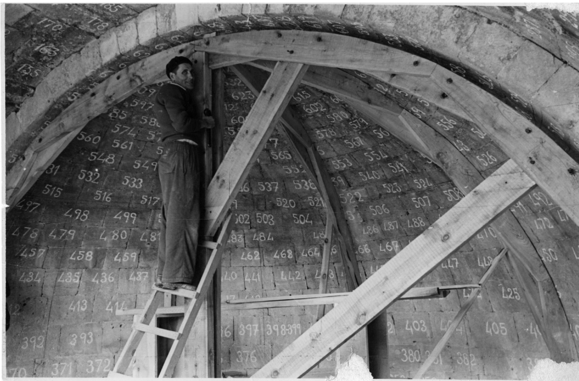
Fig. 3.53. Proceso de montaje, ajuste y fijación de la cimbra de las bóvedas. The Cloisters Archive
