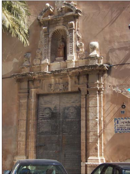
Figure 21. St. Bartolomé cover church placed on the Escuela de Artes y Oficios . 2016.
