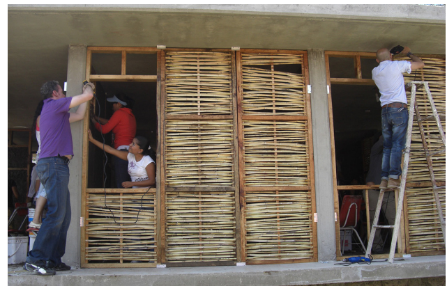
Figura 5.13. Construcción con voluntarios Fuente: (Franco,J, 2015)
