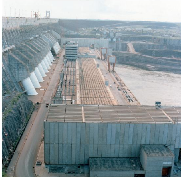
Figura 12 Vista aérea de la casa de máquinas.
