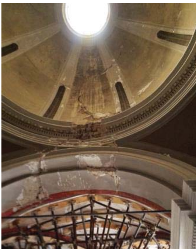
Cupola direttamente imposta sugli archi trionfali (assenza del tamburo)
