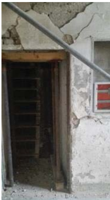
Parte di struttura della torre campanaria
