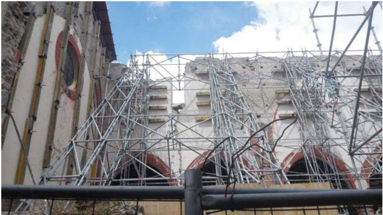
Ponteggio delle muro nord.
