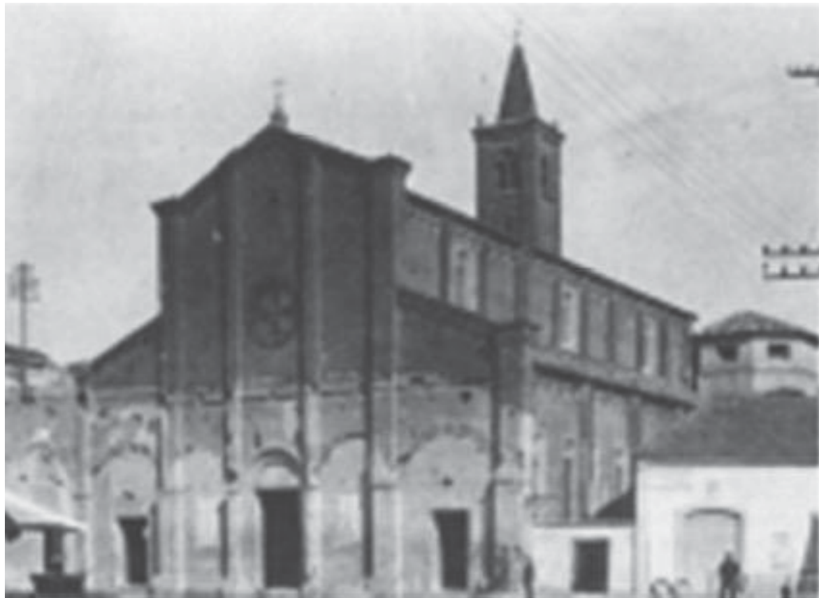
Vista della facciata dopo il restauro del
