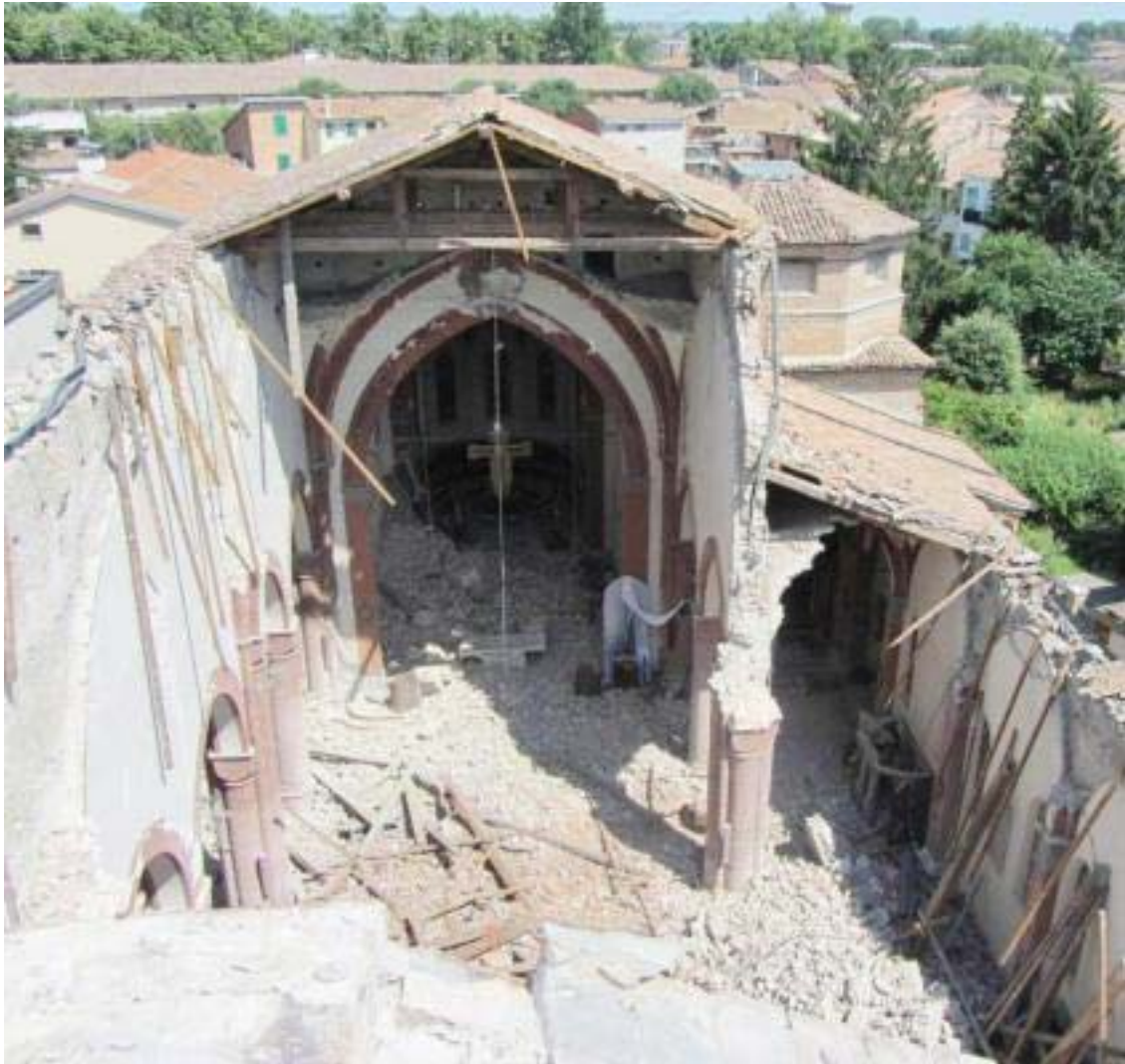
Copertura senza controventi di falda
