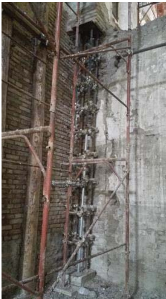
Punteggio dei pilastri
