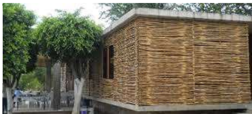
Recubrimiento de carrizo en vivienda
