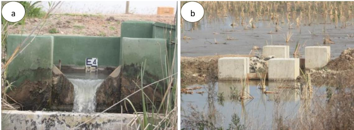
Figura 4.5. Detalles de (a) el vertedero triangular de entrada al *Tancat de la Pipa* desde el punto P0b y (b) las compuertas intermedias con el tablón de madera que regula el paso del agua.
