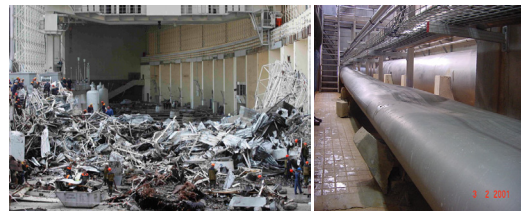
Figura 20 Central hidroeléctrica de Sayano-Shushenskaya (Rusia) tras el accidente (izq.) Tubería colapsada por una depresión en Valencia (der.)
