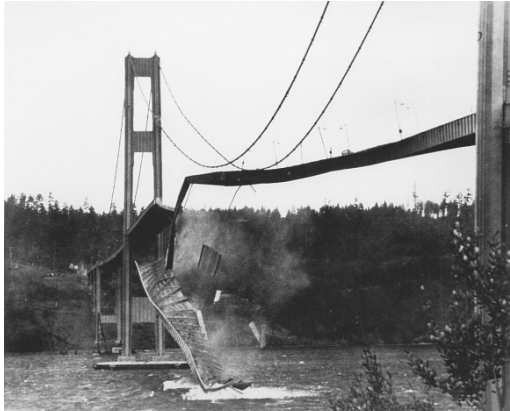
Figura 9 Colapso del puente de Tacoma Narrows el 7 de Noviembre de 1940
