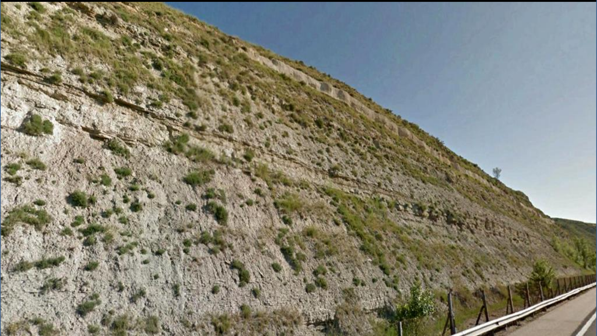
Talud de la autopista con arcillas y limolitas del Mioceno Inf.-Med. Terciario. NE de Castil de Peones, Burgos. N Centro W Hoja de Belorado.
