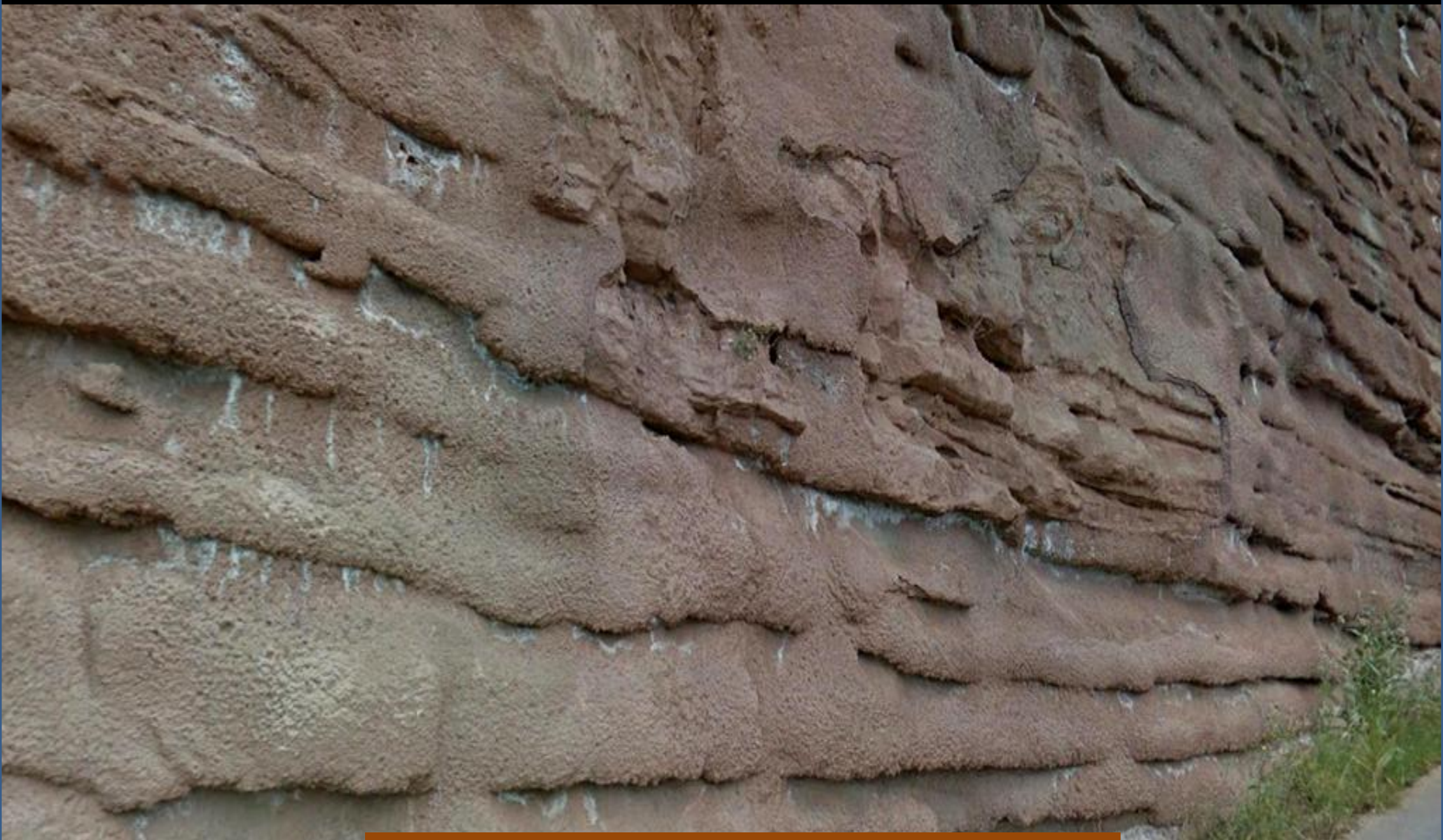
Detalle del gunitado en la imagen anterior, sobre las areniscas, limolitas y arcillas rojas del Arverniense-Ageniense, Oligoceno-Mioceno Inf. Terciario. NW de Nájera, La Rioja. W de la Hoja.
