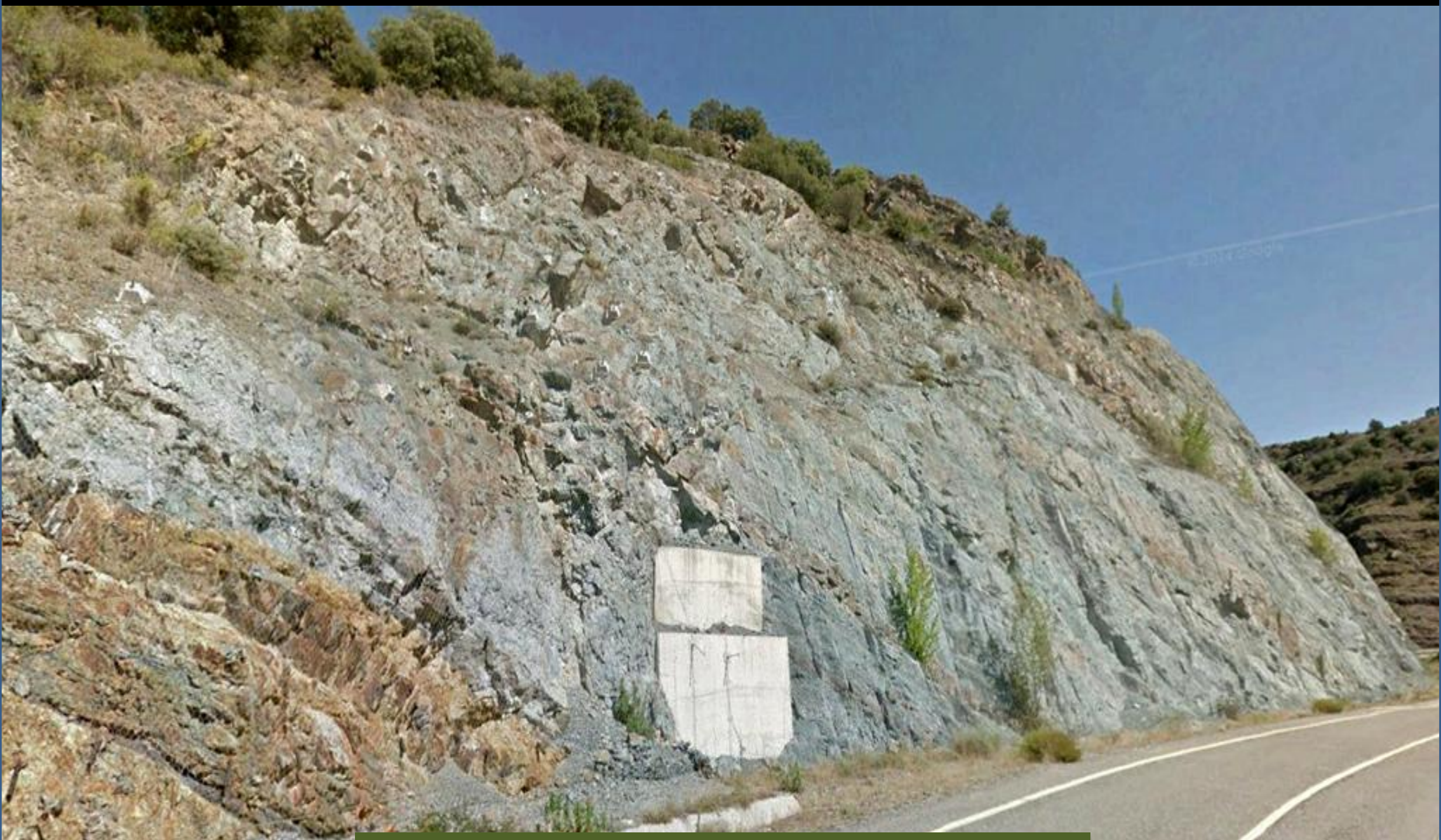
Actuaciones- mallazo, muros- para la estabilización del talud en los materiales alternantes pelítico- samíticos, del Valanginiense, Cretácico Inf. NE de Yanguas, Soria. NE Hoja de Enciso
