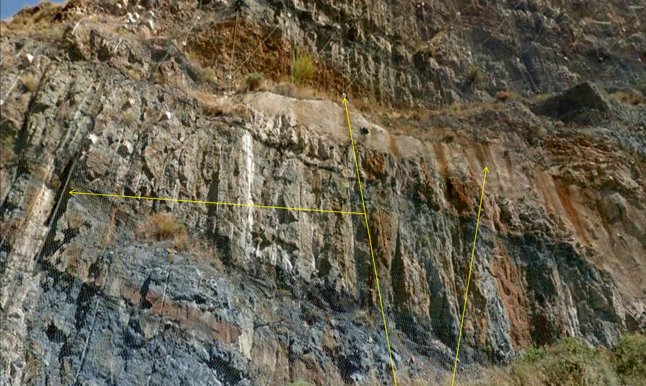
Detalle de la anterior: Actuaciones- mallazos, bulones, gunitado- para la estabilización del talud en los materiales alternantes pelítico- samíticos, del Valanginiense, Cretácico Inf. NE de Yanguas, Soria. NE Hoja de Enciso.
