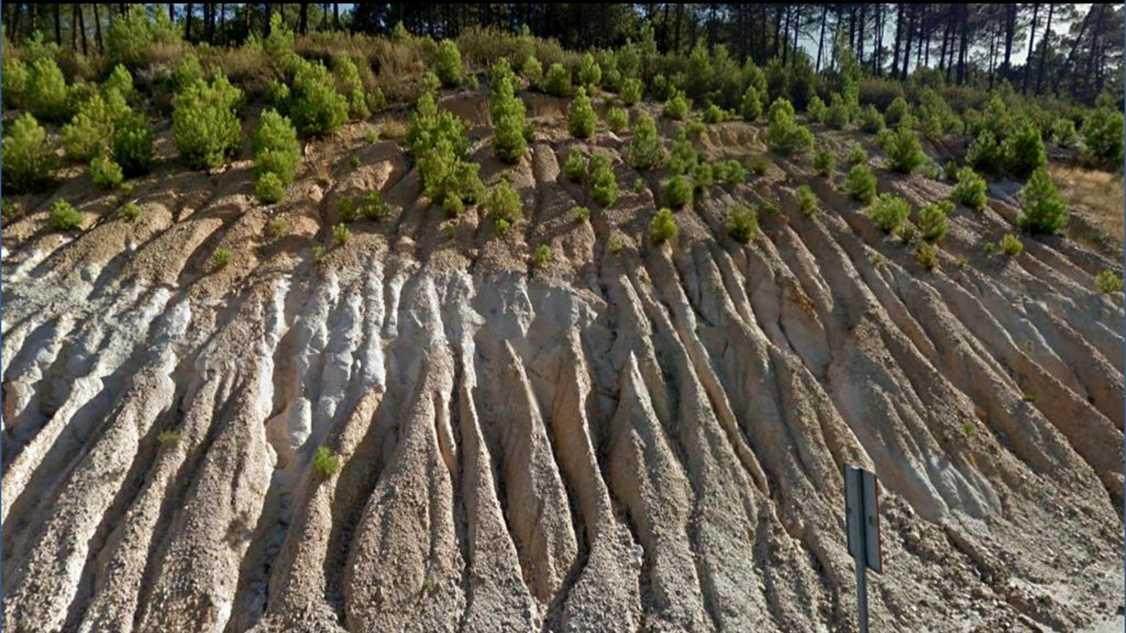
Plantar vegetación para estabilizar talud en las arenas y gravas del Aptiense, Facies Weald. Cretácico Inf. SE de El Amogable, E – NE Hoja- de San Leonardo de Yagüe, Soria.
