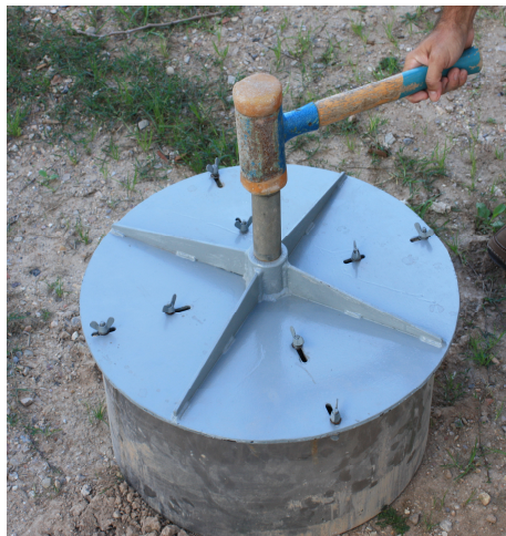
Figura 7.- Detalle de la instalación de los anillos
