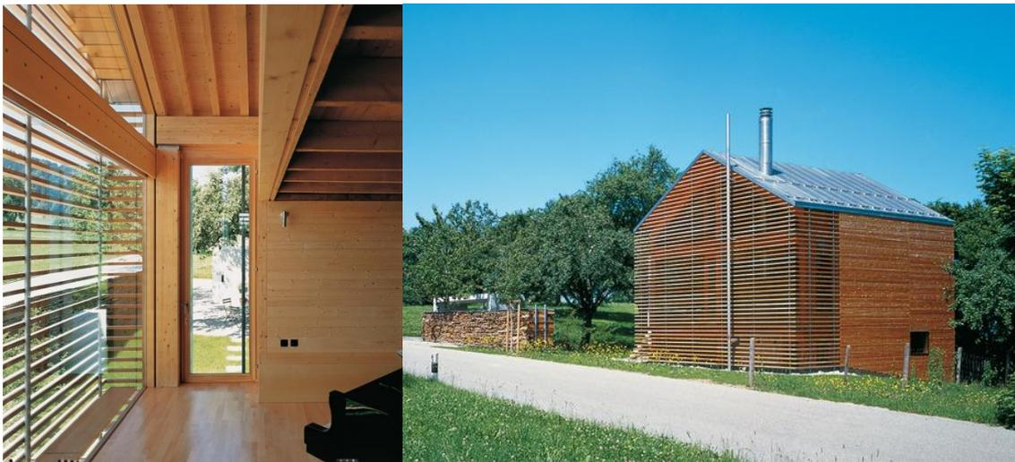
*Vista interior y exterior de la casa en la que se puede observar la utilización de madera y la cubierta de titanio-zinc. Fuente: [www.detail-online.com](http://www.detail-online.com)*
