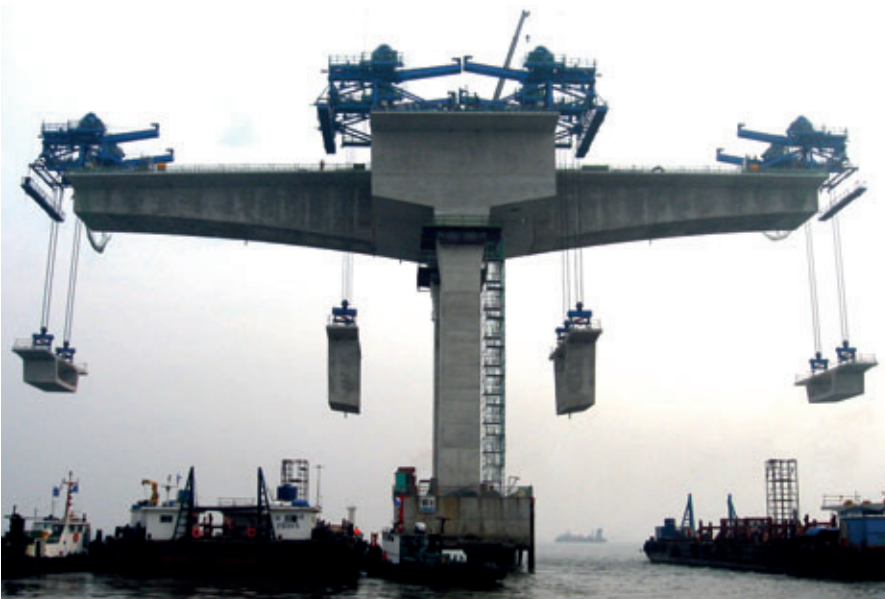
Figura 4: Construcción de un puente en el mar mediante el empleo de cajones prefabricados de hormigón para la formación del tablero
