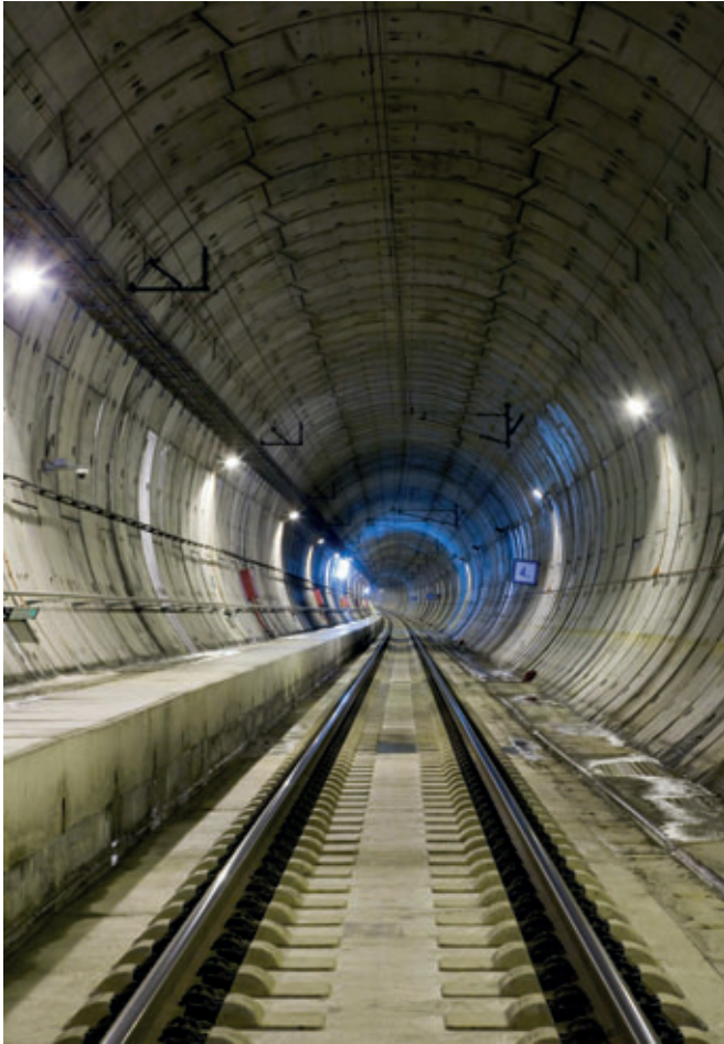
Figura 2: Traviesas y dovelas juegan un papel fundamental en la construcción de líneas de ferrocarril y túneles, como sucede en dos de las mayores obras que se están acometiendo actualmente, como son los nuevos túneles subterráneos que cruzan el Estrecho del Bósforo en Estambul (Turquía) y la nueva línea de Londres (Inglaterra).
