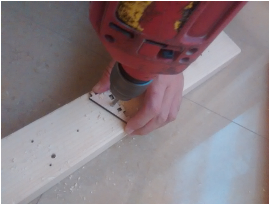
Figura A.9: Procedimiento de montaje de uniones mecánicas
