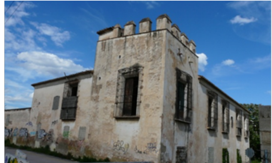
Imagen 7.7 -Alquería de la Torre_Torre almenada
