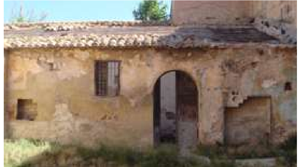
Imagen 7.19- Alquería de la Torre_ Corrales
