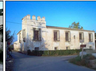
Fachada de la Alquería de la Torre recayente a la Calle Alquería del Moro
