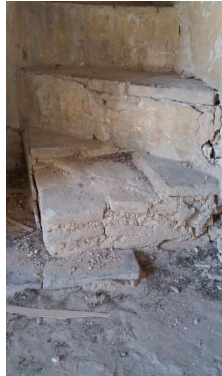
Imagen 8.16-Alquería de la Torre_Escalera de caracol
