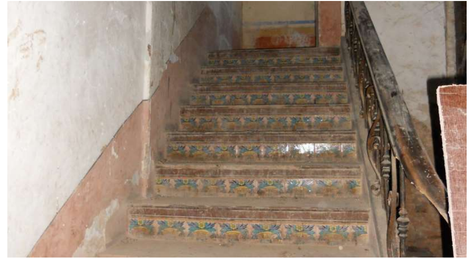
Imagen 7.15- Alquería de la Torre_ Escalera principal
