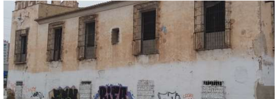
Imagen 8.7- Alquería de la Torre_Huecos de dintel recto en cerramientos exteriores
