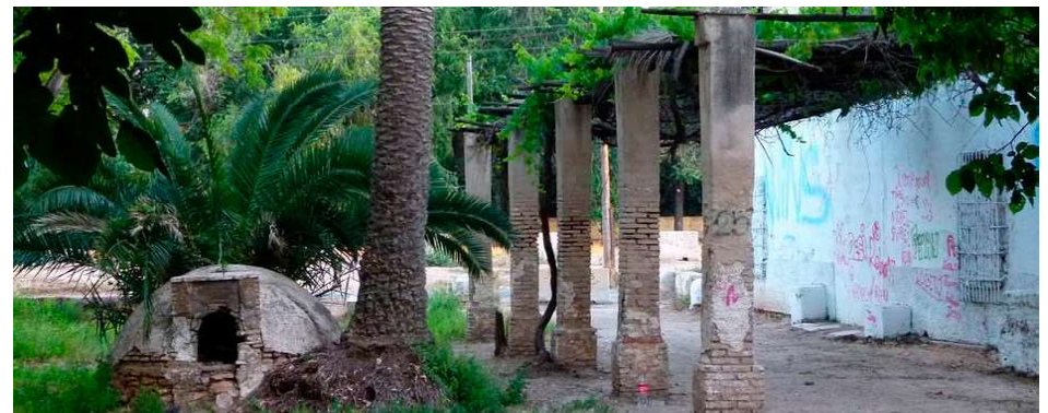
Imagen 8.21- Alquería de la Torre_Porche
