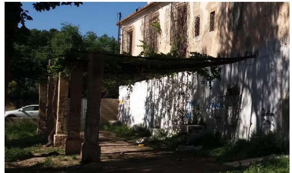
Imagen 7.10 -Alquería de la Torre_Porche
