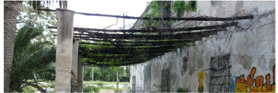
Imagen 8.19 - Alquería de la Torre_Porche
