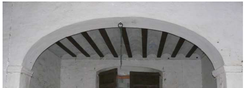
Imagen 8.9- Alquería de la Torre_Huecos con arco carpanel en interior
