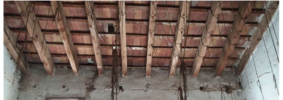
Imagen 8.10- Alquería de la Torre_Cubierta inclinada
