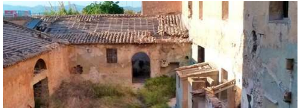
Imagen 8.8- Alquería de la Torre_Huecos con arcos de medio punto en edificio agrario
