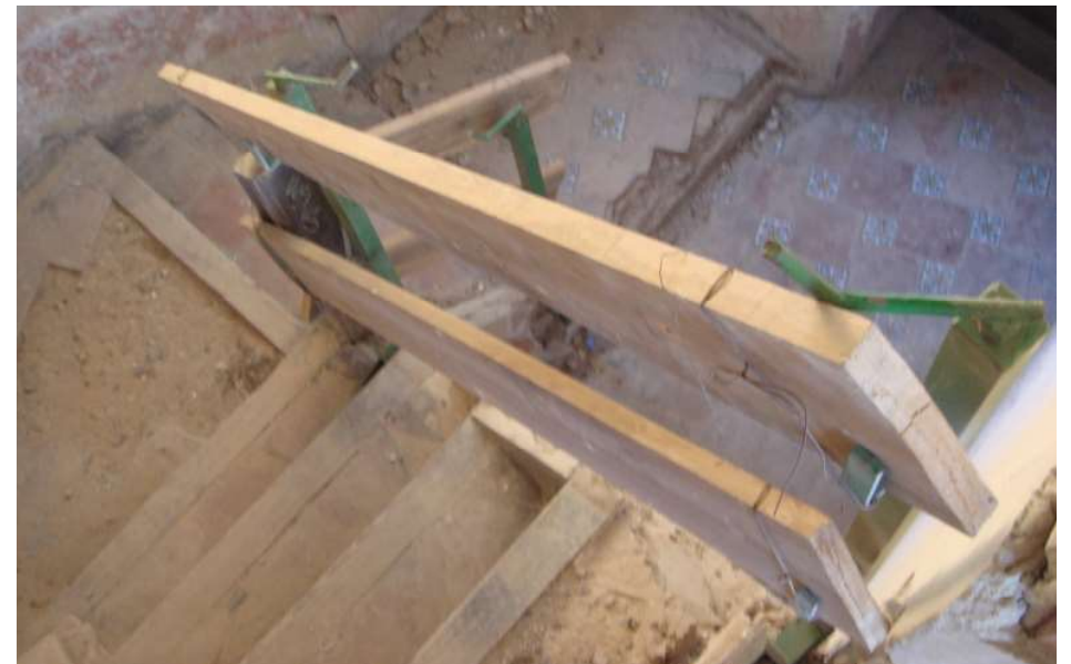
Imagen 7.16- Alquería de la Torre_ Escalera principal
