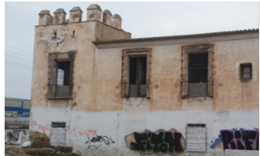
Imagen 7.8 -Alquería de la Torre_Torre almenada
