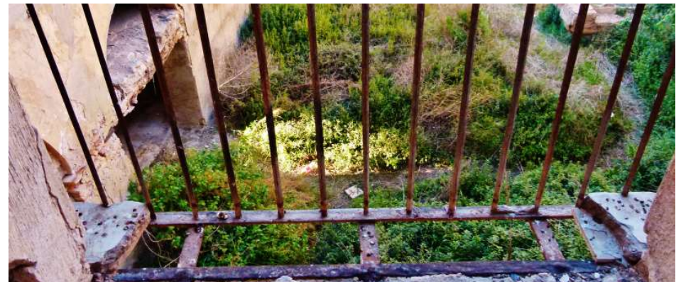
Imagen 8.15- Alquería de la Torre_Cerrajería balcón interior
