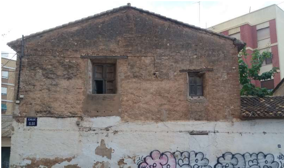
Alquería Lluna_ Cubierta a dos aguas
