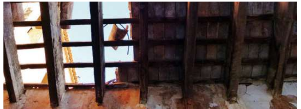
Imagen 8.11- Alquería de la Torre_Cubierta inclinada
