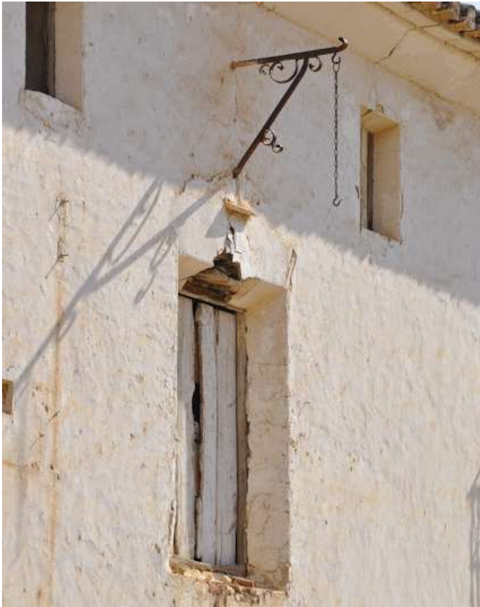
Alquería Fonda_ Ventanas de dintel recto
