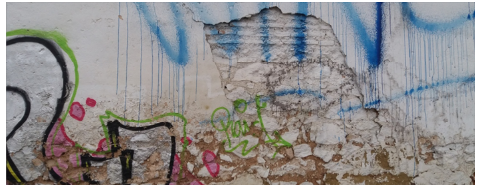
Imagen 8.5- Alquería de la Torre_Muro mixto de mampostería e hiladas de fábrica
