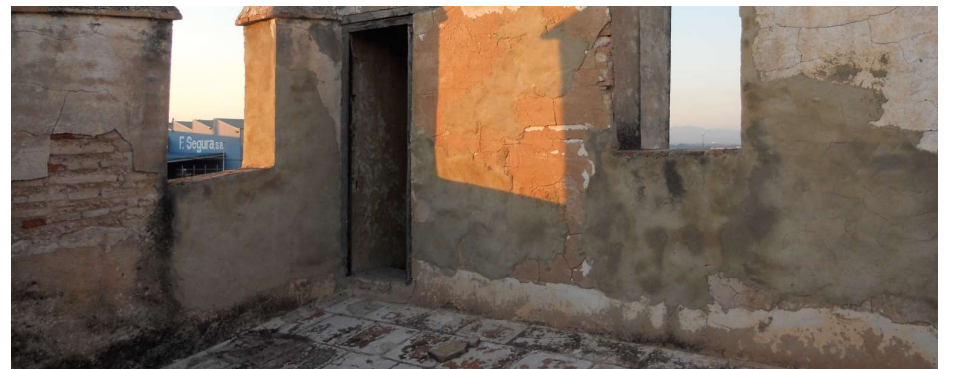
Imagen 8.12- Alquería de la Torre_Cubierta plana
