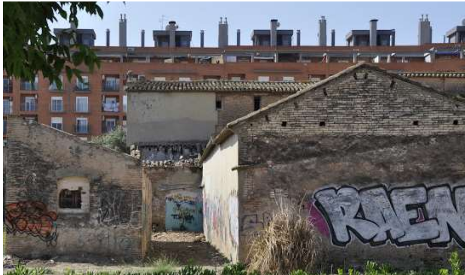
Alquería Falcó_ Cubierta a dos aguas
