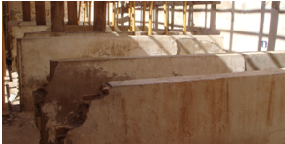
Imagen 7.18- Alquería de la Torre_ Corrales
