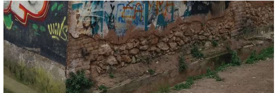
Imagen 8.4- Alquería de la Torre_Muro de mampostería y ejecución de esquinas con fábrica
