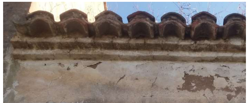
Imagen 8.3 -Alquería de la Torre_Detalle alero
