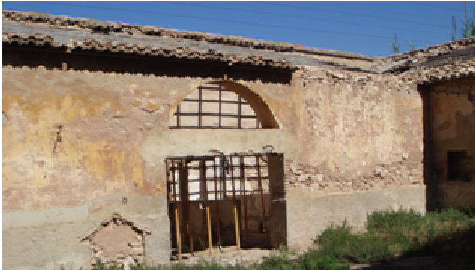
Imagen 7.17- Alquería de la Torre_ Corrales
