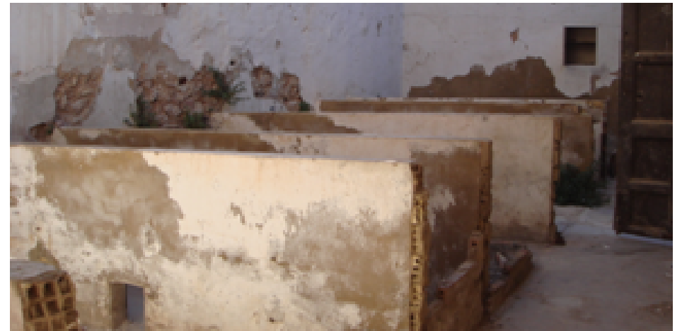
Imagen 7.20- Alquería de la Torre_ Corrales
