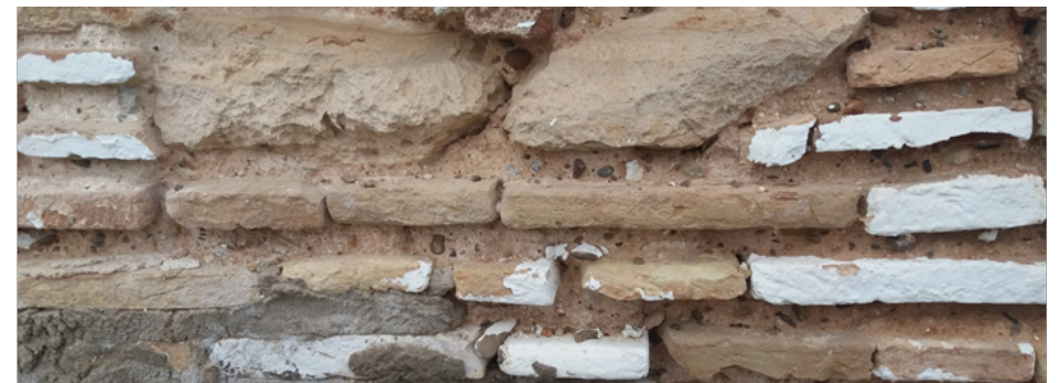
Imagen 8.6- Alquería de la Torre_Muro mezcla de fábrica y piedras de mampostería
