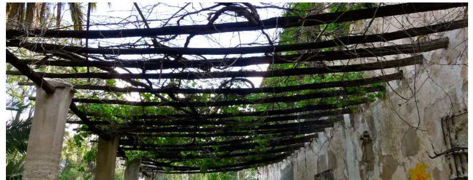
Imagen 8.20- Alquería de la Torre_Porche
