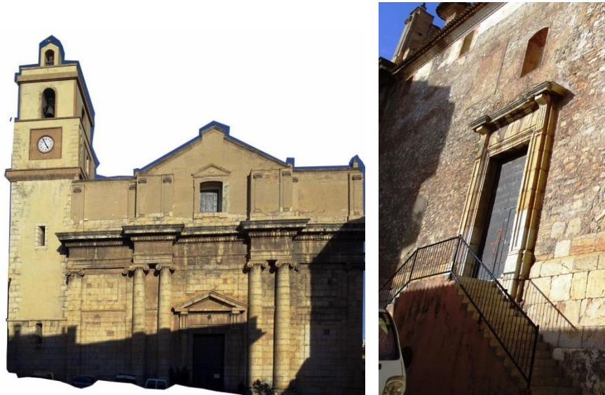
Fig. 4. 4 a) Fachada principal. b) Fachada sur.
