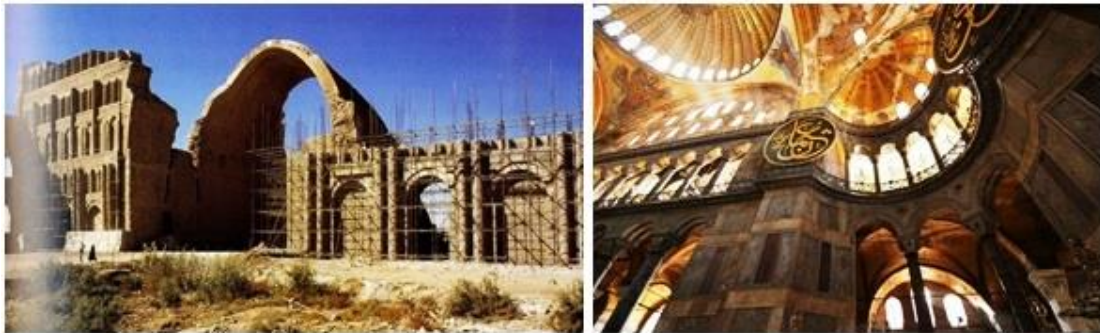
Fig. 2. 9 a) Palacio de Ctesifonte, Iraq – s. II a.C. Pórtico de entrada, arcos de ladrillo 7 . b) Basílica de Santa Sofía, Estambul – s. VI. Arcos de fábrica de ladrillo de 33 metros de luz. Fuente: http://whc.unesco.org
