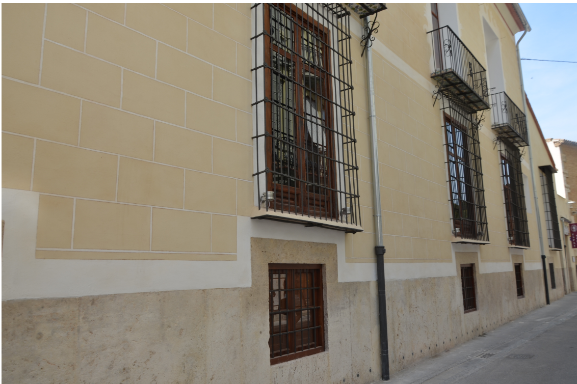
Figura 49. Ventanas de entresuelo y sótano (Andrea Chust Company)
