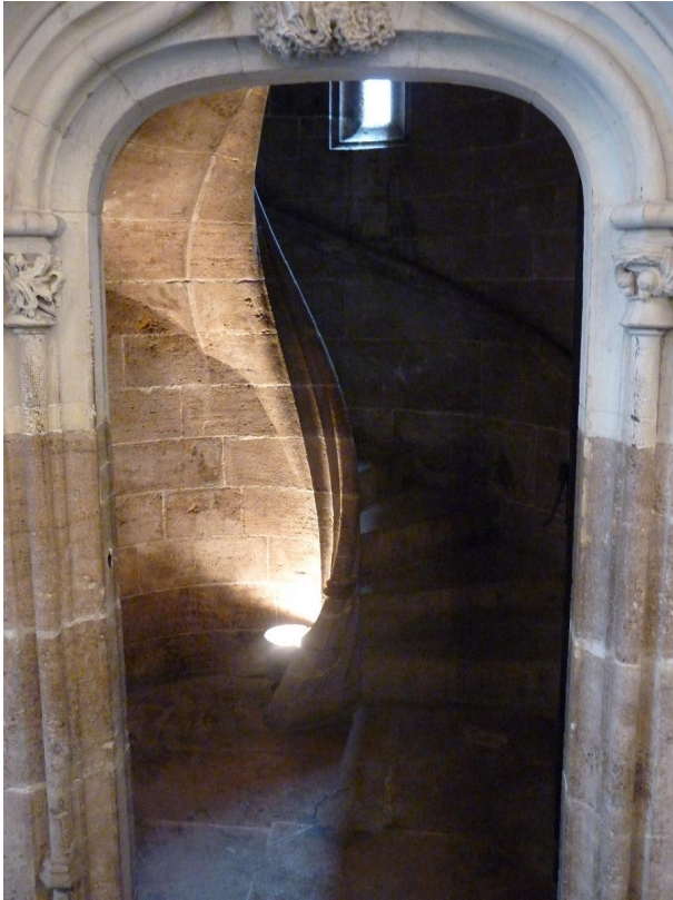
Figura 9. Escalera que da acceso a la torre ( Andrea Chust Company)
