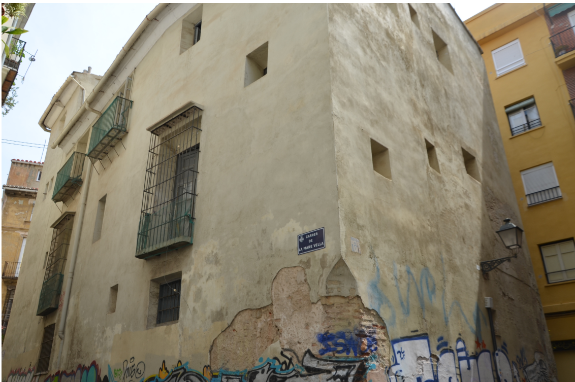
Figura 30. Entorno de la Casa Taller March, Carrer de la mare Vella (Andrea Chust Company)
