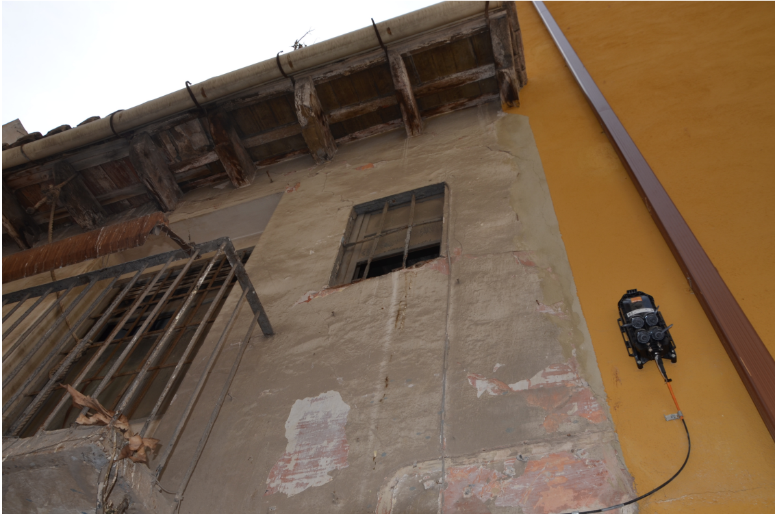
Figura 33. Detalle de ventana (Andrea Chust Company)
