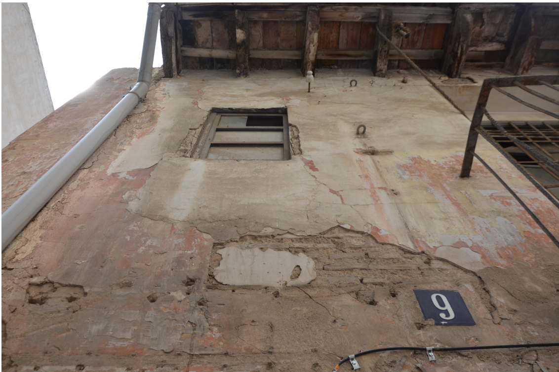
Figura 32. Detalle de ventana (Andrea Chust Company)
