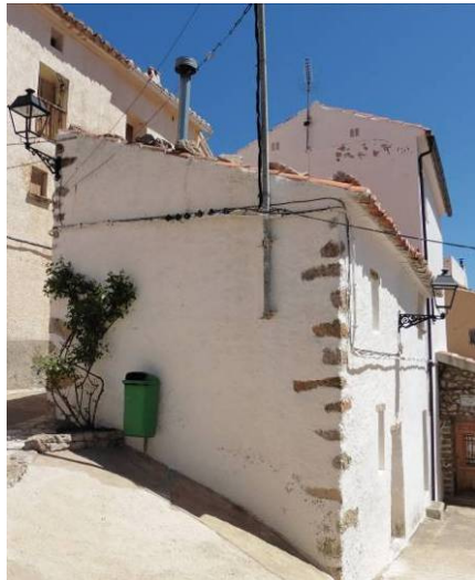
Revestimiento en blanco con esquinas vistas
