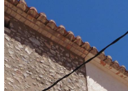
Cubierta a un agua vertiente a fachada principal. Aleros pintados
