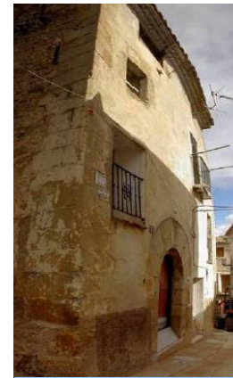
Fig 176. Casa Abadía Siglo XVII. Destaca el arco de la puerta principal, y los sillares de las esquinas. Protección integral. Fte: Autora
