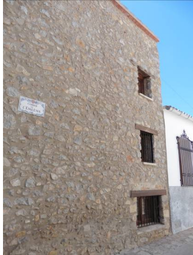
Piedra vista tras rehabilitación reciente
