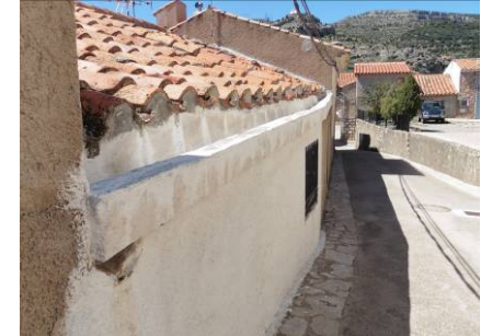
Cubierta a un agua vertiente a fachada principal. Canalón en muro
