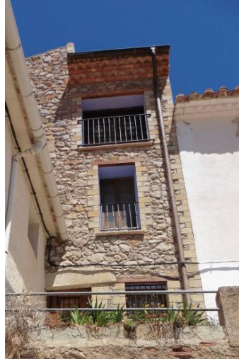
Piedra vista tras rehabilitación reciente (
