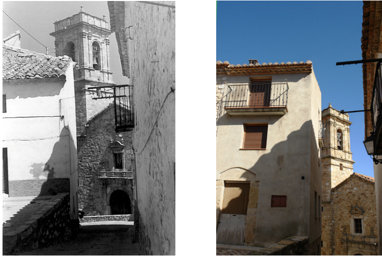
Fig 10 Aspecto de la Plaza Hospital antes y después de enterrar el cableado. Fte.: Ayto. Culla
