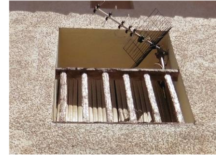
Rejas de madera en ventana).
