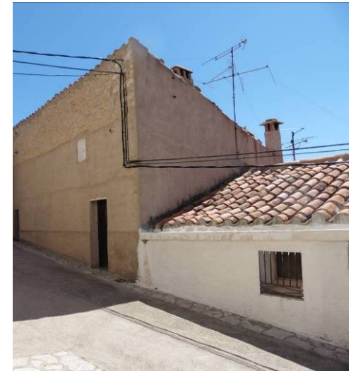
Revestimiento de mortero de cemento (izq.)
