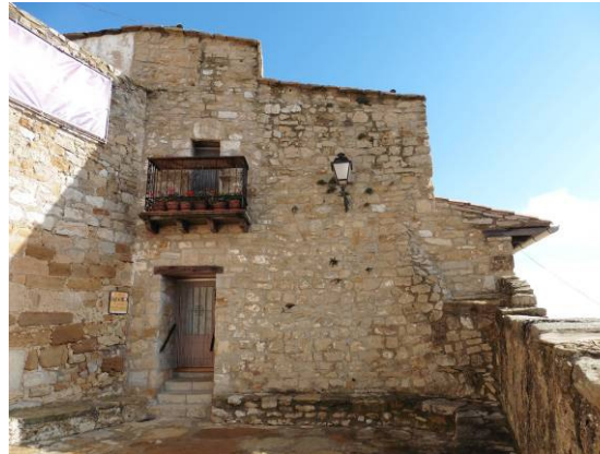
Fig 36 Vivienda rehabilitada recientemente. Fte: Autora.
