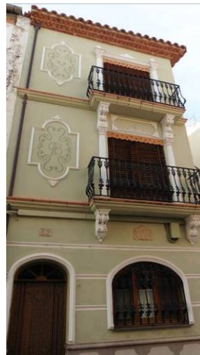
Fig 143 Vivienda modernista. susceptible de protección
