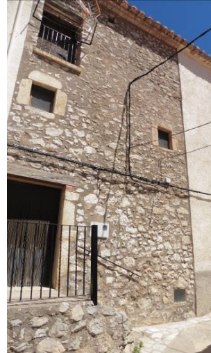
Piedra vista tras rehabilitación
