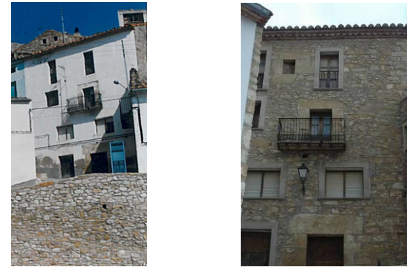
Fig 15 Reforma del antiguo ayuntamiento. Fte.: Ayto. Culla
