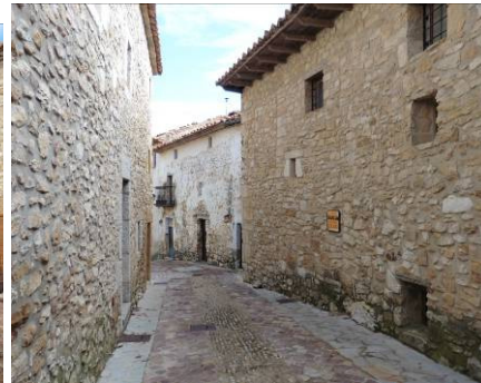
Fig 91 Calle Horno. En primer plano, antiguo Hospital. Fte.:Autora
