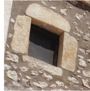
Pervivencia de jambas de sillares
