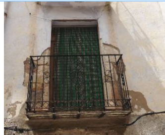
Balcón de rejería sobre ménsula
