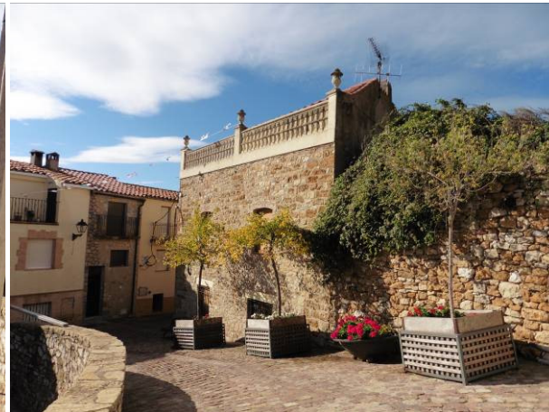
Fig 51 Fachadas orientación NO y NE. Fte: Autora
