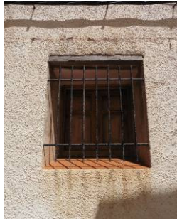
Carpintería de madera y rejera de forja
