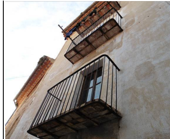
Fig 30 Balcones de hierro y bandeja de losas. Fte: Autora
