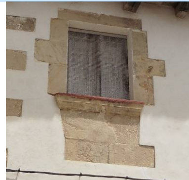
Jambas de sillares C/Forn Vell
