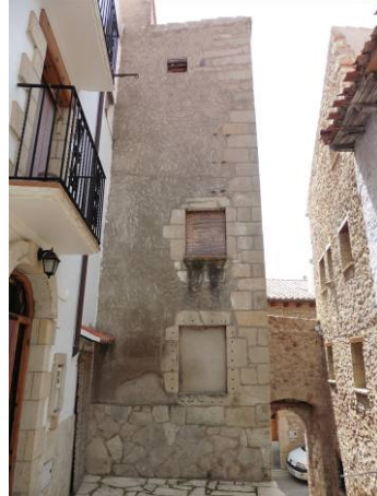
Enfoscado de mortero de cemento
