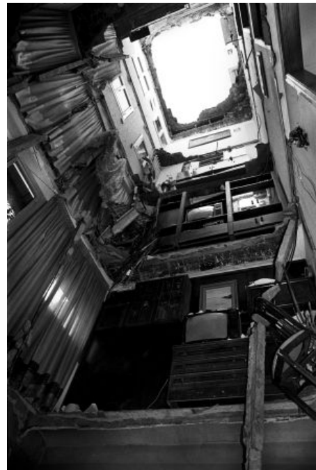
Figura 14. Derrumbe de una casa de la calle Cadí, el 11 de noviembre de 1990. (Marcel·lí Sàenz, PERIÓDICO el País)
