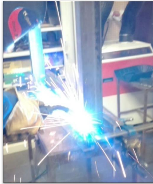
Figura 183. Soldadura de los perfiles del potro
