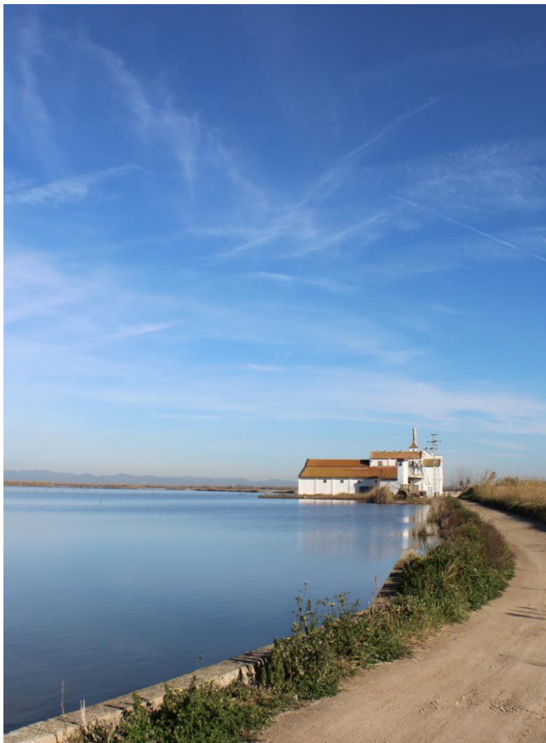
FIGURA 1. Casa de la Baldovina.
