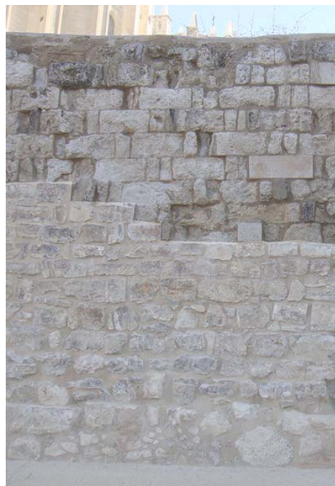
FIG.06.3. Detalle de un lienzo de Muralla, señalando la fábrica de caliza.
