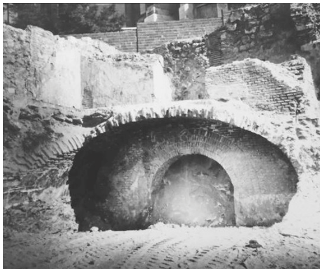
FIG.09.37. Fotografía de detalle de la construcción de las bóvedas de los sótanos del palacio. Tramo TR1.
