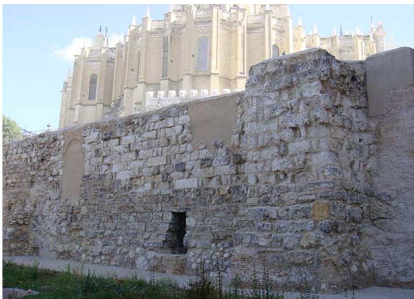
FIG.06.1. Vista del tramo TR2 y torre T2 una vez restauradas.
