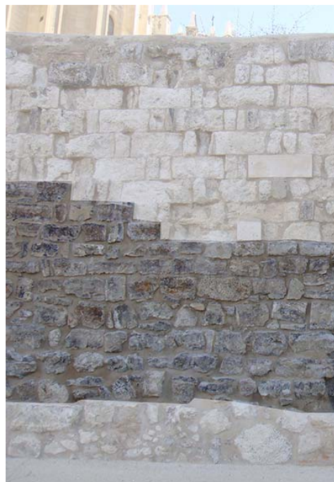
FIG.06.2. Detalle de un lienzo de Muralla, señalando el zócalo de sílex.
