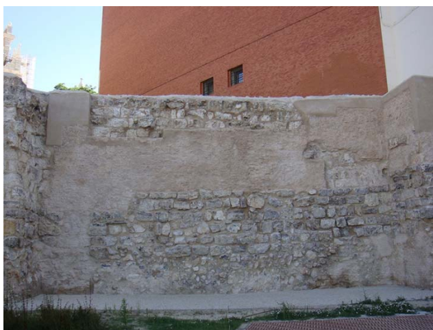
FIG.11.18. Vista de la intervención realizada en el tramo TR3.
