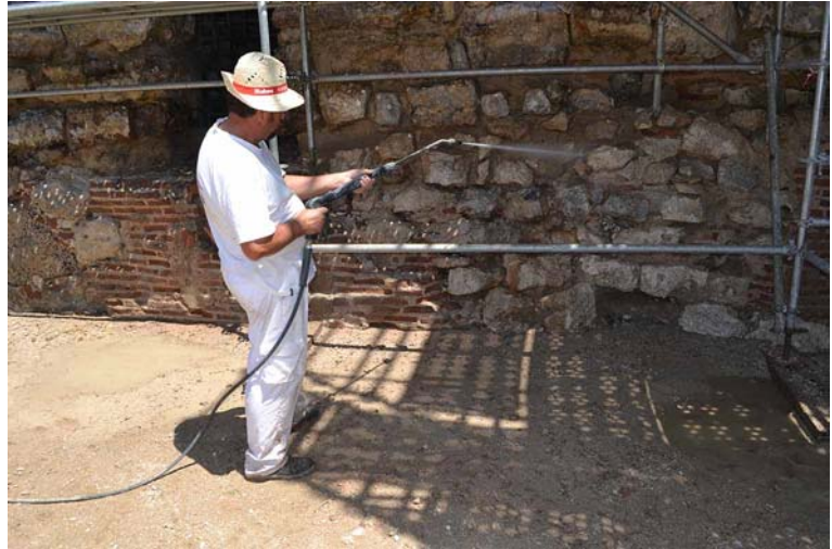
FIG.11.1. Limpieza mediante pulverización de agua destilada.
