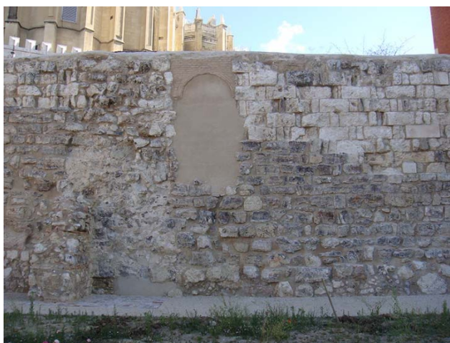
FIG.11.17. Vista de la intervención realizada en el tramo TR2.
