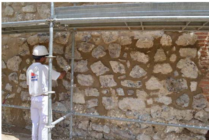
FIG.11.7. Detalle de trabajos de rejuntado en los lienzos de la Muralla.
