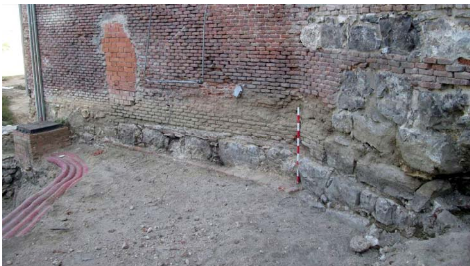
FIG.09.19. Detalle de la zona excavada para la rampa en los tramos TR4 y TR5.
