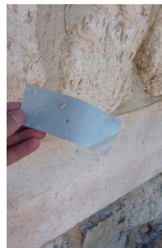
FIG.11.23. Detalle del ensayo.
