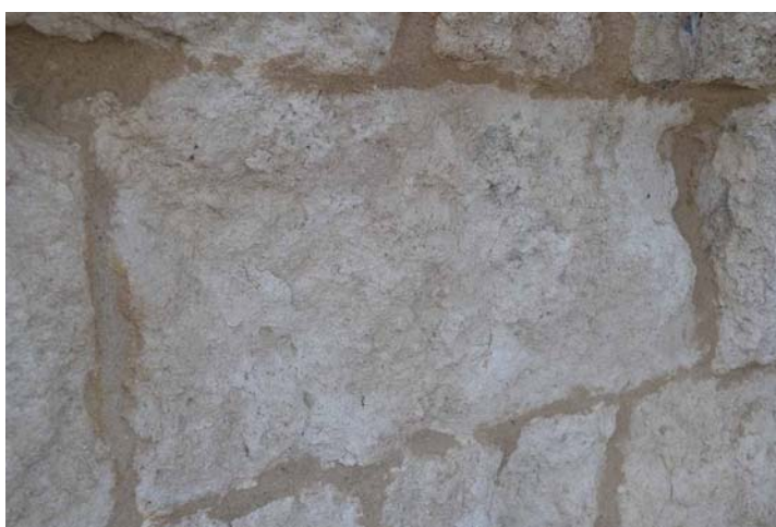
FIG.11.12. Detalle de los trabajos de rejuntado realizados.
