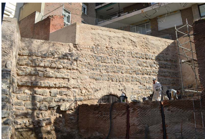
FIG.11.19. Vista de la intervención realizada en los tramos TR6 y TR7.
