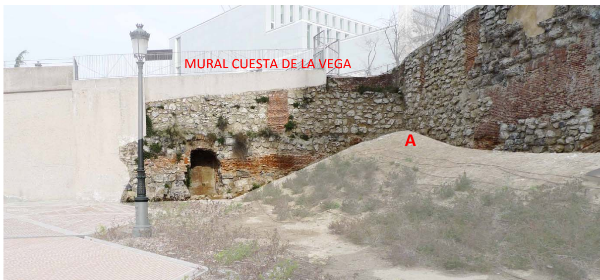
FIG.06.10. Detalle del inicio de los lienzos A-B, donde puede apreciarse la topografía recreada en la intervención anterior.
