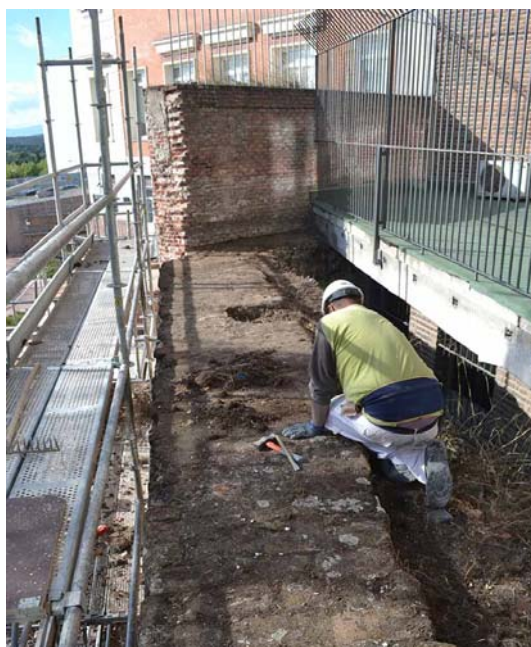
FIG.11.4. Eliminación de vegetación por medios manuales.
