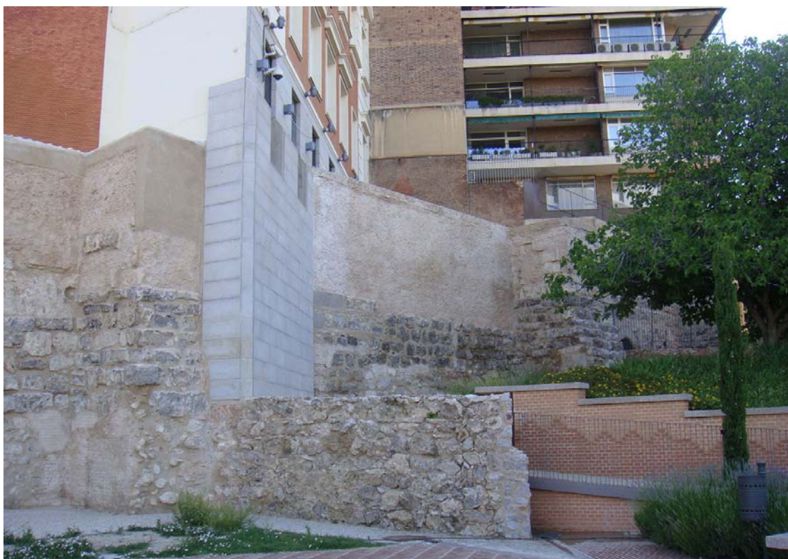
FIG.13.8. Vista general del tramo de Muralla TR5 y torre T4 tras la restauración.
