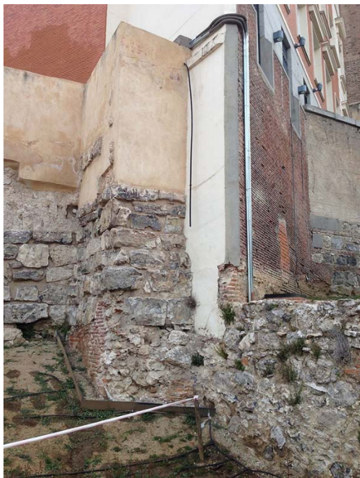
FIG.12.3. Detalle de fachada previo a la actuación.
