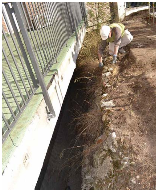
FIG.11.3. Eliminación de vegetación por medios manuales.
