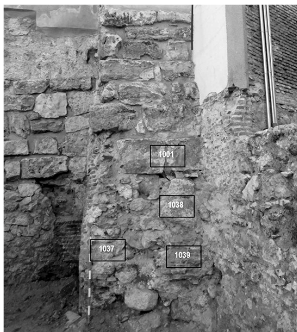
FIG.09.28. Detalle del recalce de la torre T3.
