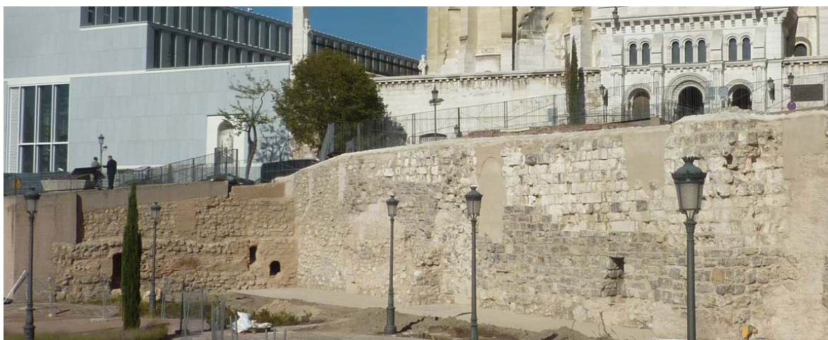
FIG.13.2. Vista general de la Muralla Árabe una vez realizadas las obras de intervención.
