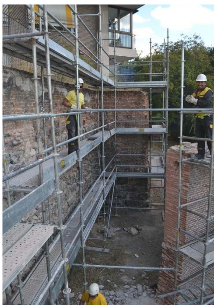
FIG.12.1. Demolición del muro lindero.
