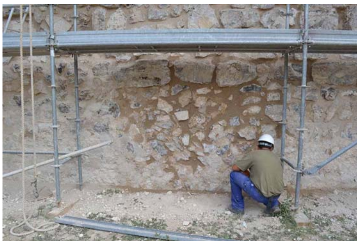
FIG.11.8. Detalle de trabajos de rejuntado en los lienzos de la Muralla.
