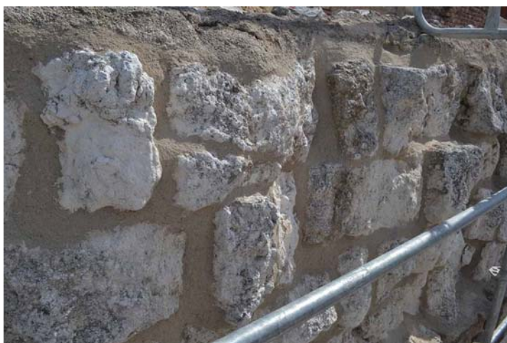
FIG.11.11. Detalle de los trabajos de rejuntado realizados.
