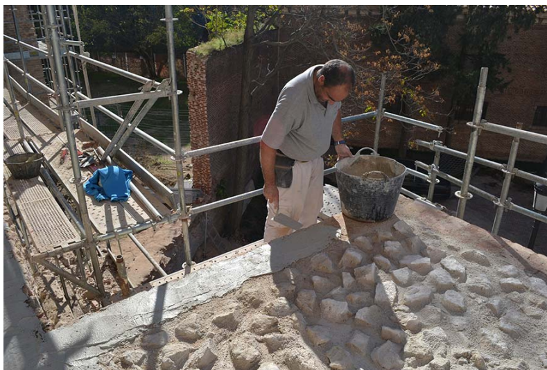
FIG.11.26. Detalle de los trabajos en la coronación de la Muralla.
