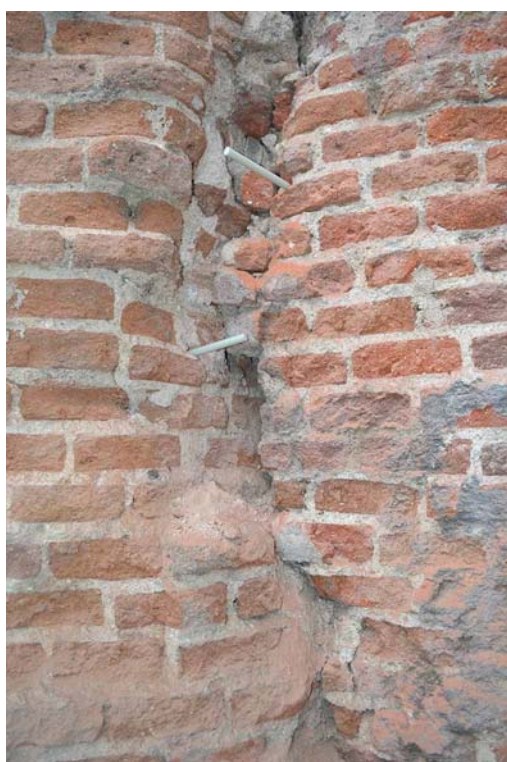
FIG.11.15. Cosido de la fábrica mediante varillas.
