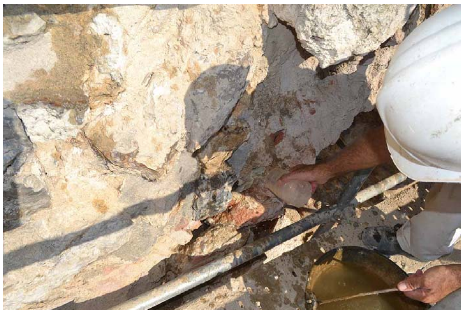
FIG.11.14. Inyección mediante vertido directo de lechada de cal hidráulica.
