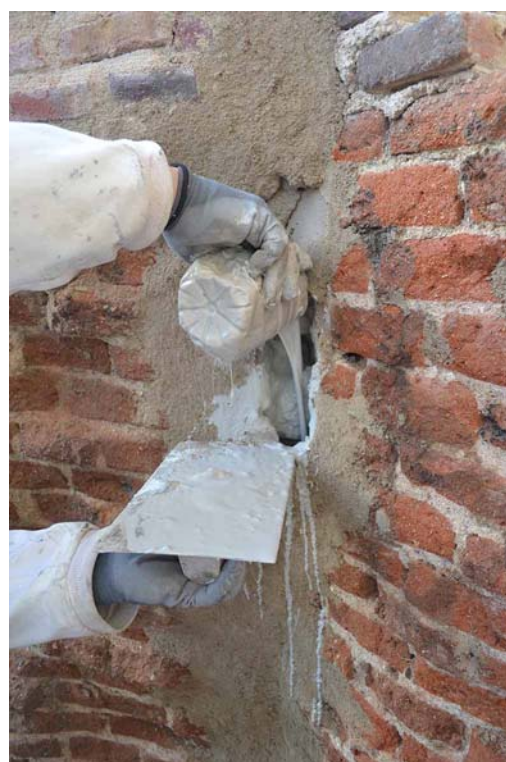
FIG.11.16. Inyección mediante vertido directo de lechada de cal hidráulica.
