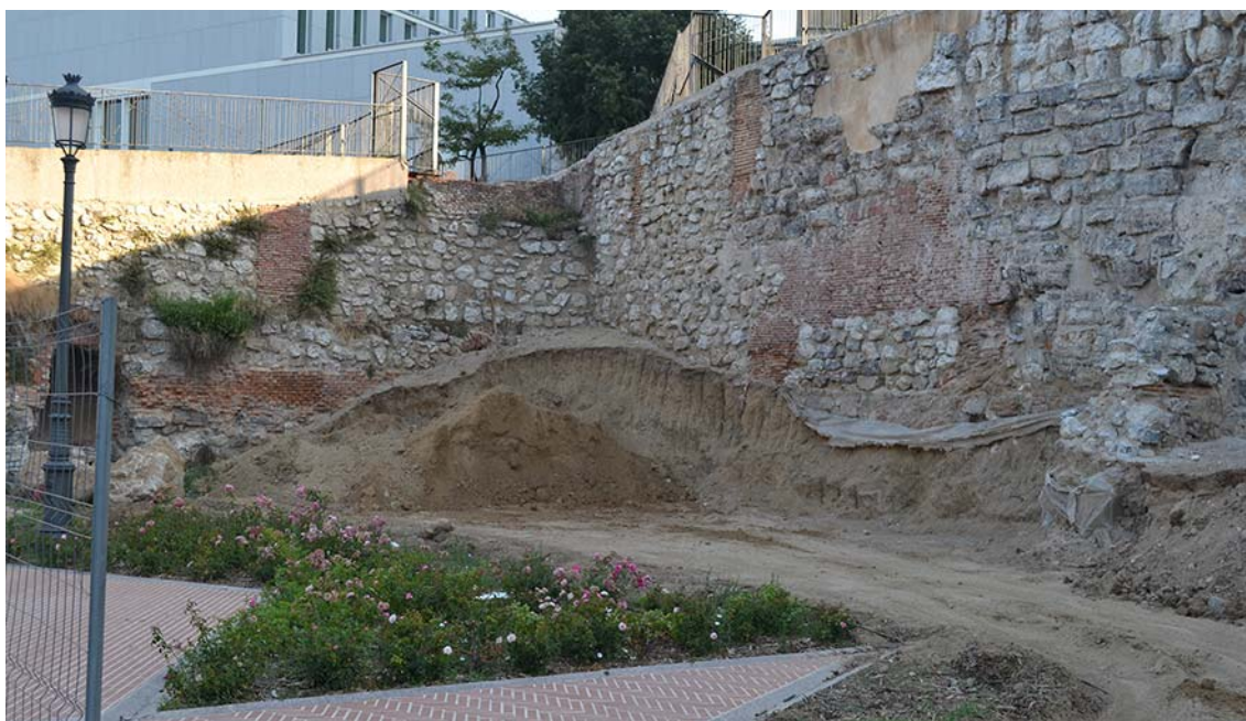
FIG.12.5. Detalle de ejecución de las labores de vaciado de tierras.
