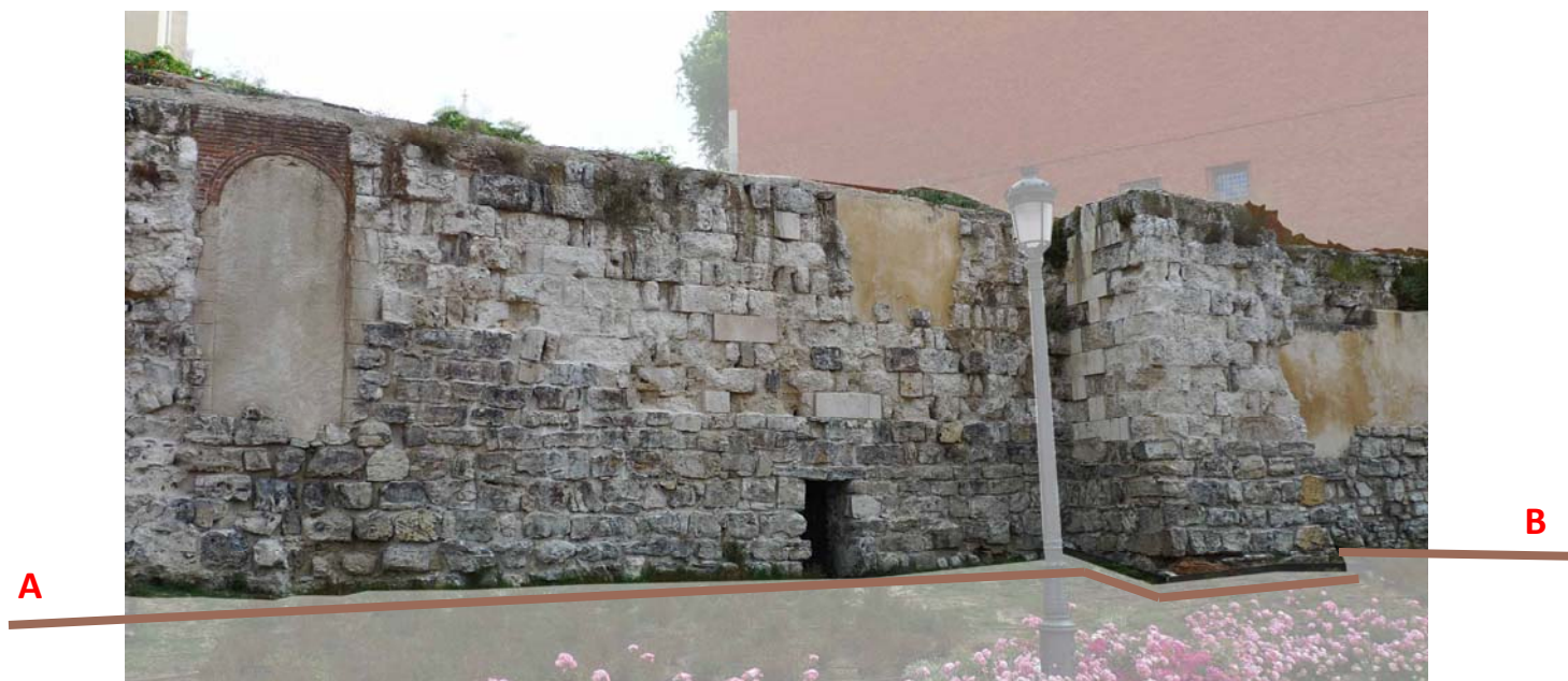
FIG.06.11. Detalle de los lienzos A-B, tramo TR2 y torre T2.
