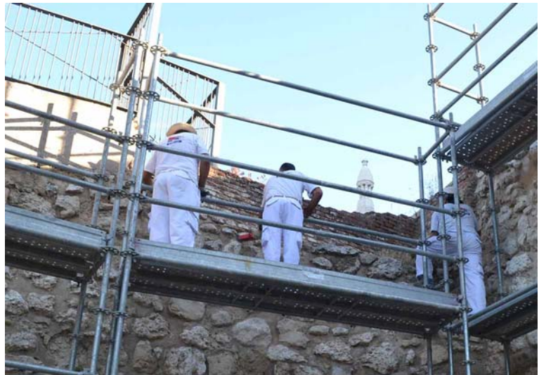
FIG.11.2. Limpieza con cepillo, previa retirada de forma manual de los restos vegetales existentes.
