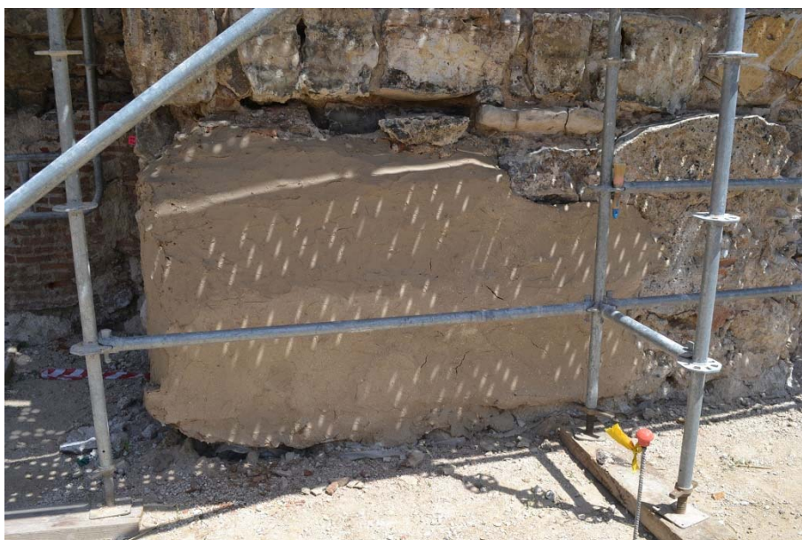
FIG.11.6. Tratamiento de eliminación de sales en la zona inferior de uno de los cubos.
