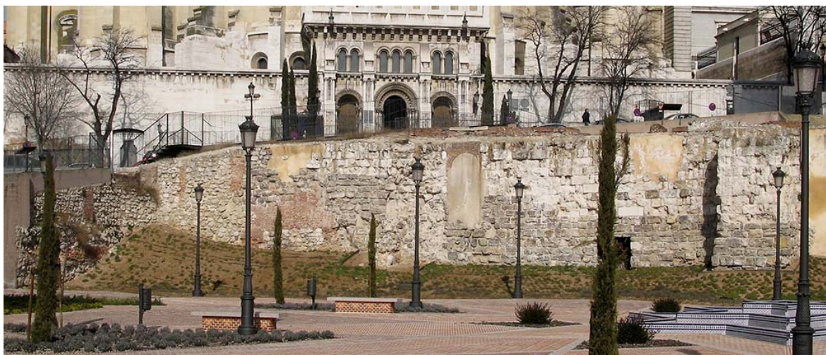
FIG.13.1. Vista general de la Muralla Árabe previa a las obras de intervención.
