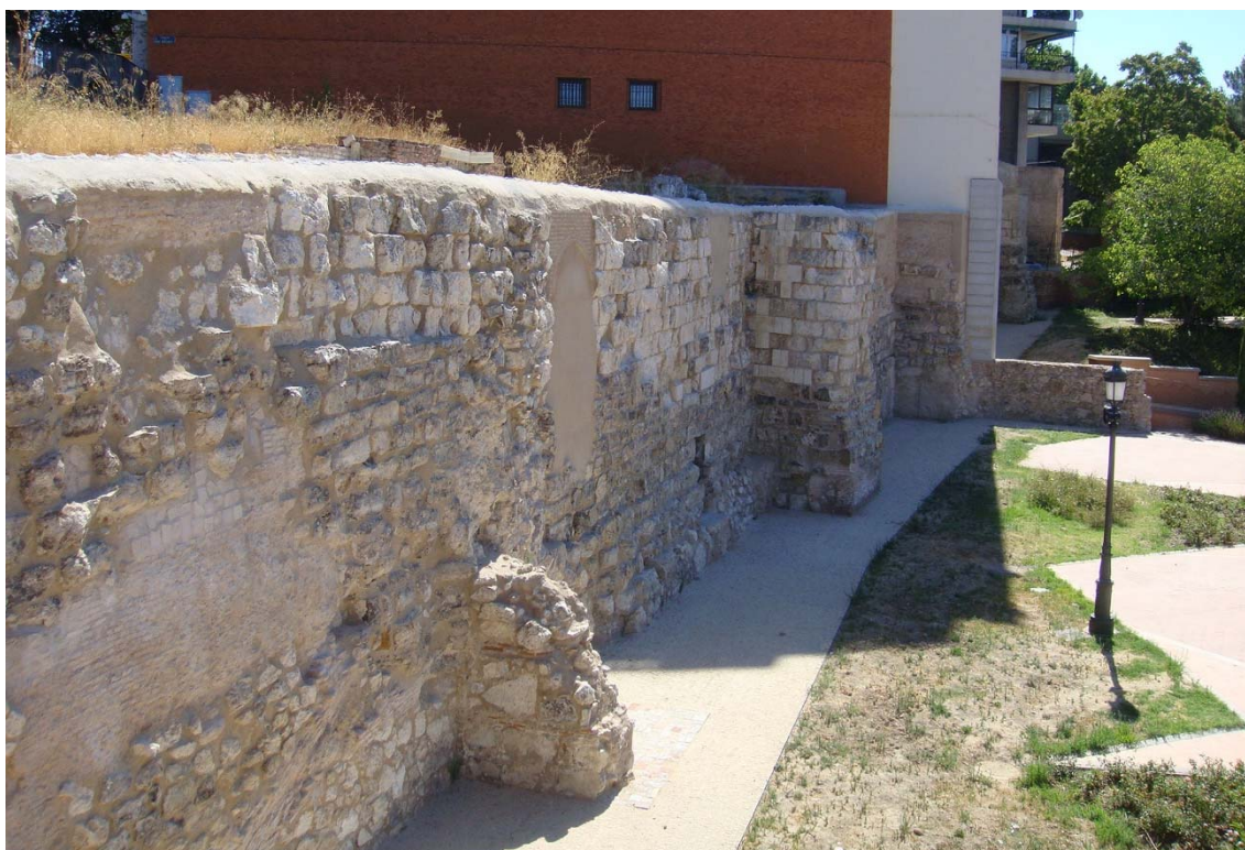
FIG.13.4. Vista general de la Muralla Árabe una vez realizadas las obras de intervención.
