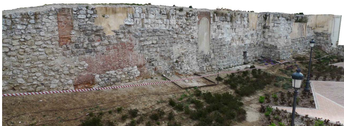
FIG.06.14. Vista general A-B.
