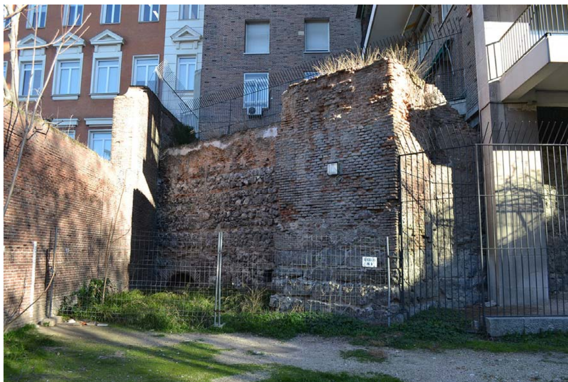
FIG.13.9. Vista general del tramo de Muralla TR7 y torre T5 previa a la intervención.
