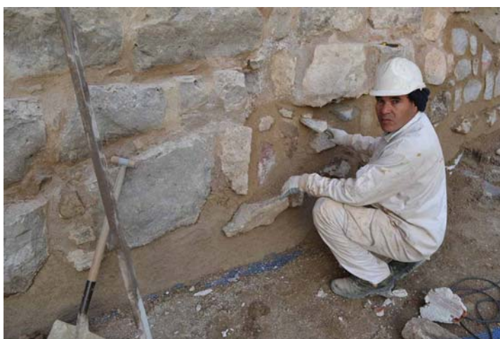
FIG.11.9. Detalle de trabajos de rejuntado en los lienzos de la Muralla.
