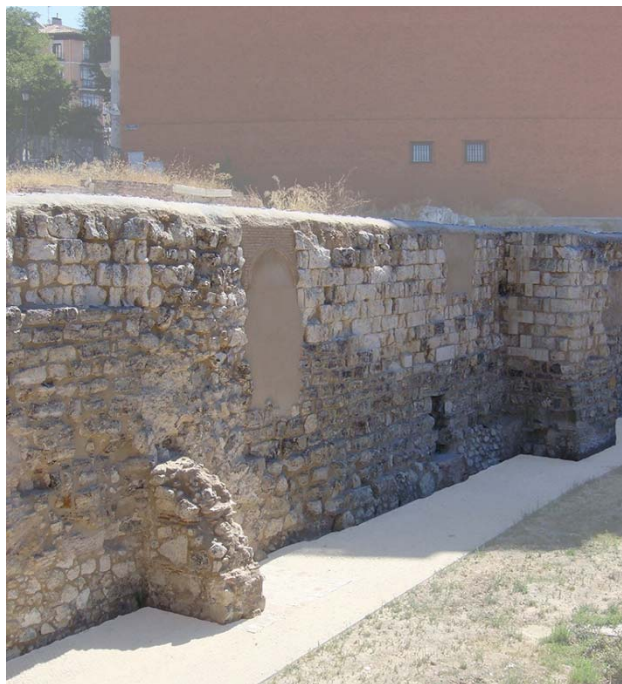
FIG.06.6. Vista del tramo TR2 entre las torres T1 y T2.
