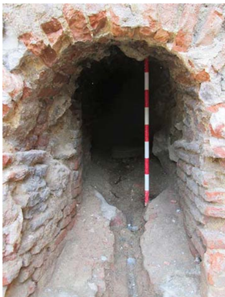
FIG.09.38. Detalle de viaje de agua (UE 4004) en su primer tramo y pasado éste bajo la Cuesta de la Vega con apertura a la derecha de ramal perpendicular.
