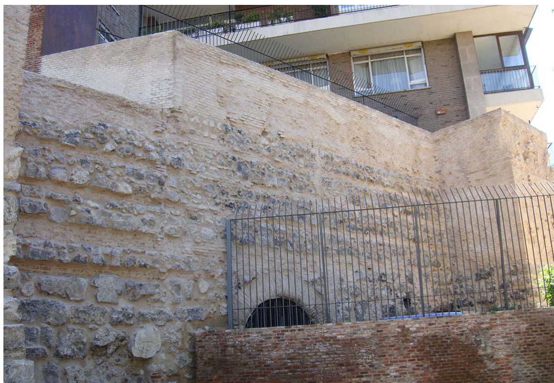
FIG.13.10. Vista general del tramo de Muralla TR7 junto al TR6 y torre T5 tras la intervención.
