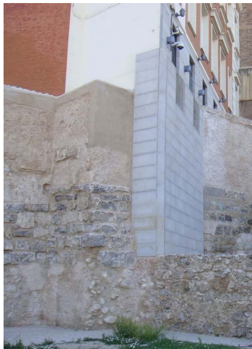
FIG.12.4. Detalle de fachada una vez intervenida.
