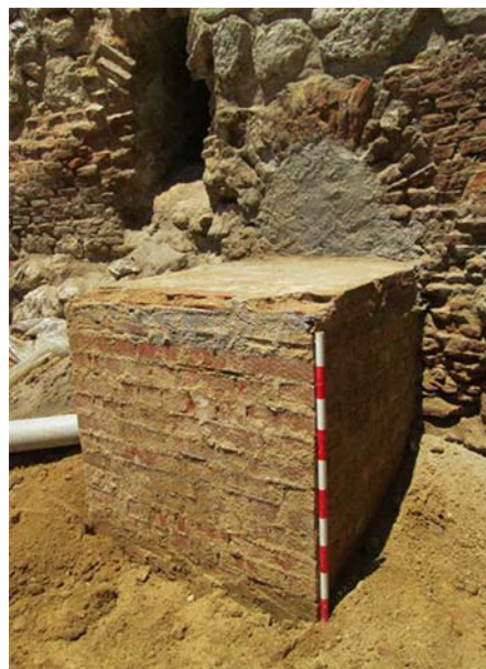
FIG.09.39. Arqueta de recogida de aguas de la restauración del año 1987-88, que se encontraba cubierta por el talud artificial. Al retirar las tierras se desmanteló y abrió el viaje de agua.
