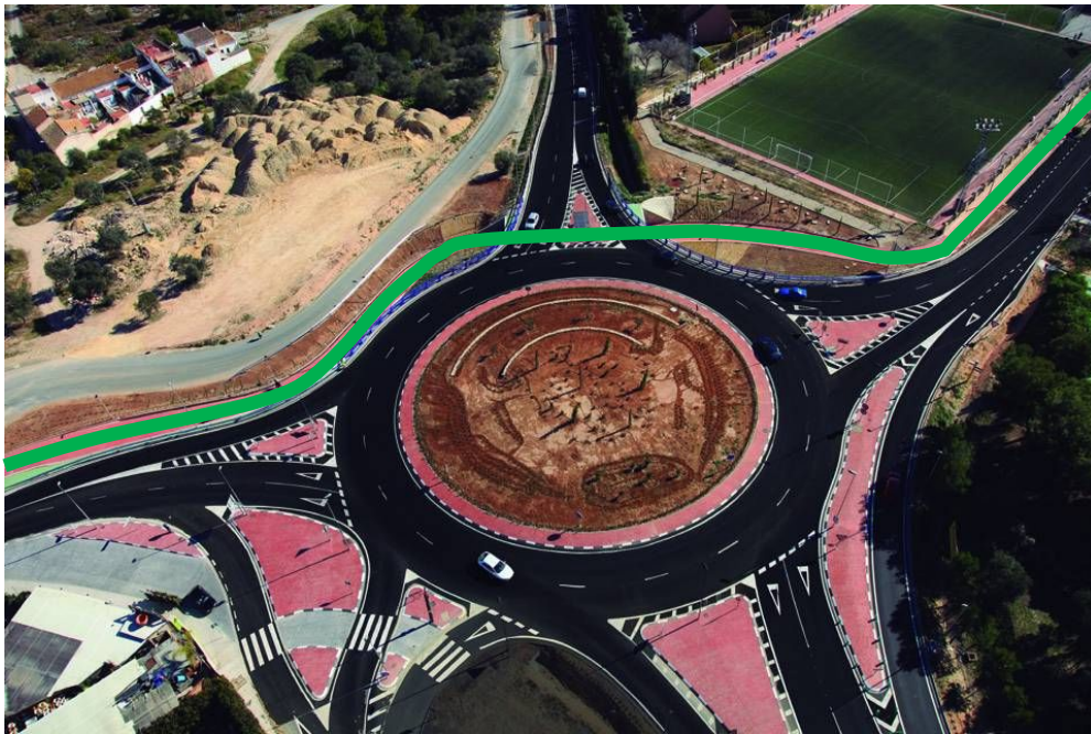
Imagen 4. Vista aérea del Acceso 1 Itinerario peatonal
