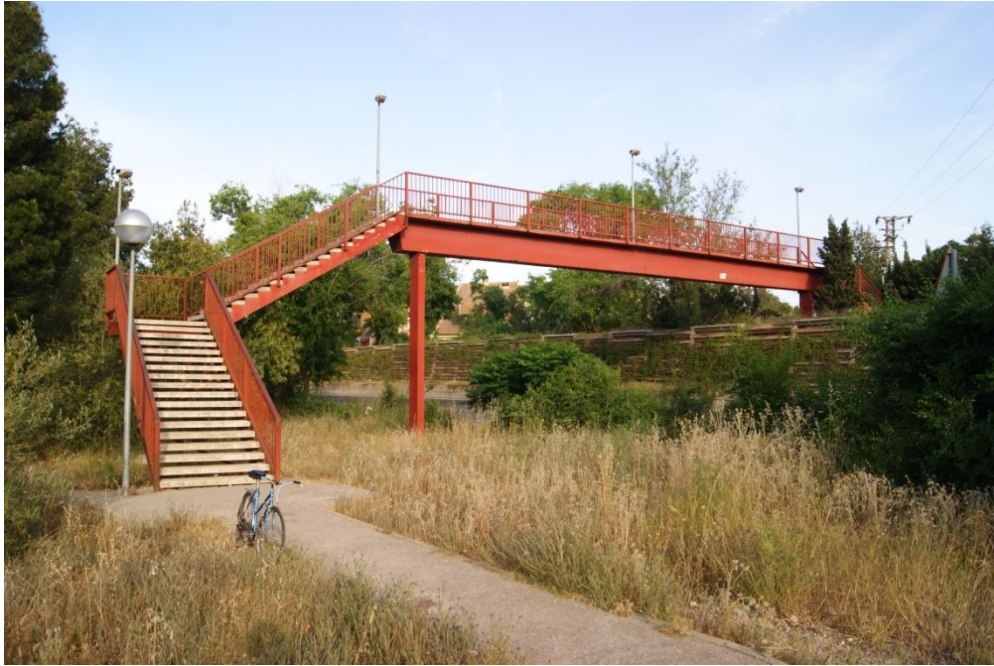
Imagen 9. Vista de la escalera desde Campolivar de la pasarela en Acceso 3
