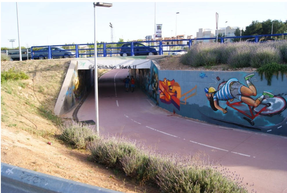
Imagen 5. Vista del paso inferior para peatones y ciclistas del Acceso 1
