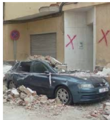
[Fig 10] Marcas tras peritación en la entrada de un bloque de viviendas en Lorca tras el terremoto de 2011.
