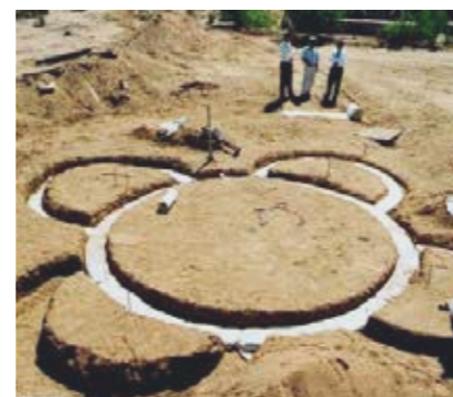
[Fig 35] Cimentación para el refugio Sandbag Shelter. [Fig 36] Levantamiento de los muros para el refugio Sandbag Shelter. [Fig 37] Estructura completa para el refugio Sandbag Shelter.
