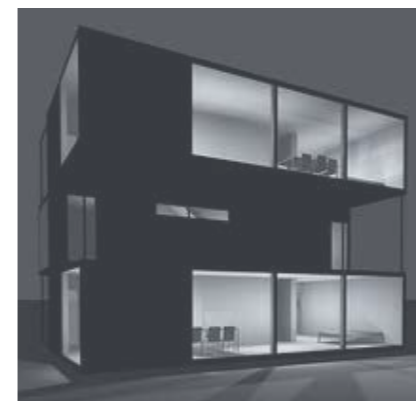
[Fig 76] Superior. Despiece montaje vivienda Sytem3. [Fig 77] Izquierda. Variación por agrupación en altura. [Fig 78] Derecha. Interior de la vivienda Sytem3 presentada en el MoMA, 2008.
