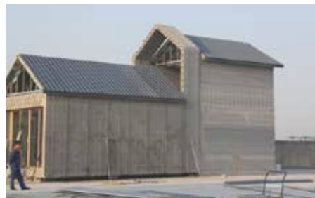
[Fig 80] Superior. Impresión por contornos en taller de los componentes prefabricados. [Fig 81] Izquierda. Montaje de las piezas prefabricadas para una de las 10 viviendas levantadas en 24h. [Fig 82] Fase avanzada de la construcción de la vivienda.
