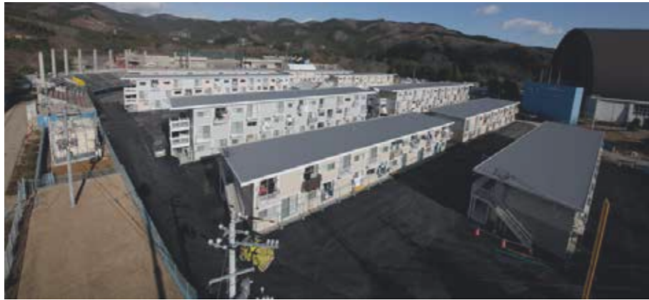
[Fig 38] Proyecto Container Temporary Housing, Onagawa Corea 2011.
