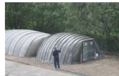
[Fig 30] Montaje Concrete Canvas Shelter, paso 1, desplegado. [Fig 31] Montaje Concrete Canvas Shelter, paso 2, inflado. [Fig 32] Montaje Concrete Canvas Shelter, paso 3, hidratación.
