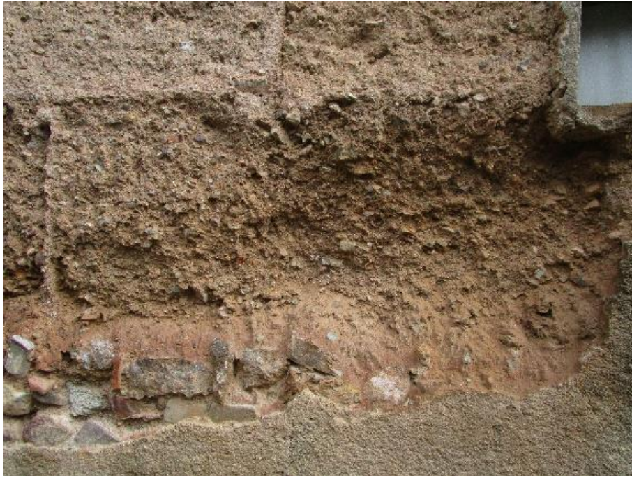
Fotografía 72. Estado final de la zona de extracción
