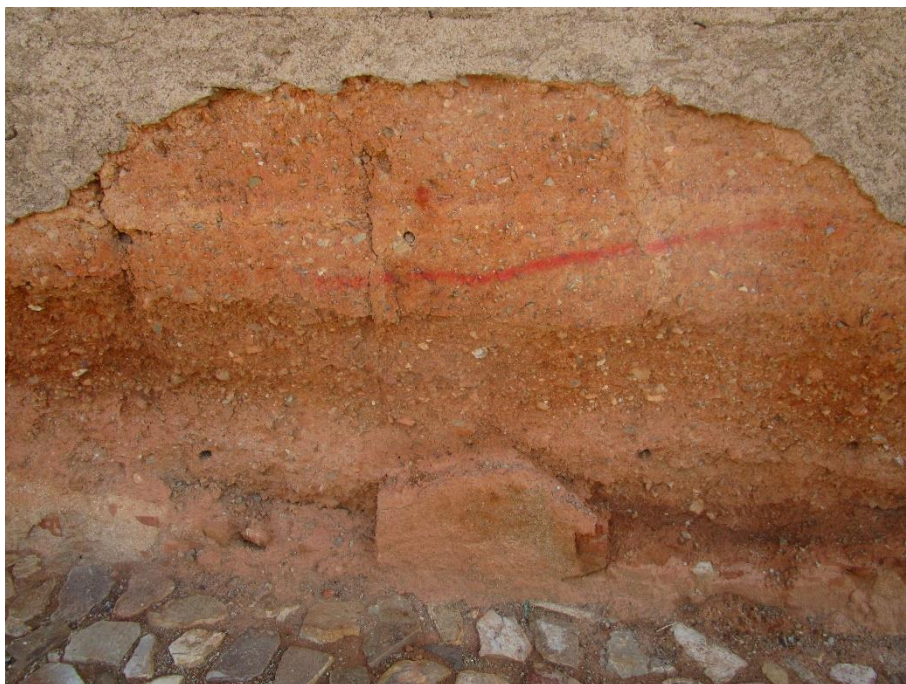
Fotografía 134. Barrera de cemento.
