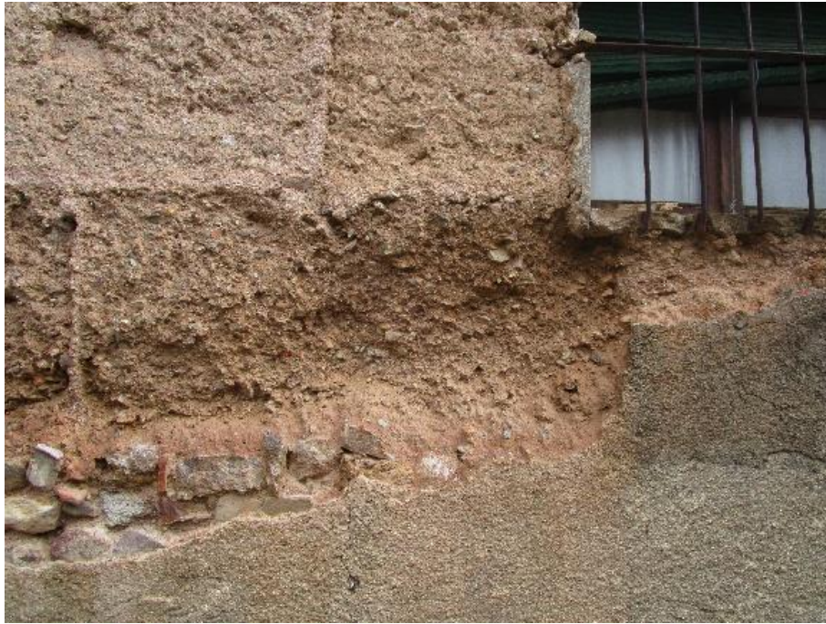
Fotografía 69. Estado inicial del muro
