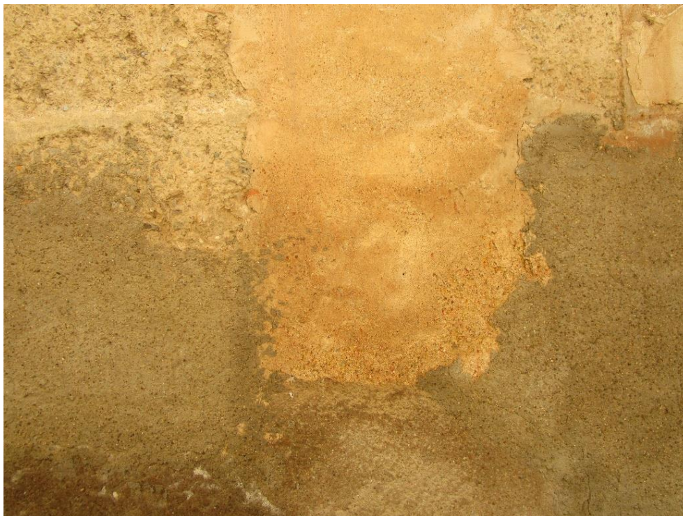
Fotografía 115. Muro con enlucido original y enlucido de cemento gris.
