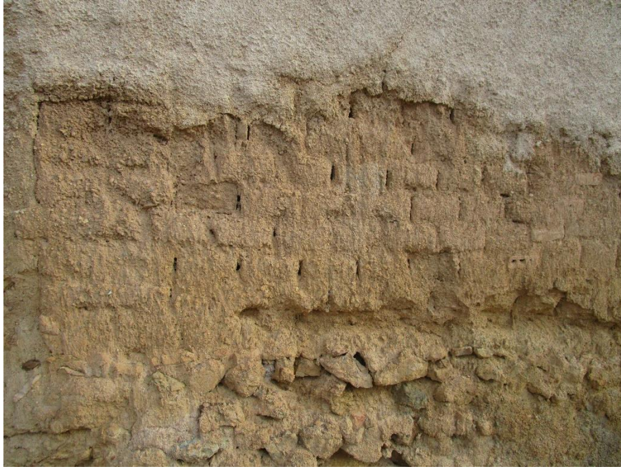
Fotografía 133. Lavado de material por efecto de la lluvia
