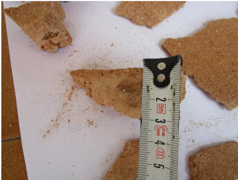
Fotografía 41. Detalle del enlucido sobre trozo de adobe
