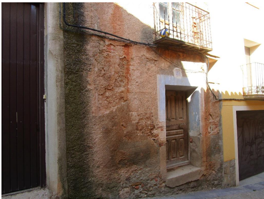
Fotografía 28. Enlucido grueso en la zona cristiana
