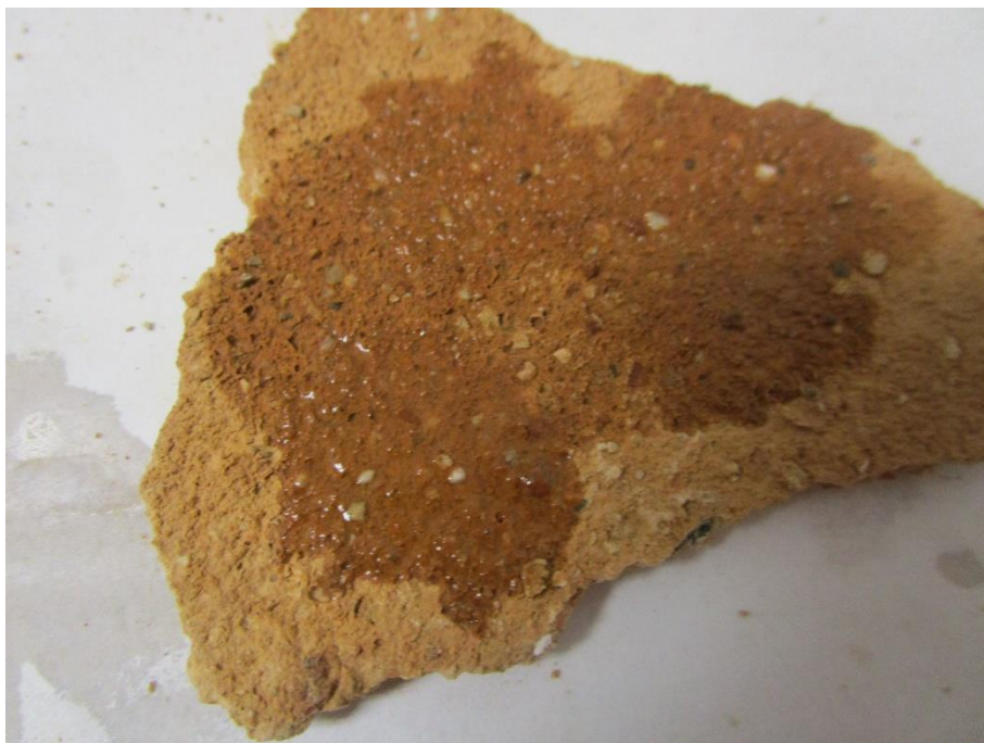
Fotografía 54. Ausencia de efervescencia en la parte exterior del enlucido
