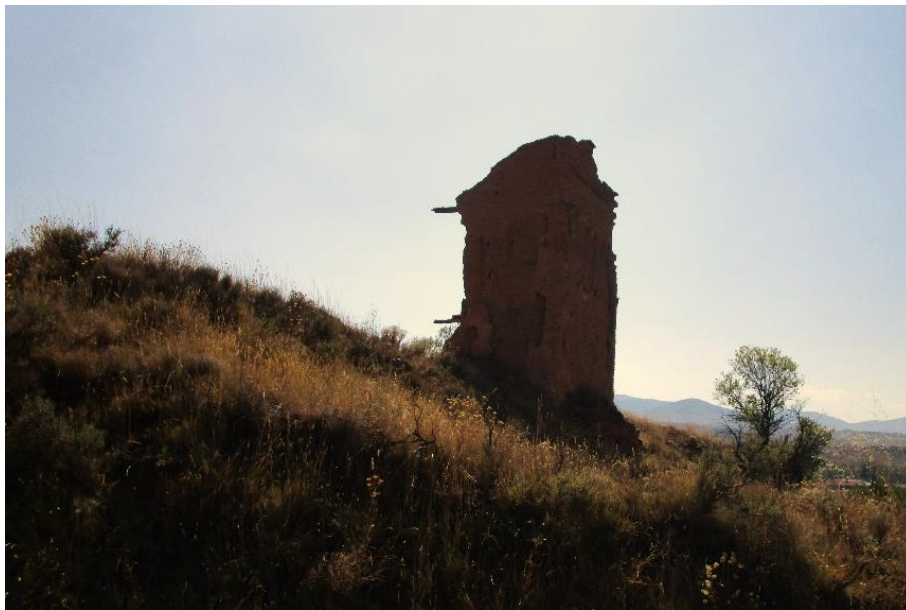
Fotografía 67. Restos de una casa realizada con tapia.
