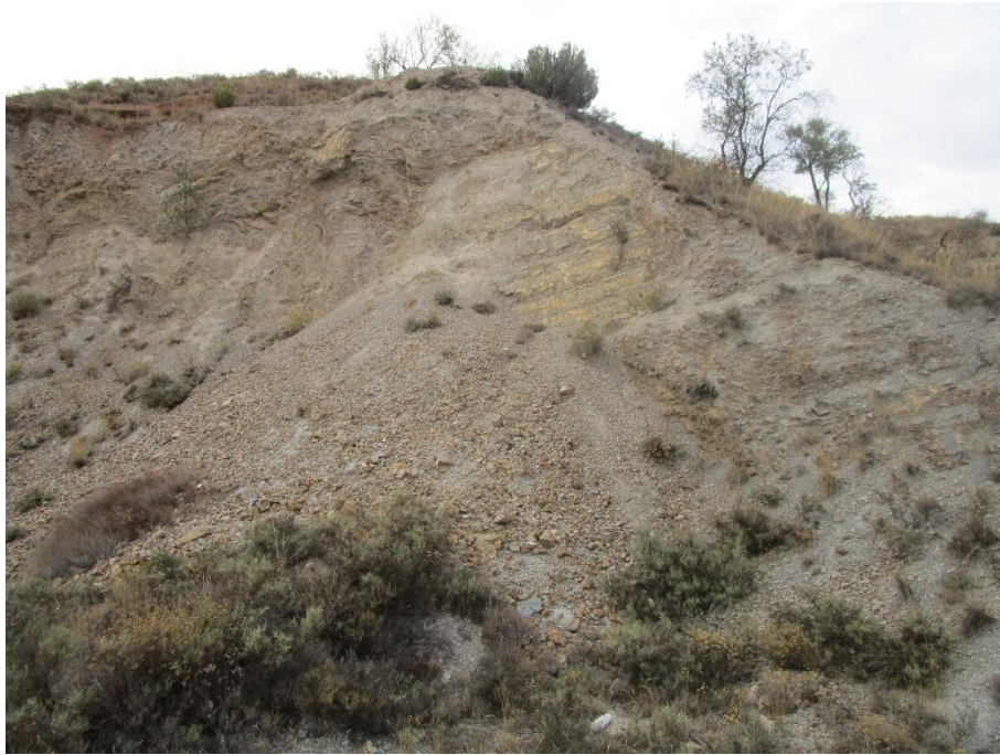
Fotografía 95. Zona donde se almacena la mezcla arrastrada por el agua.
