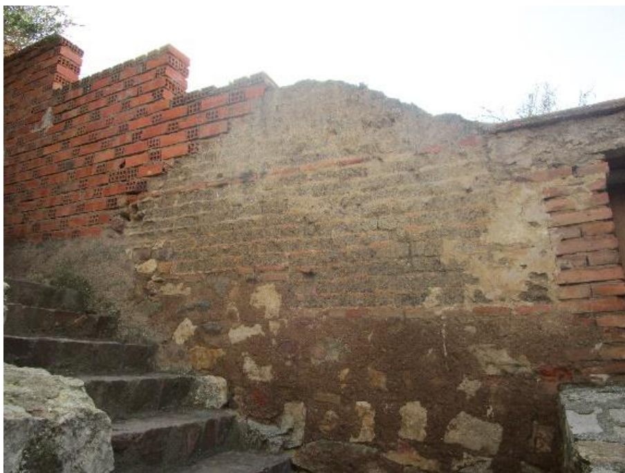
Fotografía 19. Adobe en el Barrio Árabe.
