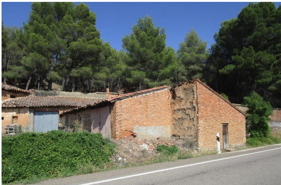
Fotografía 65. Casa realizada en algunas zonas con tapia
