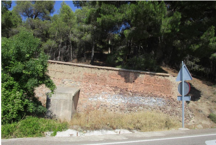
Fotografía 66. Muro realizado con tapia
