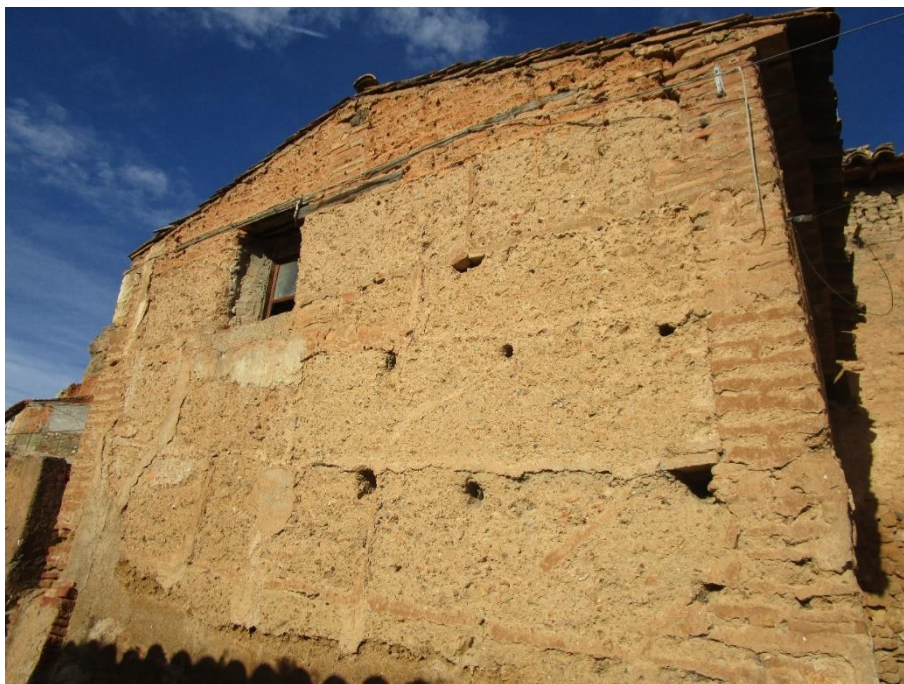
Fotografía 35. Esquinas con ladrillos
