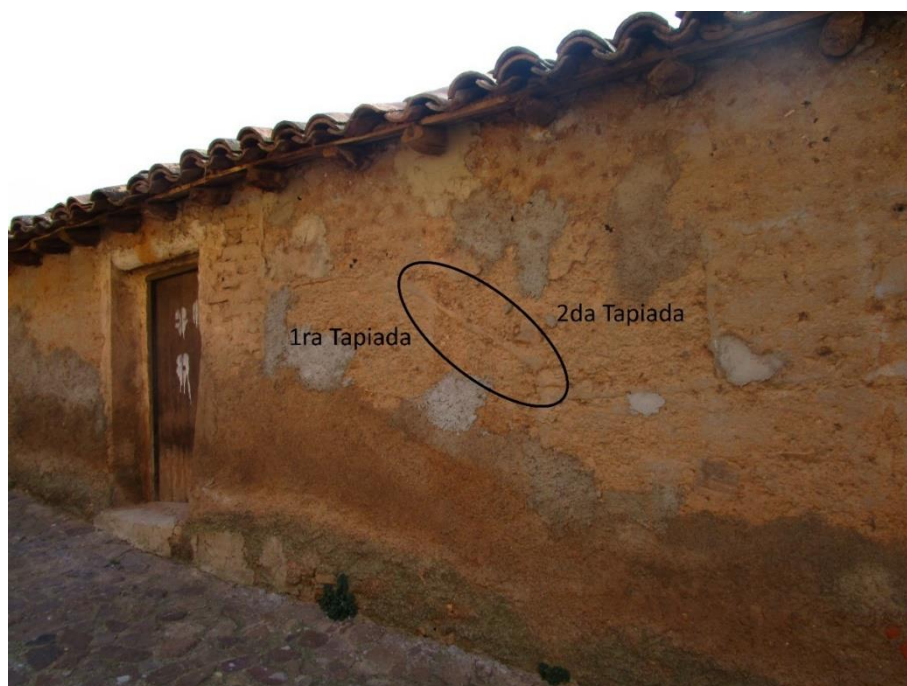
Fotografía 34. Caso en el que la frontera queda abierta y se deja una junta de tapiado inclinada.
