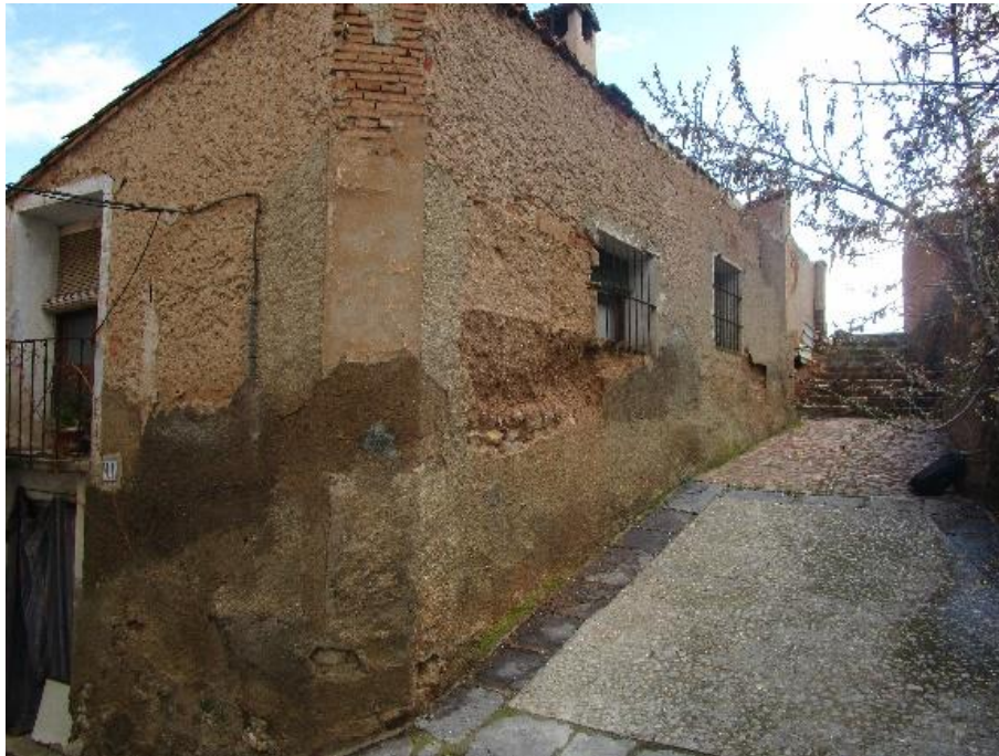
Fotografía 68. Fotografía para documentar la construcción
