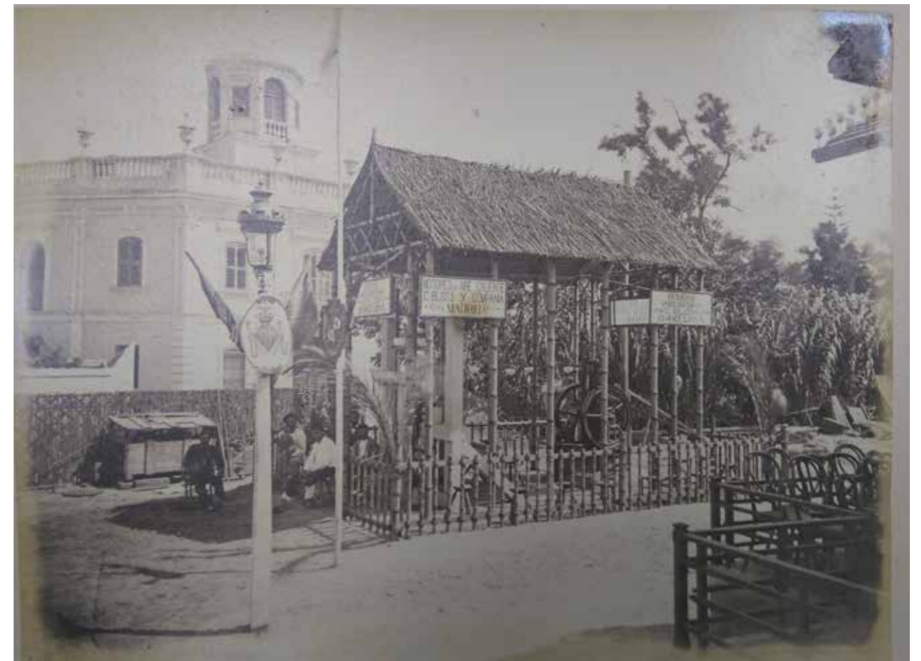
Imagen 445: Instalación de Motores de Aire Caliente C. Bloss y Compañía de Madrid. Álbum de Fotografías.. ARSEAPV.
