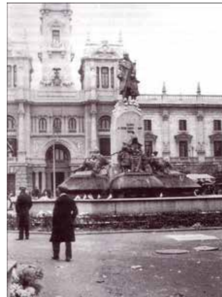
Imagen 310: Plaza de Emilio Castelar en Valencia, fuente dedicada al Marqués de Campo.
