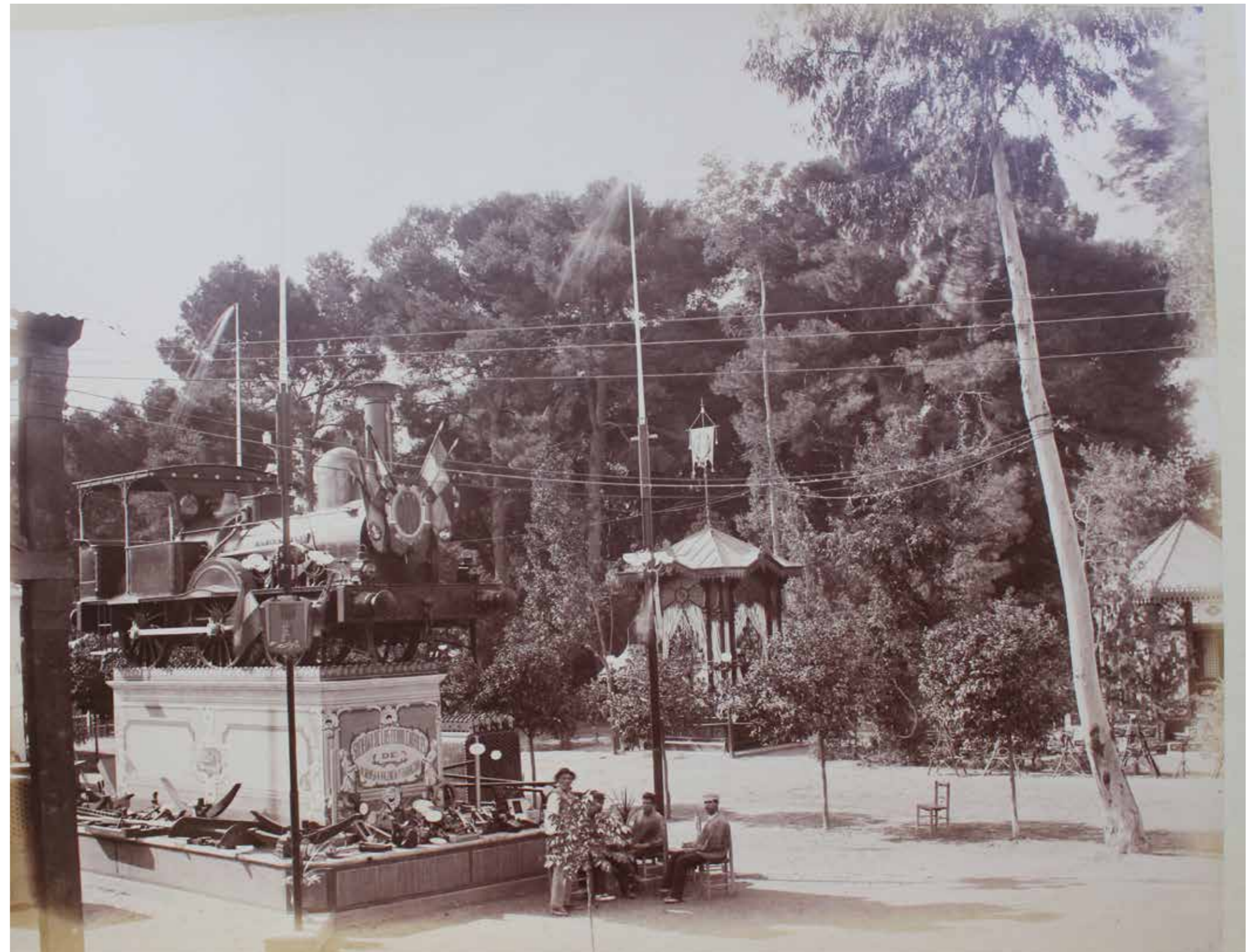
Imagen 501: Vista de la instalación de la sociedad de ferrocarriles de Almansa, Valencia y Tarragona. A la derecha de la imagen los pabellones de la Casa Hospicio provincial de Nuestra Señora de la Misericordia y el Pabellón de los Señores Colomina y Domínguez . Álbum de fotografías de la Exposición Regional de 1883. Archivo de la RSEPV.
