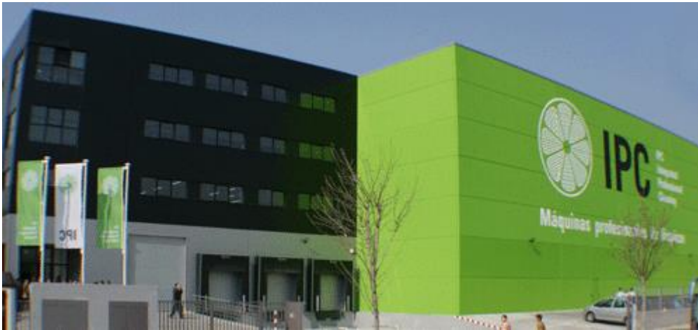
Ilustración 2 Instalaciones en Santa Perpetua de Mogoda
