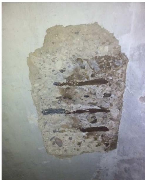
**Figura 41. DETALLE PÉRDIDA DE HORMIGÓN Y ARMADURAS OXIDADAS EN FORJADO CUBIERTA ACCESO CALLE SERRANOS. FOTOGRAFÍA D.S.R.**
