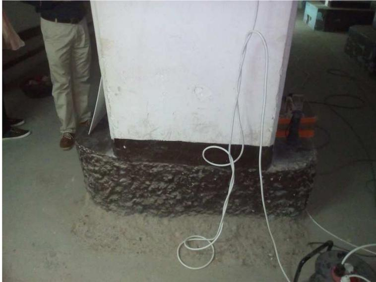
**Figura 39. DETALLE ZAPATA PILAR DEMOLIDA PARCIALMENTE. FOTOGRAFÍA D.S.R.**
