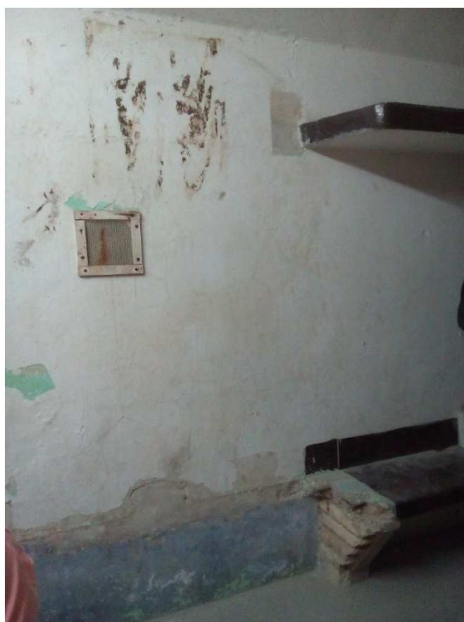
**Figura 38. DETALLE MURO LATERAL, REJILLA VENTILACIÓN, BANCO CORRIDO Y BANDEJA. FOTOGRAFÍA D.S.R.**
