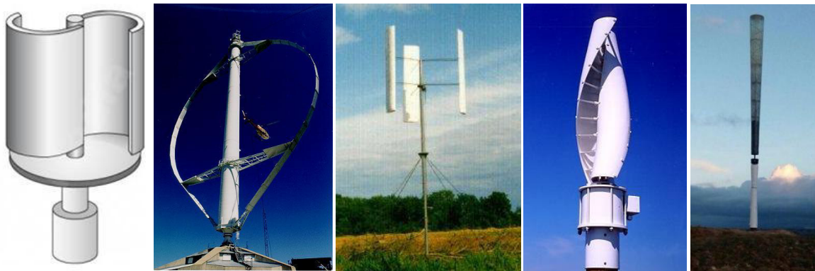
Imagen 6.15. Tipos de aerogeneradores. De izquierda a derecha: Savonius, Darrieus, Giromill, Windside, Vortex.
