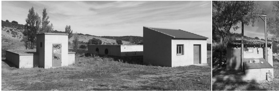
Imagen 4.1. Depósitos y pozo
