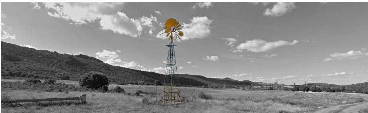
Estación bombeo término municipal Peracense –a 4km del núcleo urbano Villar del Salz-
