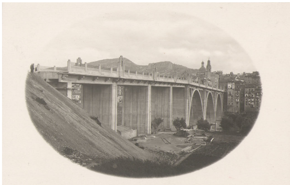
Figura 7. Vista histórica desde el estribo izquierdo con terraplén de acceso sin terminar (fotografía del Archivo Municipal de Alcoy).
