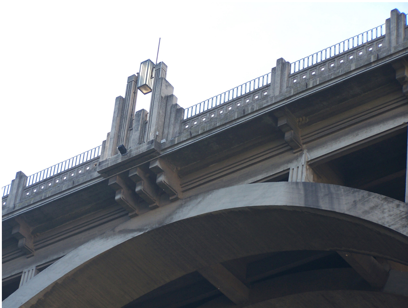
Figura 6. Columna decorativa sobre clave de los arcos (fotografía de la colección del autor).
