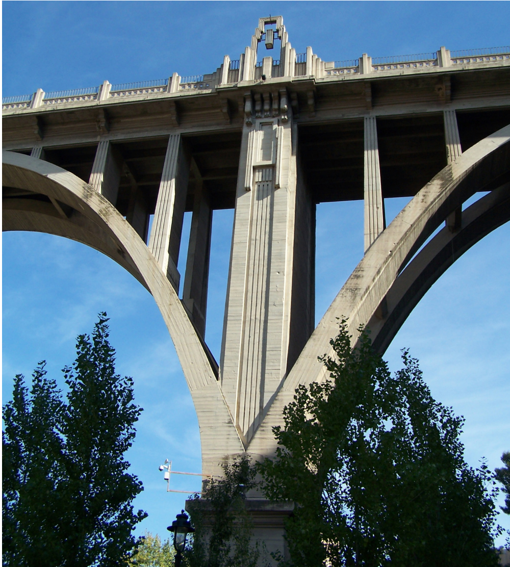
Figura 5. Pila central entre dos arcos (fotografía de la colección del autor).
