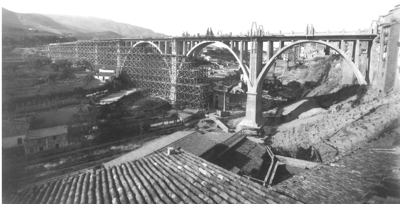
Figura 3. Puente de San Jorge con su cimbra en proceso de desmonte (fotografía del Archivo Municipal de Alcoy).
