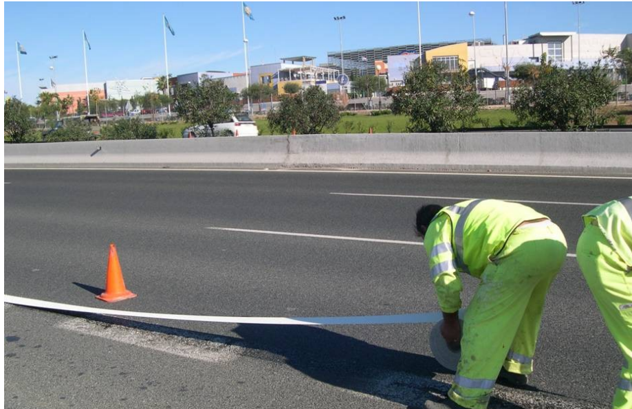
Figura 92: Utilización de cinta para la señalización provisional
