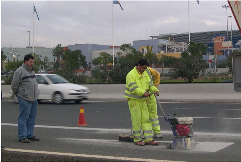
Figura 94: Fresado de la señalización existente
