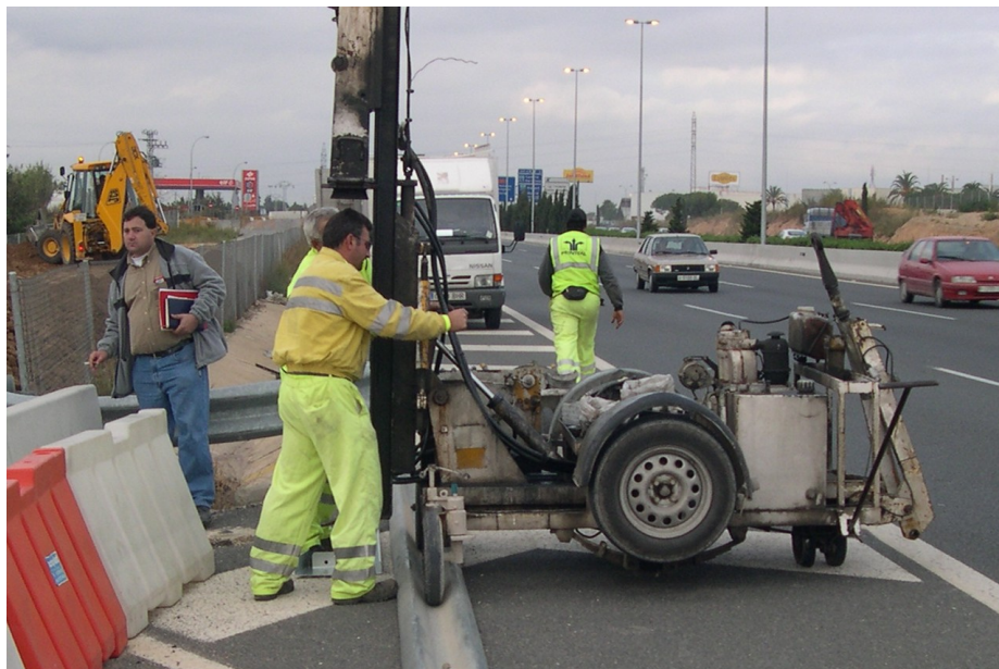
Figura 93: Colocación de la barrera de seguridad
