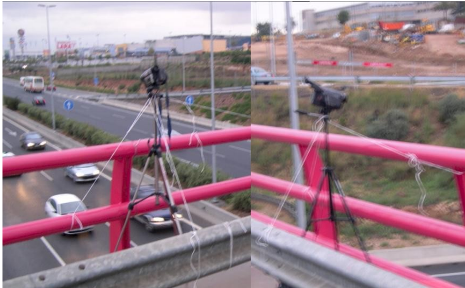
Figura 97: Ubicación de cámaras en el puente
