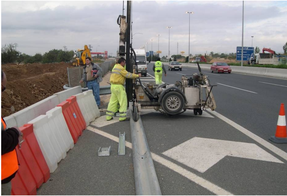
Figura 89: Colocación de bionda
