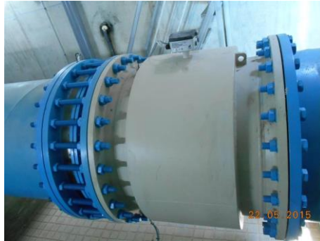
Figura 33. Caudalímetro electromagnético. Fuente: elaboración propia, 2015
