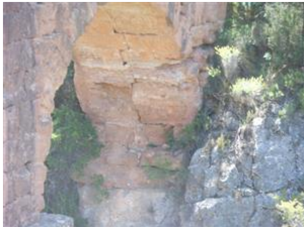
Figura 45. Vista del apoyo del arco sobre roca.
