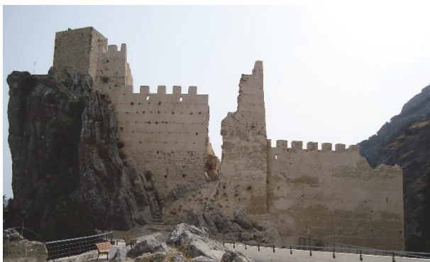
Figura 9. Estado actual de la muralla oeste tras la intervención donde se aprecia la recuperación de las almenas, y el mantenimiento del perfil original de la coronación en las zonas más degradadas.
