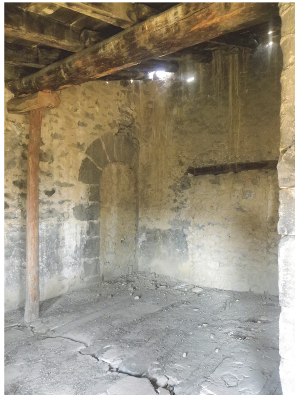
Figura 4. Foto del vano de acceso a la torre desde el edificio contiguo en Torre Camañes —Cantavieja—.
