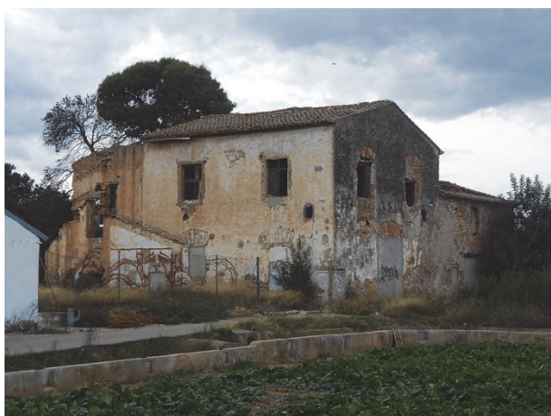
Figura 1. Vista general de la Alquería del Pollastre (Gómez Patrocinio, F. J.).
