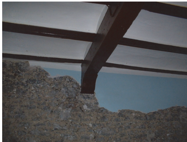
Figura 8. Mampuesto original de los muros de la Sala Noble.
