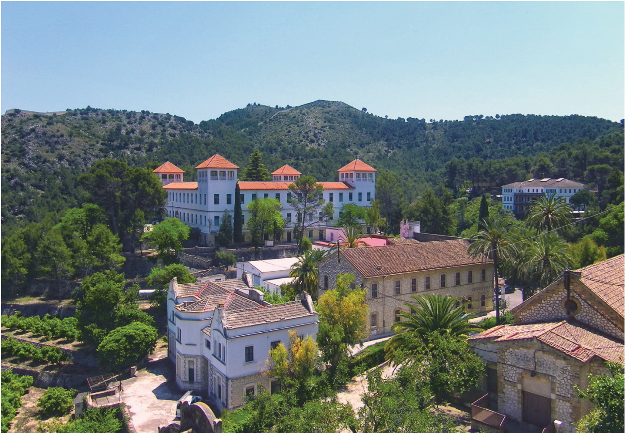
Figura 1: Vista general del Sanatorio de San Francisco de Borja de Fontilles. Estado actual año 2015.
