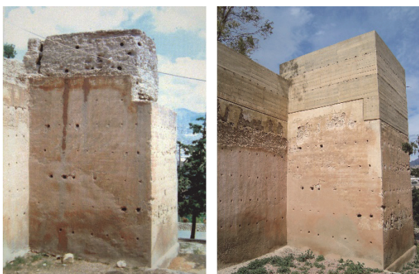
Figura 2. Imágenes de una de las torres antes y después del realizado durante 2001-2002. (Iz: imagen del expediente 00-0012-PA.).
