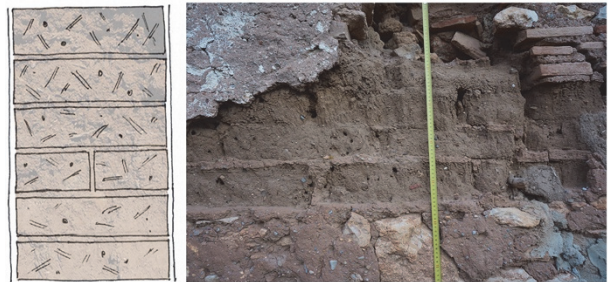
Figura 9. Detalle de un muro de adobe (C. Cazorla)
