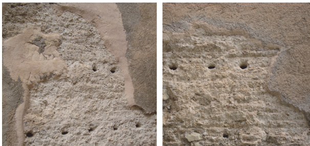
Figura 4. Imagen actual de la muralla exterior del castillo.
