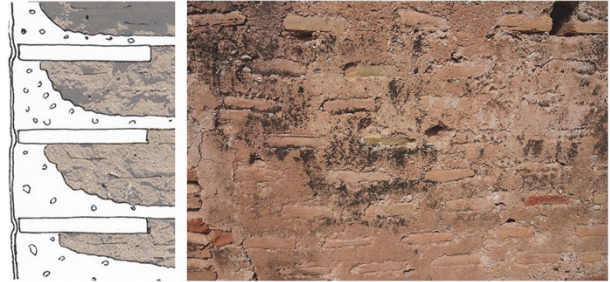
Figura 6. Detalle de un muro de tapia valenciana tipo I (C.Cazorla)
