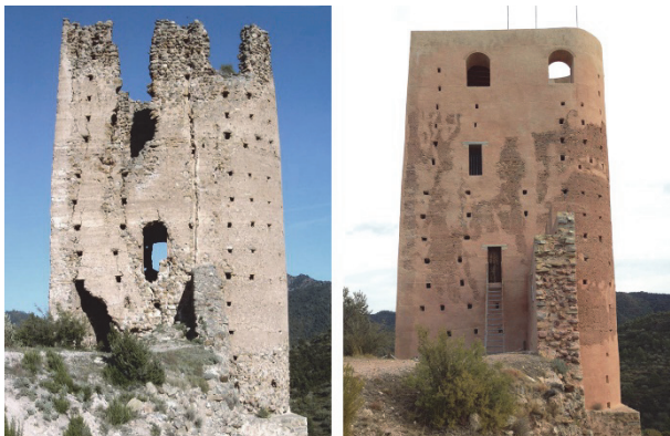
Figura 8. Iz: Imagen de la torre antes de la intervención (web del Ministerio de Fomento). Der: Imagen después de la intervención.
