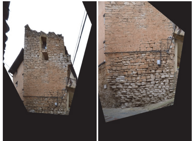
Figura 6. Imágenes rectificadas tras toma de puntos con estación total.
