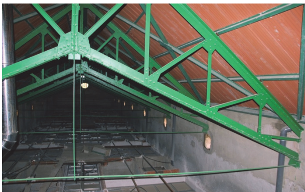
Figura 7: Estructura metálica y sistema constructivo cubierta actual. Año 2015.
