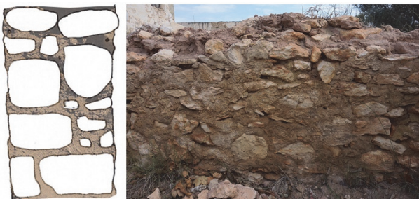
Figura 11. Detalle de un muro con mortero de tierra y mampostería (C.Cazorla)
