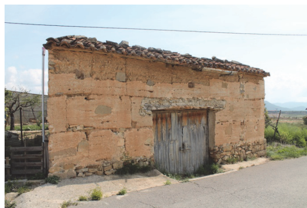
Figura 3. Tapia caliscostrada careada con mampuestos de piedra colocados en el centro del módulo. Campo de Arriba
