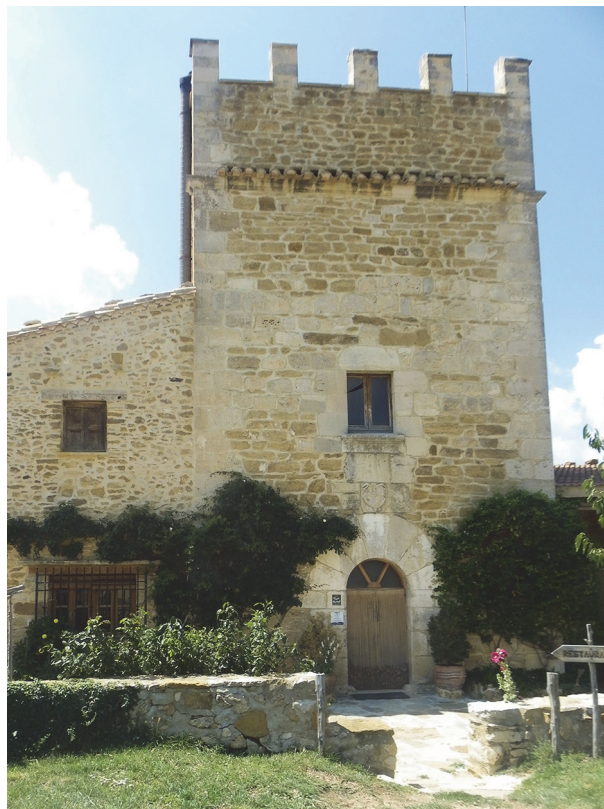
Figura 5. Torre Montesanto —Villarluengo— muestra características propias de la arquitectura civil renacentista.
