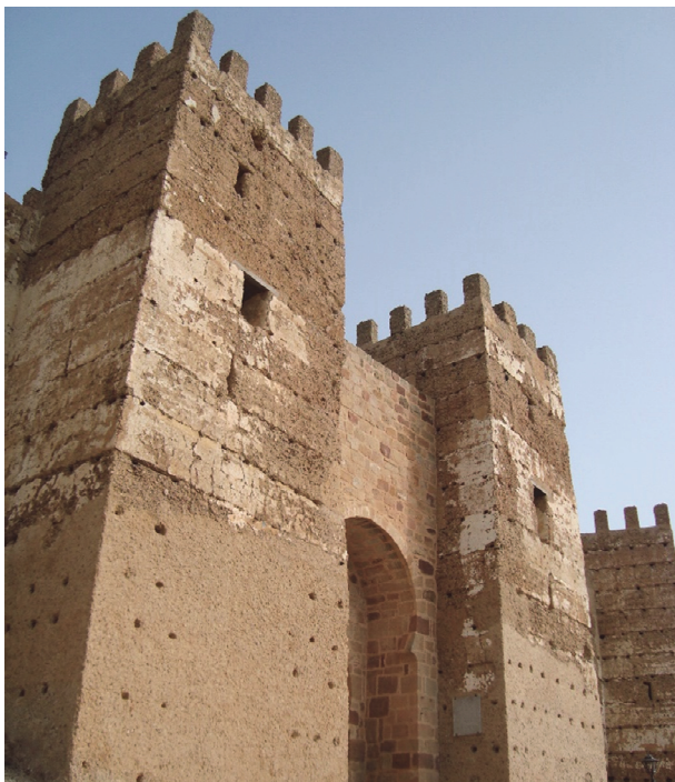
Figura 5. Imagen actual del acceso en la que se puede ver la intervención realizada en las bases de los torreones en 1997.
