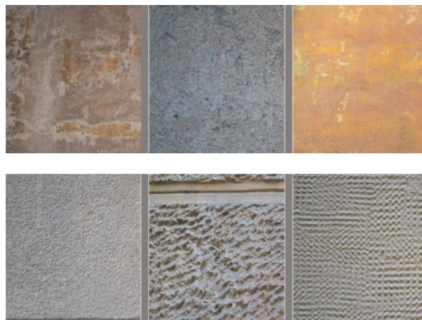
Figura 10. Principales acabados superficiales de los revestimientos del centro histórico de Valencia (V. La Spina)
