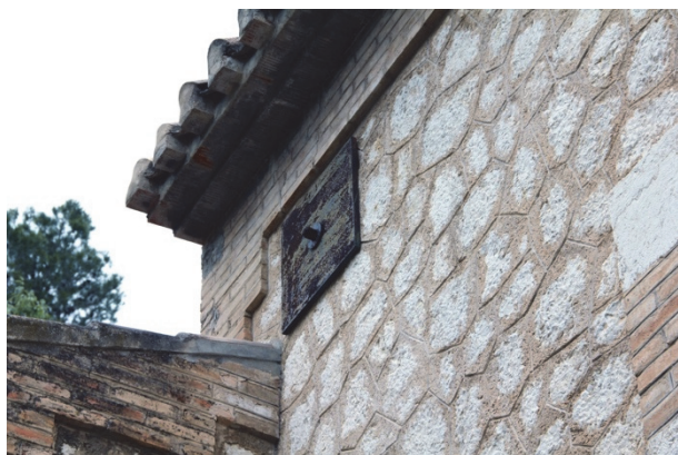
Figura 5: Tirantes estructurales. Estado actual año 2015.
