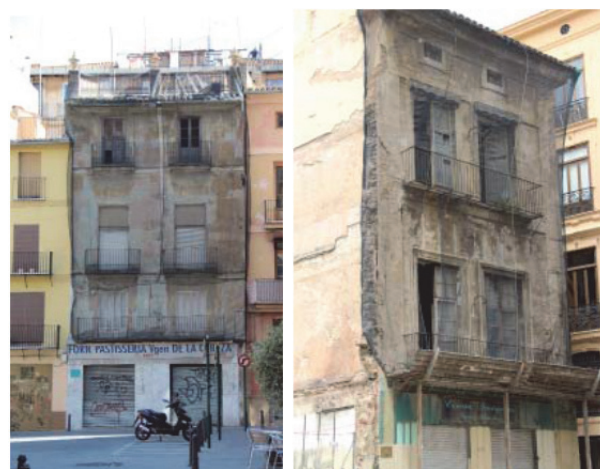
Figura 5. Edificio abandonado que conserva su revestimiento continuo histórico en la plaza de la Congregación de Valencia, a la izquierda y el edificio del Reloj al lado de la catedral de Valencia en similares condiciones a la derecha (V. La Spina)
