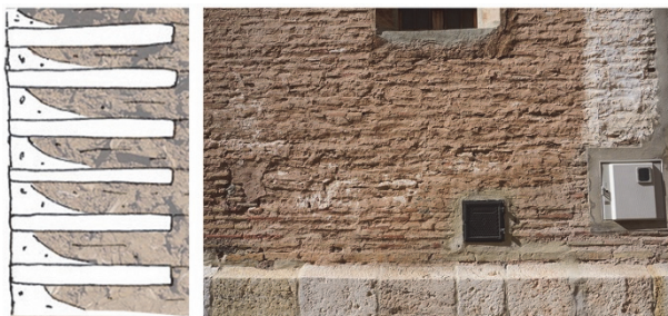
Figura 8. Detalle de un muro de tapia valenciana tipo III (C. Cazorla)
