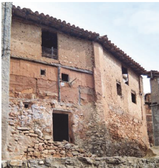
Figura 7. La viga que se ha podido datar en el año 1725 es la que se ve dispuesta horizontalmente en la fachada.
