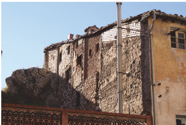
Figura 4 Edificio situado en Montalbán. (Autor: Villacampa Crespo, L.)
