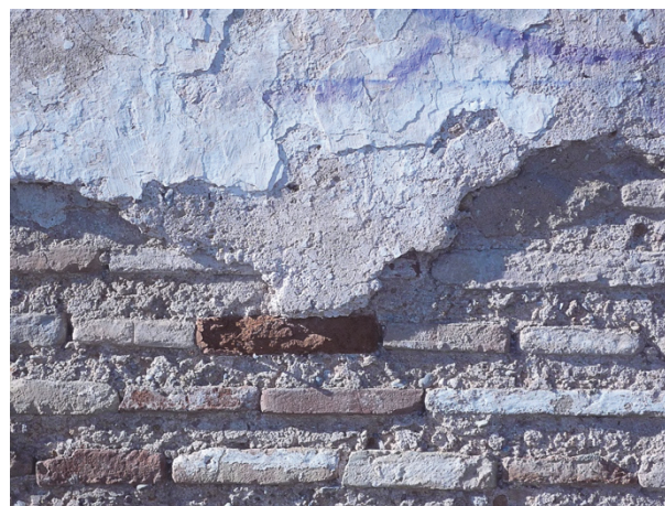
Figura 3. Detalle de la tapia valenciana en la fachada del edificio principal de la Alquería del Pollastre (Gómez Patrocino, F. J.).
