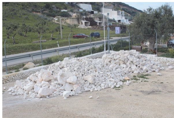
Figura 5. Acopio de piedra caliza para construcción de horno en Morón de la Frontera.
