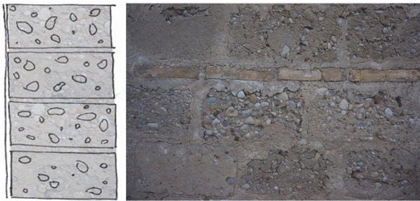
Figura 10. Detalle de un muro de bloque conglomerante-tierra (C.Cazorla)
