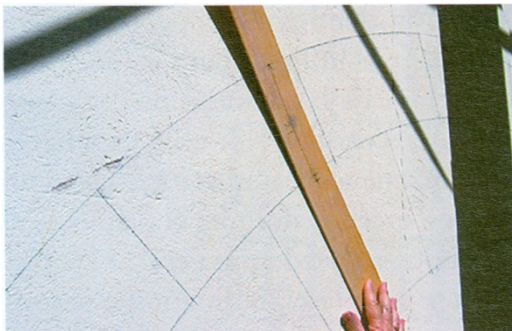
Dibujo de las trazas y monteas a escala 1/1 sobre la pared para obtener la descomposición del dovelaje.
