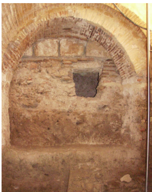
Fotografía de la cimentación desde la cripta
