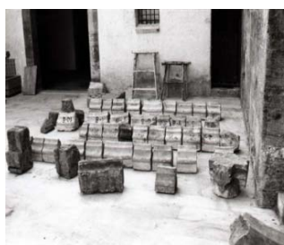
Dovelas desmontadas
