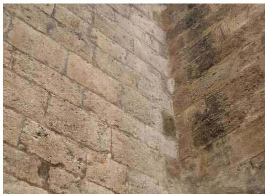
Último tramo exterior sur sillares a modo de esperas
