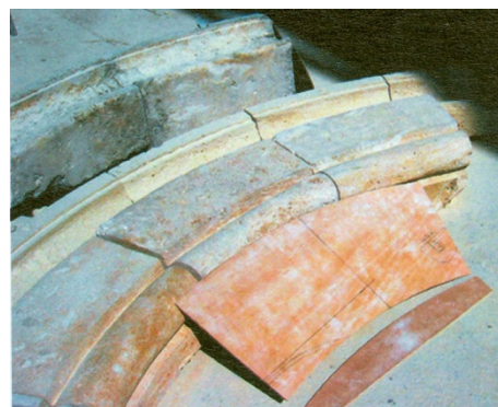
Elaboración de plantillas de madera para tallar los sillares, impostas y dovelas para la recuperación de los arcosolios.
