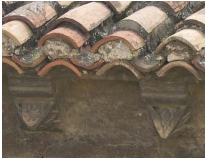
Canecillos del tercer tramo. Muro exterior norte.
