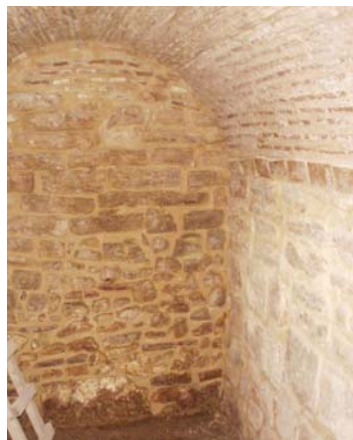
Fotografía de la cimentación de la Capilla de Santa Bárbara, muro derecho
