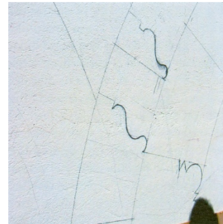
Dibujo de las trazas y monteas a escala 1/1 sobre la pared para obtener la descomposición del dovelaje.
