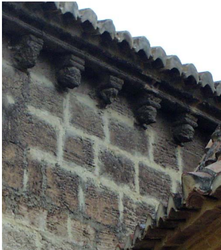
Canecillos del tramo primero. Muro exterior sur.
