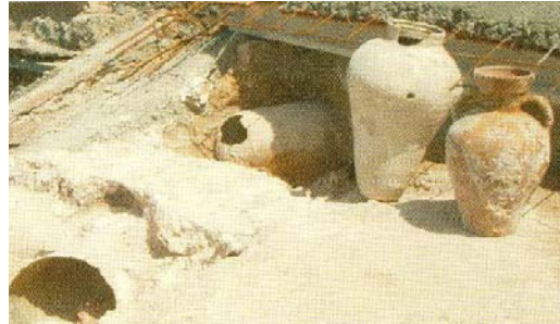
Cerámicas de la bóveda de una capilla de la parroquia vieja de Vilafamés (Comunidad Valenciana) 77
