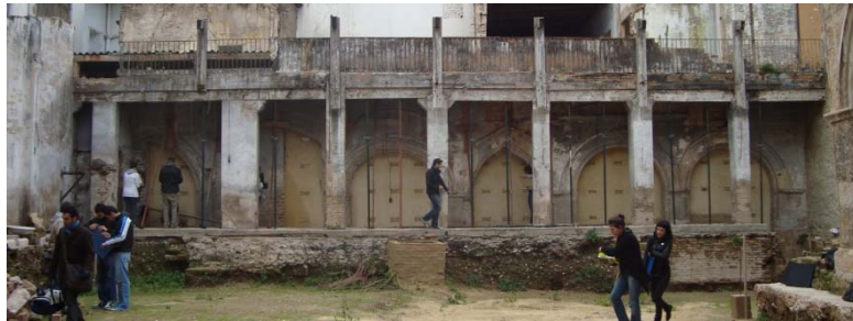
Panda sur de arcosolios con los restos de los pilares de la antigua nave que cubría los talleres de imprenta Domenech.
