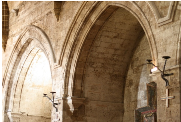
Capillas del lado sur (lado de la Epístola)
