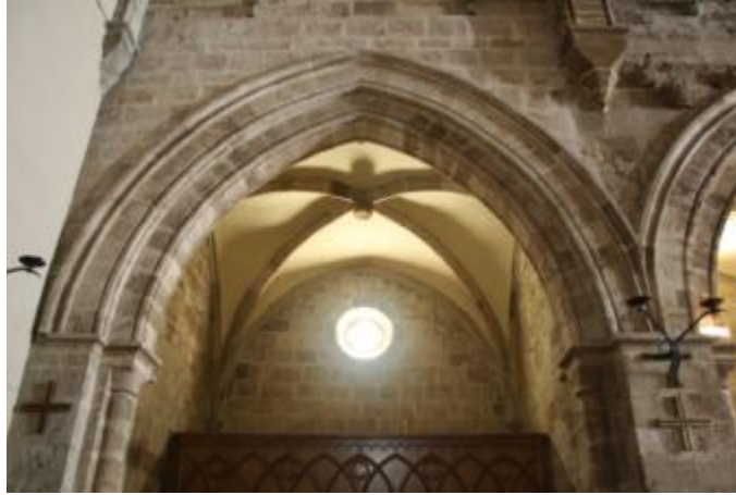
Bóveda de crucería simple. Capilla del confesionario
