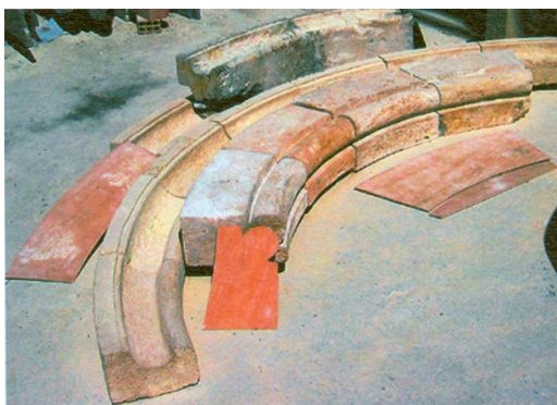
Elaboración de plantillas de madera para tallar los sillares, impostas y dovelas para la recuperación de los arcosolios.
