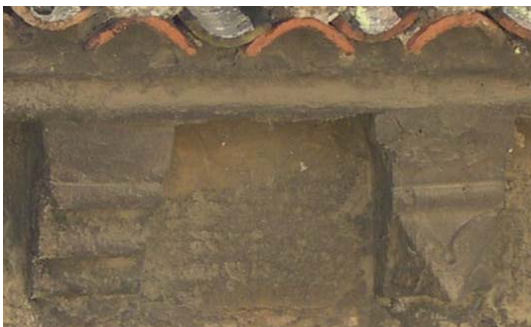
Canecillos cuarto tramo
