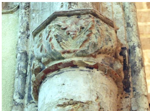
Capitel de la pilastra sobre la que arranca el arco
