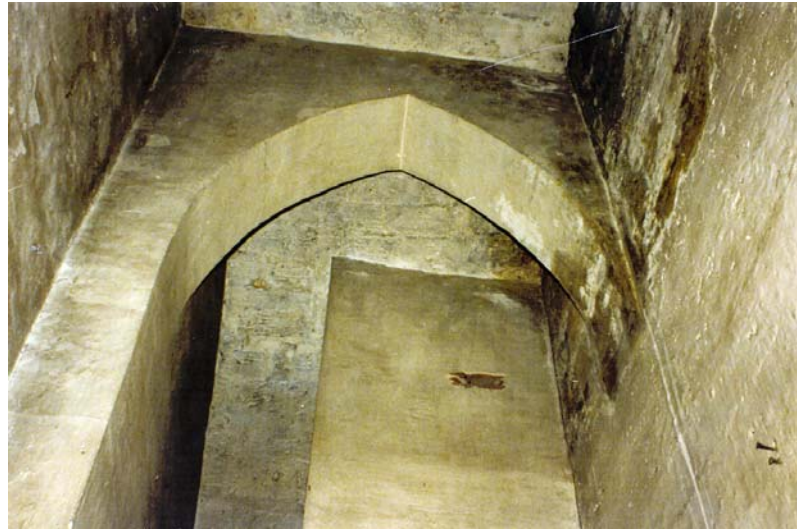
Interior de la cámara oculta
