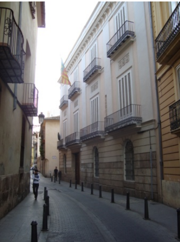
Casa de la encomienda fachada XIX
