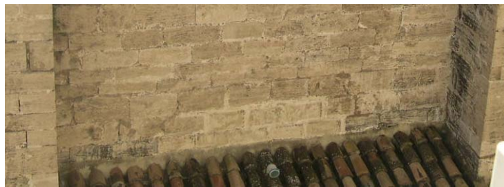
Fotografía actual del muro exterior norte del tramo cuarto
