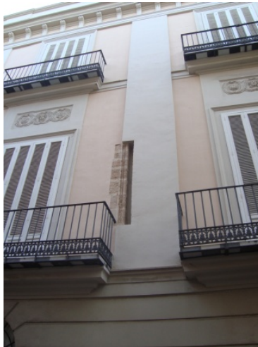
Baquetón de piedra del muro medieval recubierto
