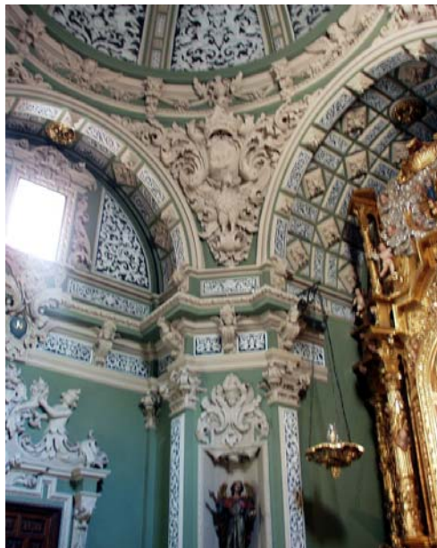
Fotografía de la pilastra y pechina central
