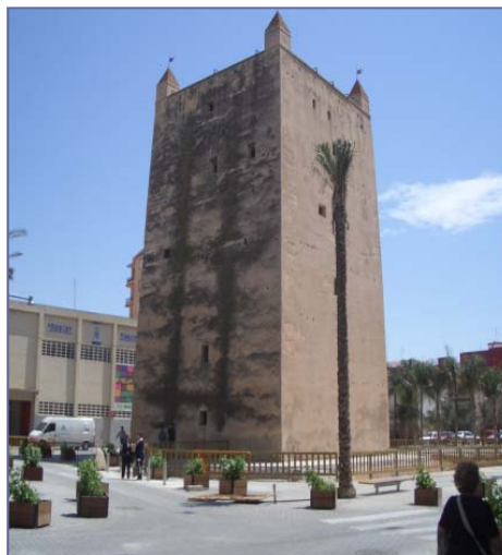
La torre de la antigua encomienda de Torrente
