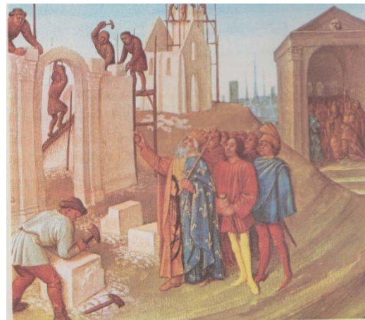
Carlomagno visitando las obras de su Capilla Palatina de Aquisgran construida alrededor de 800 y ejemplo de las plantas centrales octogonales
