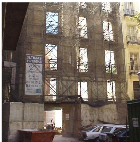
Figura 5. Único acceso a la obra a través del hueco dejado para ello en el lastre durante su construcción
