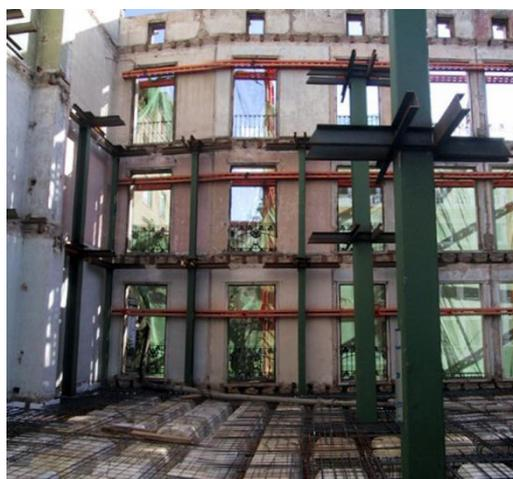
Figura 6. Ejecución de estructura con presencia de estabilizador
