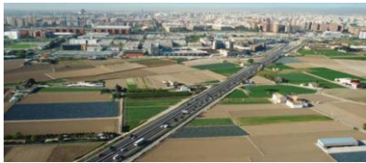
Fig. 35 Autovía seccionando la malla agrícola
