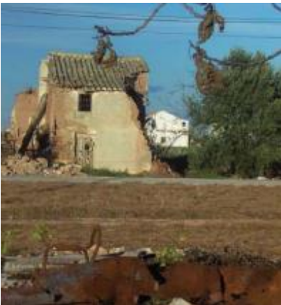
Fig. 36 Construcción abandonada en la huerta
