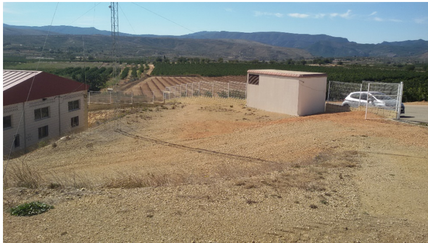
Figura 2: Centro de transformación.
