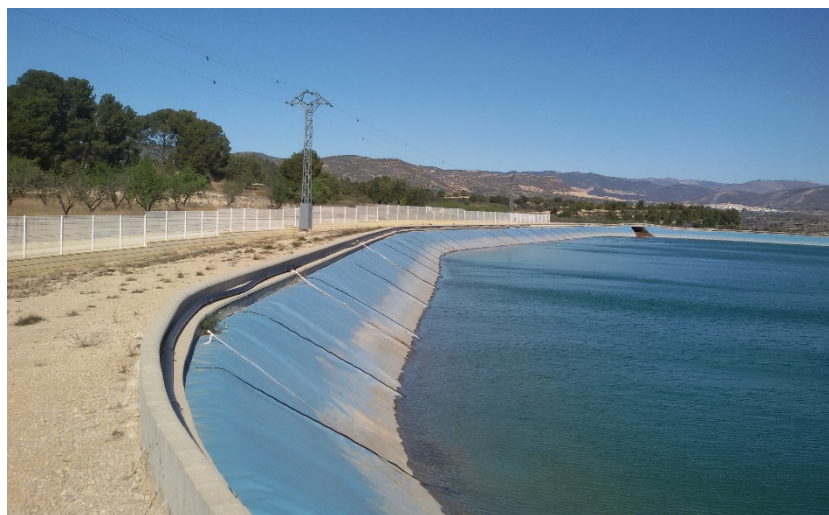
Figura 3: Balsa El Campo y línea de alimentación aérea.
