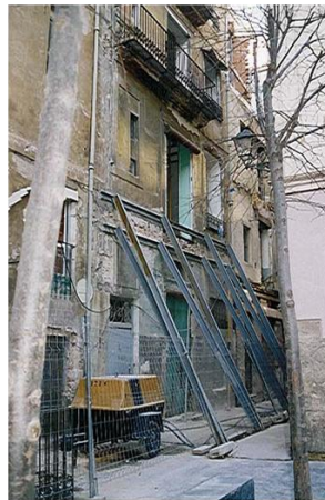
Figuras 4.1, 4.2, 4.3. Apuntalamiento de hueco, de forjado y de medianeras
