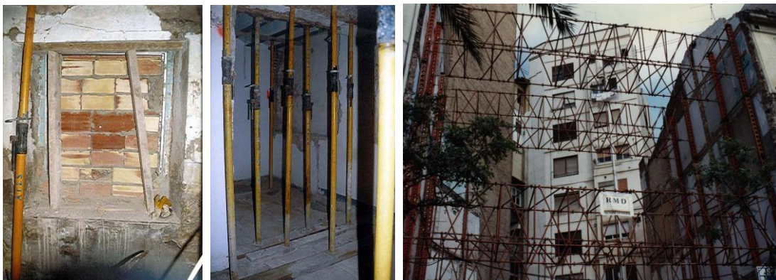
Figuras 3.1, 3.2, 3.3. Apuntalamiento de hueco, de forjado y de medianeras
