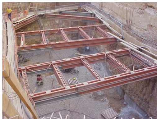
Figuras 2.1, 2.2, 2.3. Apeo vertical, apeos horizontal y apeo inclinado
