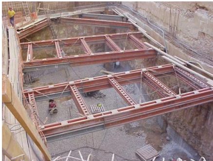
Figuras 4.1, 4.2, 4.3. Apuntalamiento de hueco, de forjado y de medianeras
