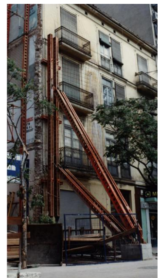
Figuras 2.1, 2.2, 2.3. Apeo vertical, apeos horizontal y apeo inclinado
