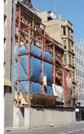
Figuras 4.1, 4.2, 4.3. Apuntalamiento de hueco, de forjado y de medianeras
