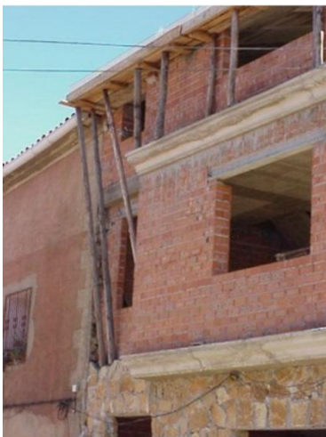
Figuras 2.1, 2.2, 2.3. Apeo vertical, apeos horizontal y apeo inclinado
