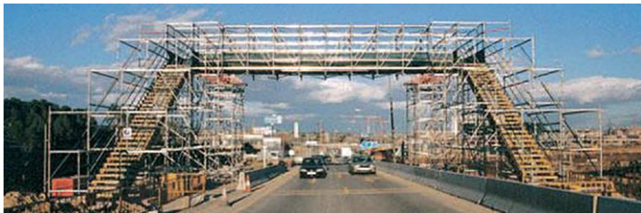
Figura 2. Andamio de seguridad
