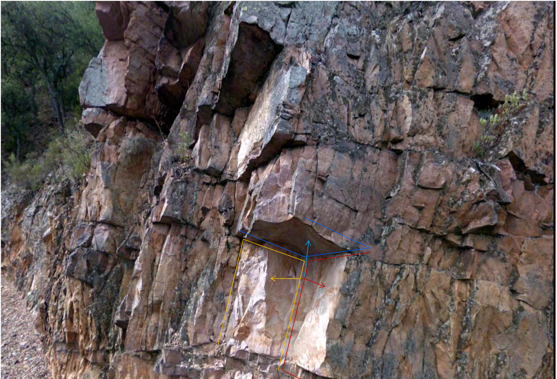
Localización de familias de discontinuidad – diaclasas, planos de estratificación...en las areniscas del Triásico- Buntsandstein cerca de Almedijar. Castellón
