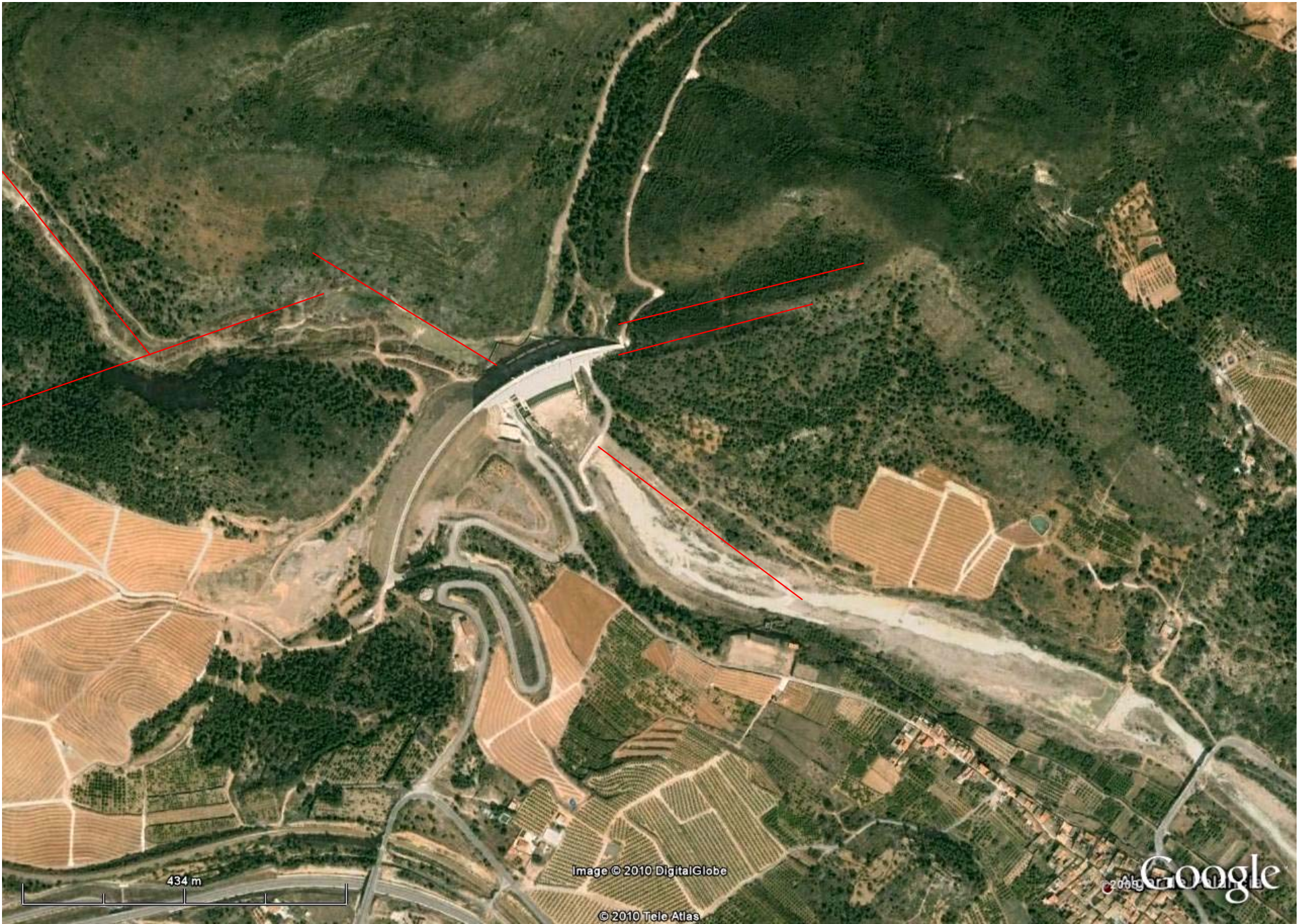
Presa de Algar del Palancia. Valencia.
