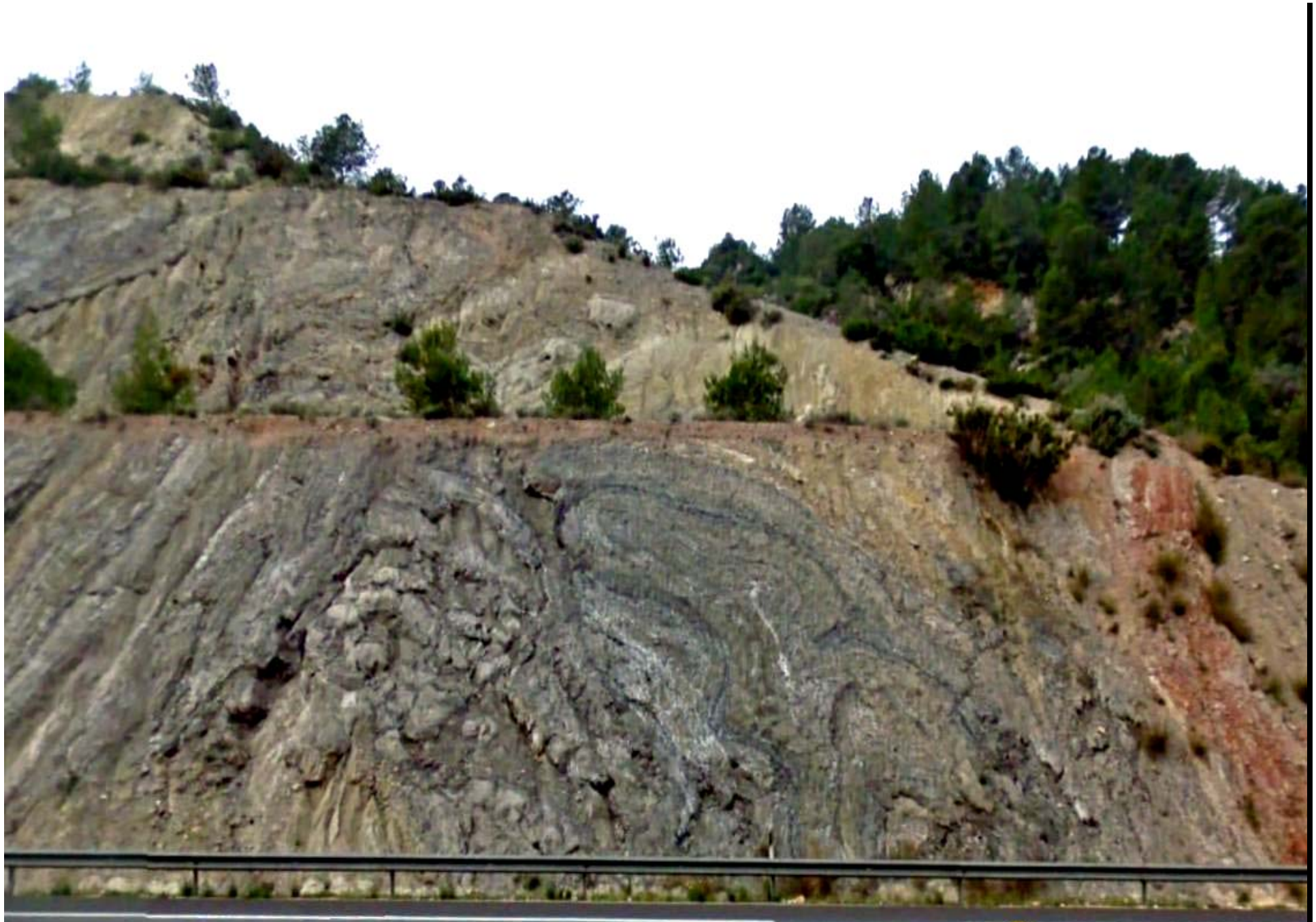
Detalle de los yesos plegados del Triásico ,en un talud de la autovía Valencia – Alicante, en el Puerto de Carcer, Valencia. Los pliegues son por la expansión de los yesos. No son tectónicos
