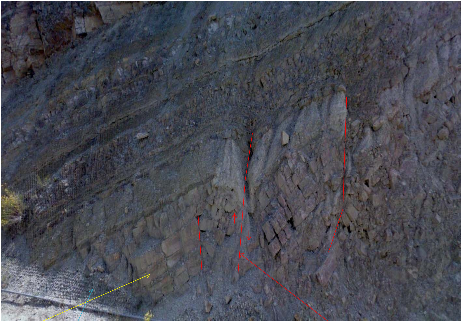
Margas, arcillas, algo de yeso, todos de colores variados. Triásico-Keuper. Incluso pequeñas fallas. Conjunto inestable junto a carretera- tela metálica- de Tuejar a Titáguas- Valencia.
