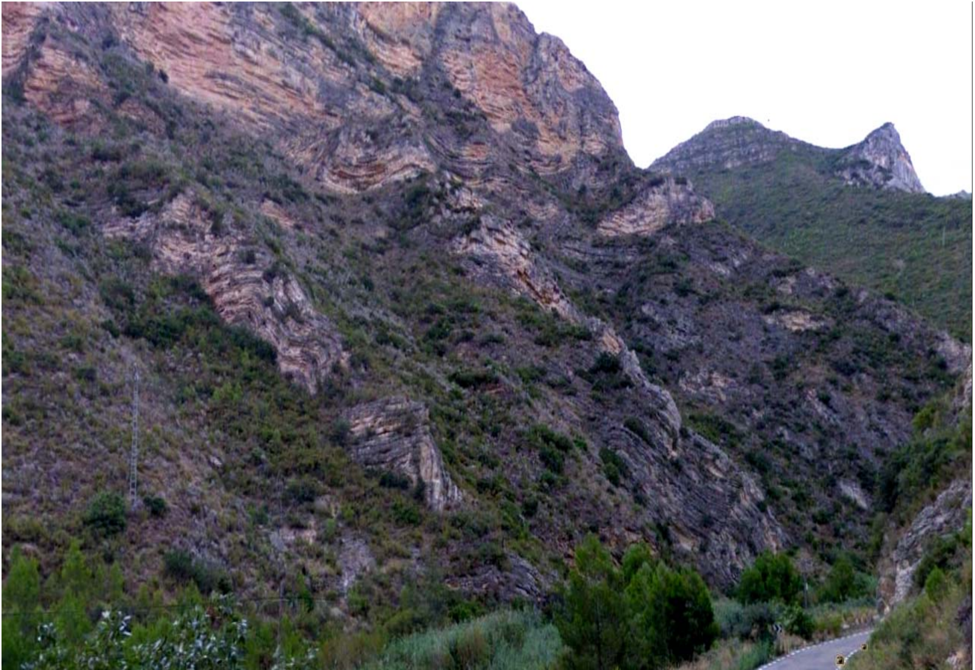
Zona con rocas carbonatadas del Jurásico fuertemente tectonizada, en Barranco Río Reatillo, carretera de Sot de Chera a Chera. En la montaña del fondo una buena falla. Mire las capas.
