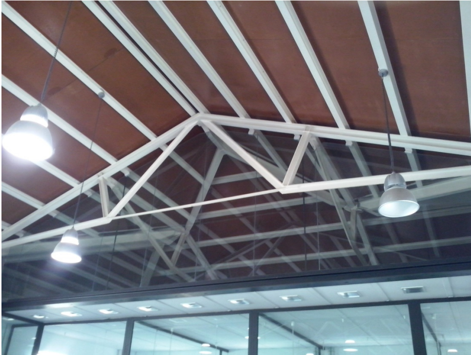
INTERIOR 8: Techo planta primera Fuente: Cámara personal
