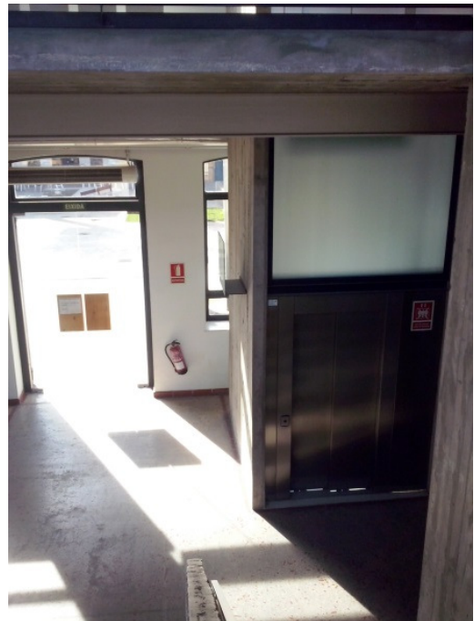
INTERIOR 4: Escalera a la puerta de acceso desde la plaza. Fuente: Cámara personal
