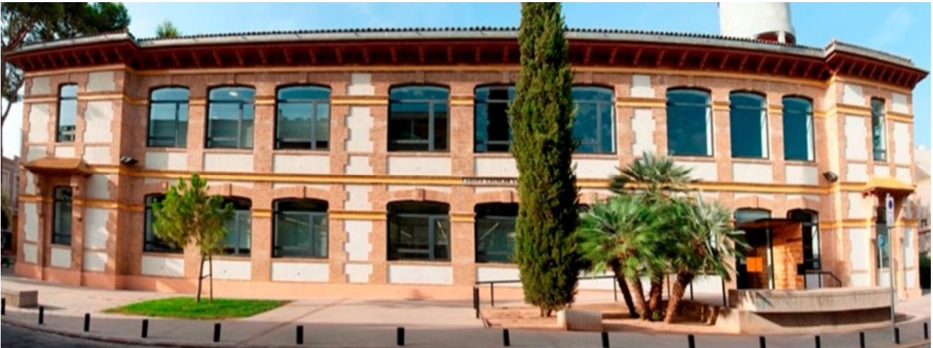
1 EXTERIOR: Fachada principal. Fuente: Cámara personal
