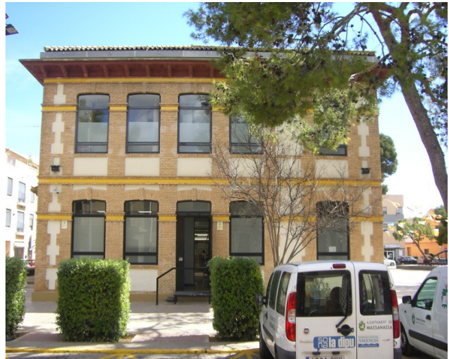
4 EXTERIOR: Fachada Policía Local. Fuente: Cámara personal
