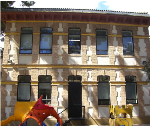
3 EXTERIOR: Fachada con salida de emergencia. Fuente: Cámara personal
