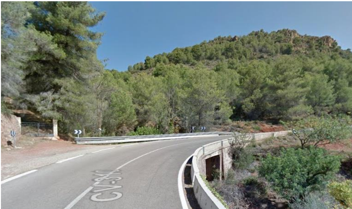
Imagen 41: elemento de drenaje transversal (Contenidos audiovisuales/capturas de Google/Serra-El Tochar/P.K. 22+000 (126).jpg)
