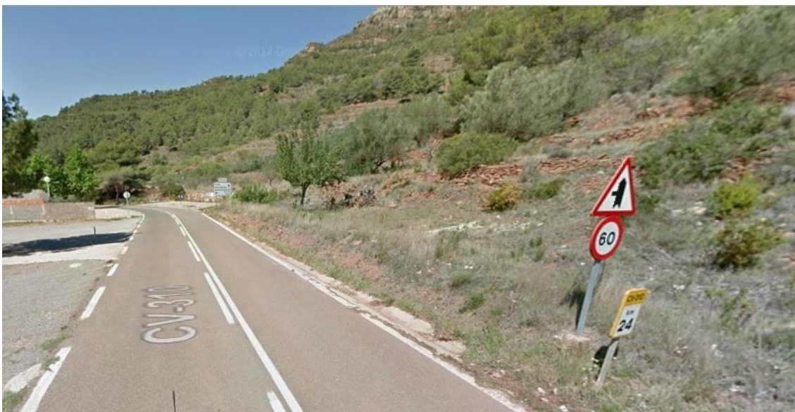
Imagen 7: cunetas de drenaje 4 (Contenidos audiovisuales/capturas de Google/El Tochar-Serra/P.K. 23+000 (326).jpg)
