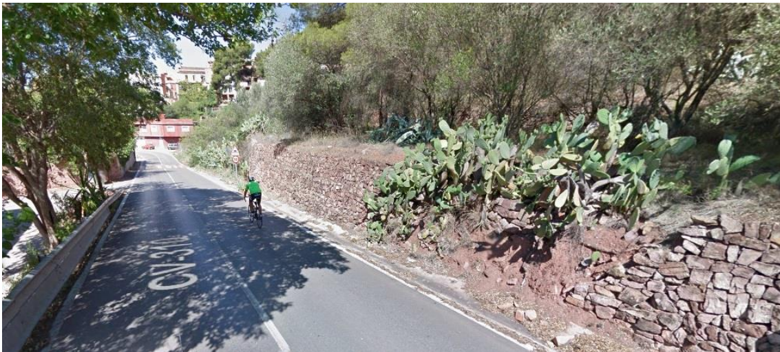
Imagen 40: ejemplo de segundo muro de contención de tierras parcialmente derruido (Contenidos audiovisuales/capturas de Google/ El Tochar-Serra/P.K. 20+000 (482).jpg)
