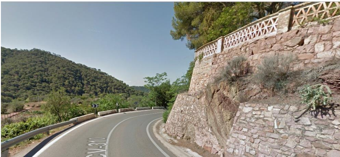
Imagen 35: ejemplo muro de contención de tierras 6 (Contenidos audiovisuales/capturas de Google/ El Tochar-Serra/P.K. 21+000 (466).jpg)
