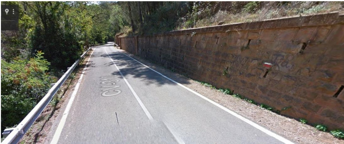
Imagen 32: ejemplo muro de contención de tierras 3 (Contenidos audiovisuales/capturas de Google/ El Tochar-Serra/P.K. 22+000 (402).jpg)
