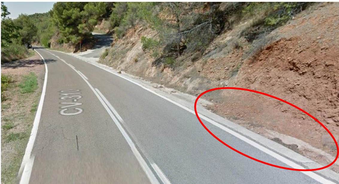
Imagen 5: cunetas de drenaje 2 (Contenidos audiovisuales/capturas de Google/El Tochar-Serra/P.K. 22+000 (426).jpg)
