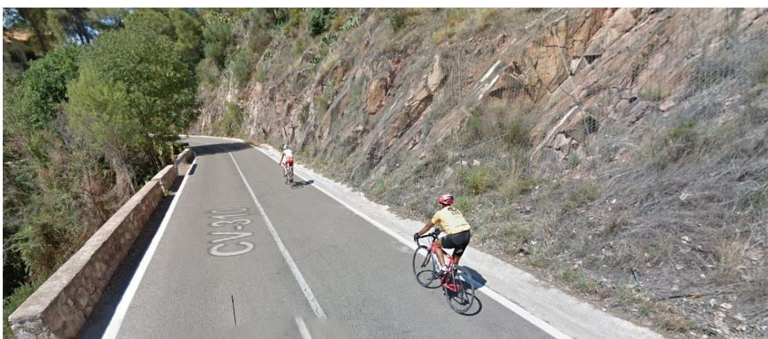
Imagen 28: ejemplo de la presencia de malla metálica 1 (Contenidos audiovisuales/capturas de Google/El Tochar-Serra/P.K. 21+000 (461).jpg)
