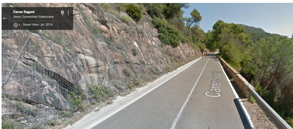
Imagen 29: ejemplo de la presencia de malla metálica 2 (Contenidos audiovisuales/capturas de Google/Serra-El Tochar/P.K. 21+000 (31).jpg)
