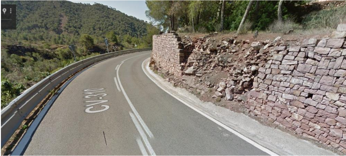
Imagen 39: ejemplo de primer muro de contención de tierras parcialmente derruido 2 (Contenidos audiovisuales/capturas de Google/ El Tochar-Serra/P.K. 21+000 (446).jpg)
