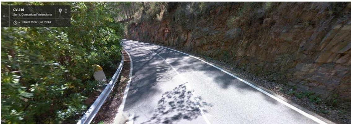
Imagen 15: ejemplo de areniscas con argilitas 2 (Contenidos audiovisuales/capturas de Google/El Tochar-Serra/P.K. 22+000 (408).jpg)
