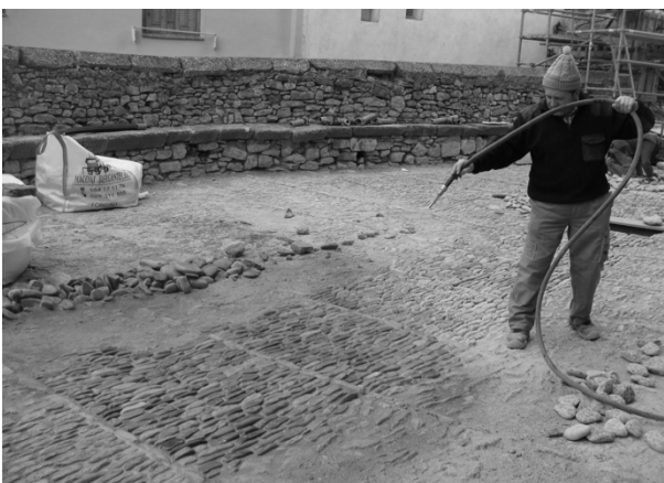
Figura 13. Regado pulverizado del pavimento.
