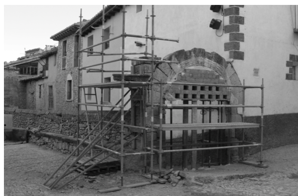
Figura 15. Imagen del apeo del Portal de acceso a la plaza.
