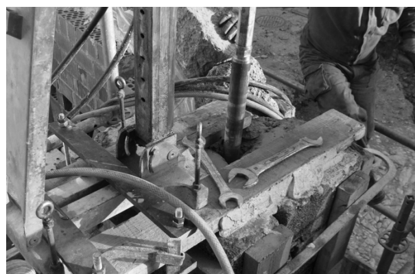
Figura 16. Imagen de la perforación realizada en el pináculo.
