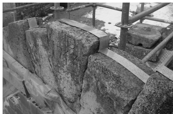
Figura 17. Imagen de la disposición del tutor con la pletina de acero inoxidable en el recorrido de las dovelas.
