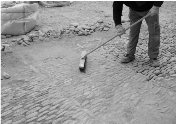
Figura 12. Vertido y cepillado del mortero de cal del rejuntado.
