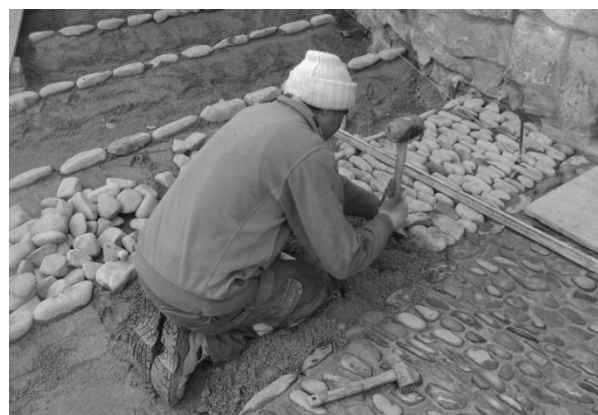
Figura 10. Colocación de los guijarros en seco e hincado de los mismos con la ayuda de una maceta de goma.
