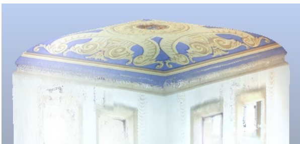
Figura 7. Imagen obtenida de la nube de puntos. Cubierta de la torre con bóveda tabicada. Perspectiva. Autor Rafael Romani
