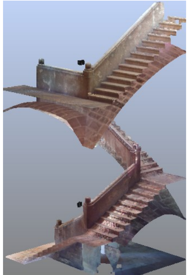
Figura15. Imagen de la escalera obtenida de la nube de puntos capturada con el escáner láser 3D. Autor Rafael Romani
