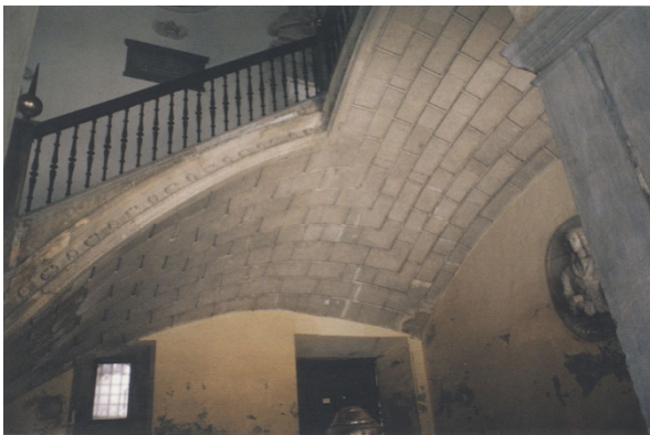
Figura 5. Bóveda de la escalera de la real Cancillería de Granada
