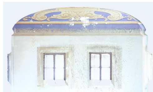
Figura 8. Imagen obtenida de la nube de puntos. Cubierta de la torre con bóveda tabicada. Ortofoto. Autor Rafael Romani
