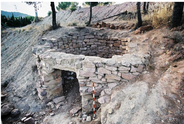
Figura 5. Forn tradicional de calç, reconstruït parcialment. Fotografia obtinguda de la Web principal d'Àrea de Patrimoni Cultural, de la Conselleria de Cultura i Esport, Generalitat de València 1985. Aquest forn es troba en el camí que puja cap a la Font del Frare. Olocau.
