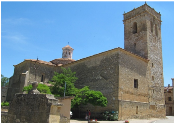
Figura 2. Vista exterior de la Iglesia de San Bartolomé, Tartanedo.
