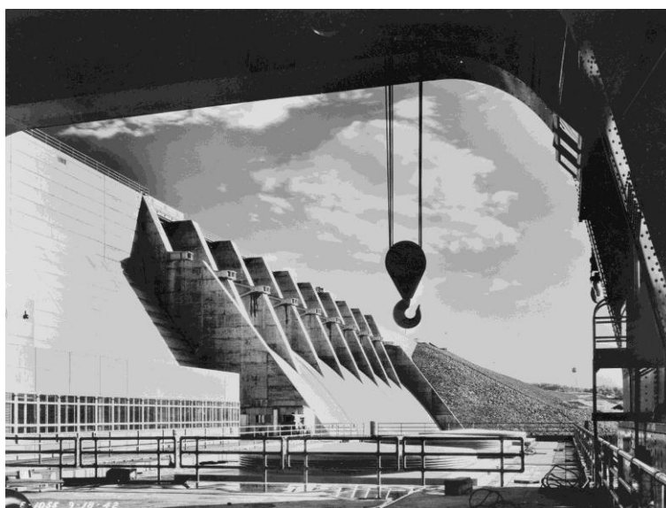
8. La presa Cherokee de la TVA en construcción, Tennessee, h. 1945 (Library of Congress Prints and Photographs Division, LC-USW33- 015646-ZC)
