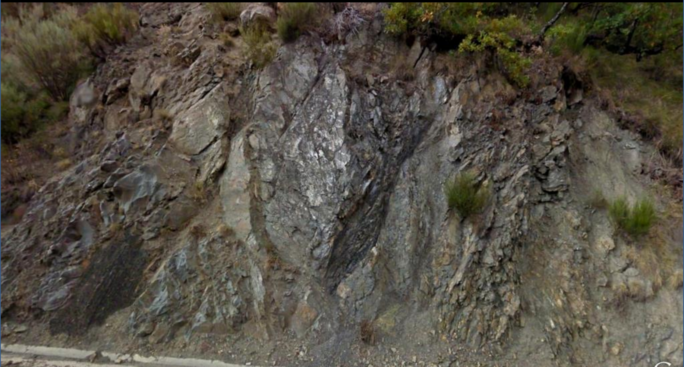
Zona tectonizada en las areniscas, pizarras y niveles de carbón del Estefaniense Sup. Carbonífero. Al NE de Villaseca de Laciara. NE Hoja de Villablino
