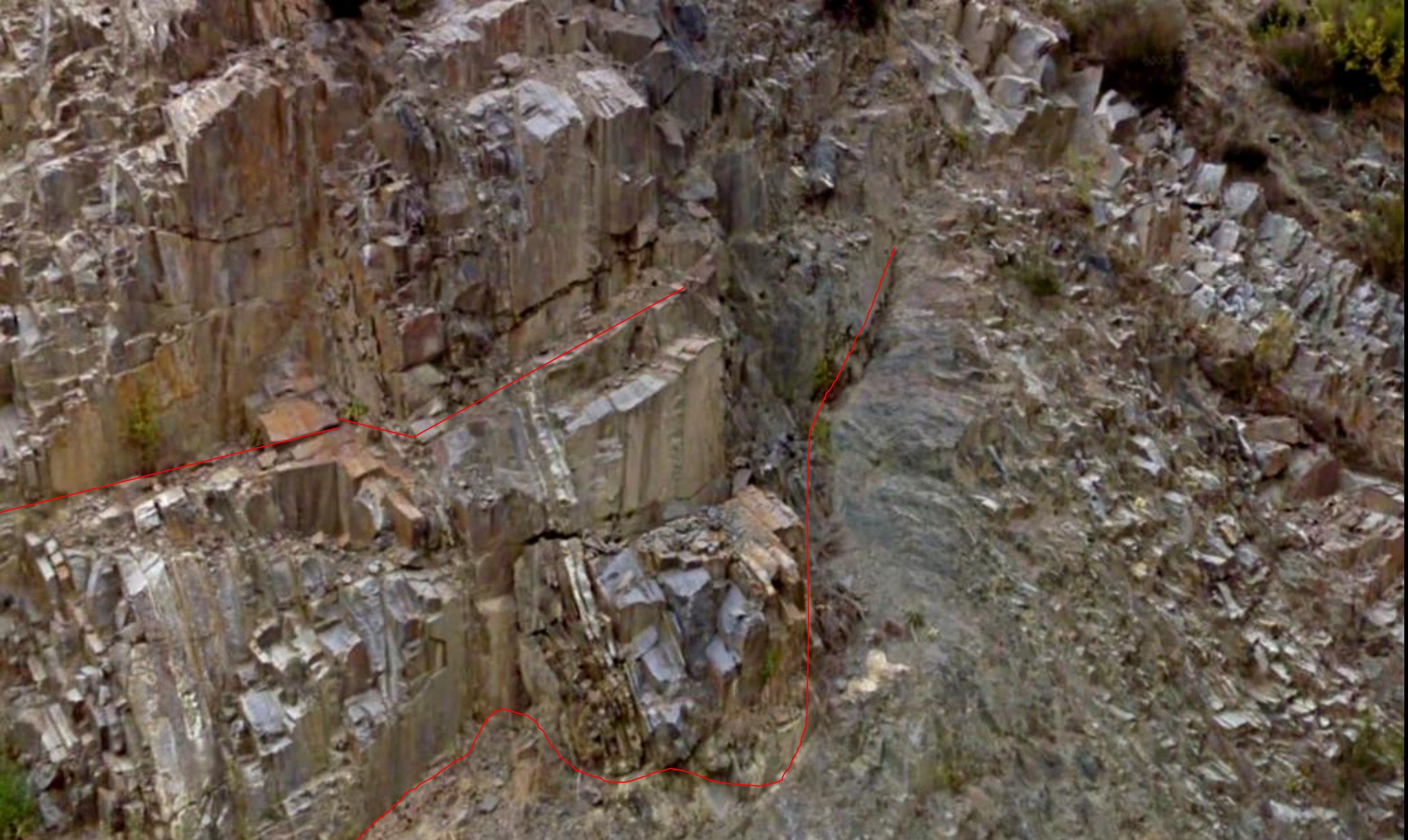
Fallas en las cuandtas, areniscas y pizarras Cámbrico- Ordovícico. Serie de los Cabos. N de Palacios del SW Hoja de Villablino.
