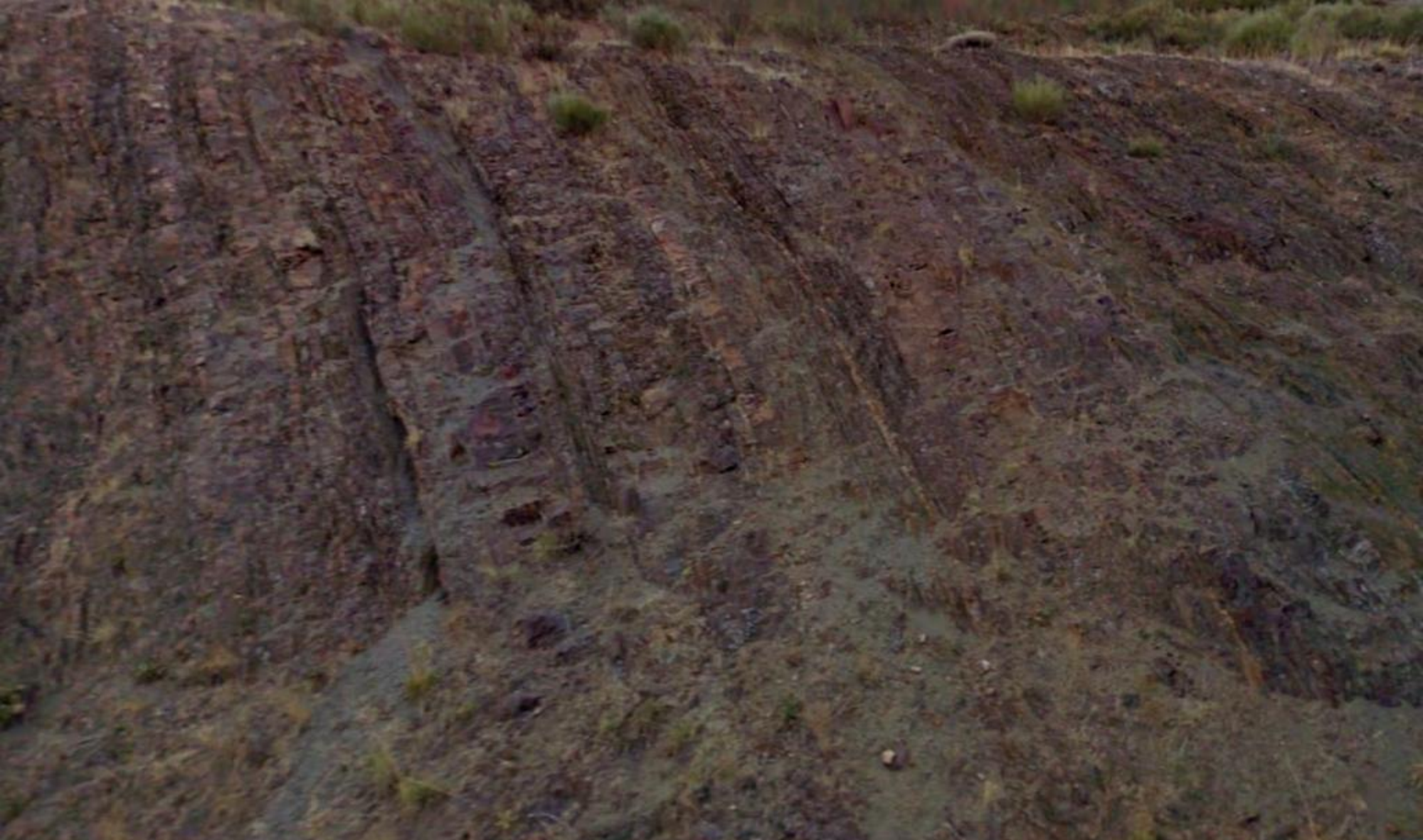
Areniscas ferruginosas Fm. San Pedro. Autopista antes del puente viejo Embalse de Los Barrios de Luna. León
