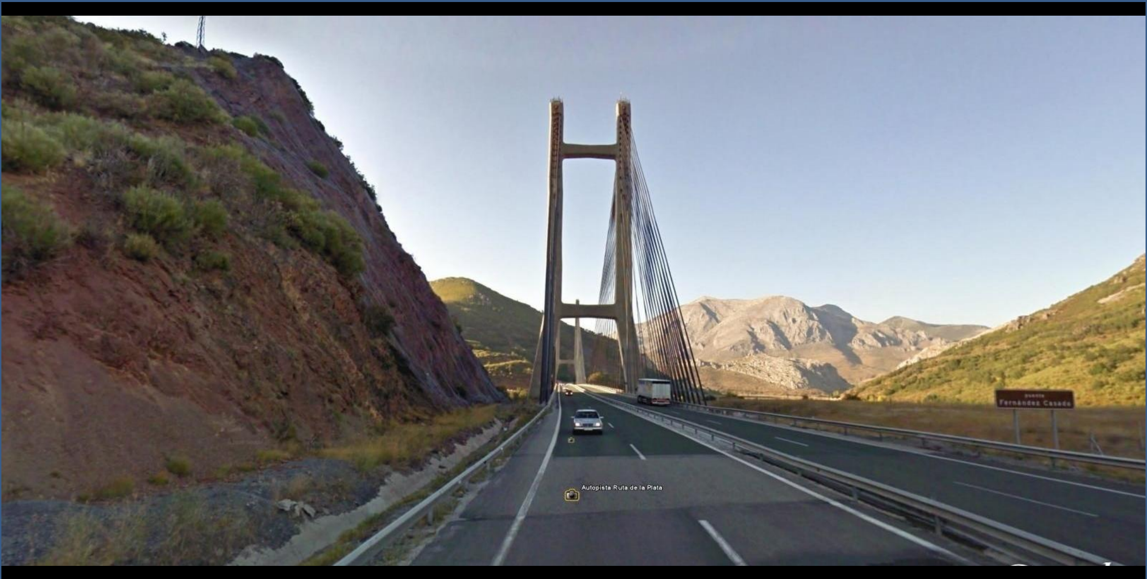
Puente Fernández Casado, apoyo Sur. Autopista por zona del estribo W del Embalse Los Barrios de Luna. León. Fms- San Pedro y Formigoso. Silurico.
