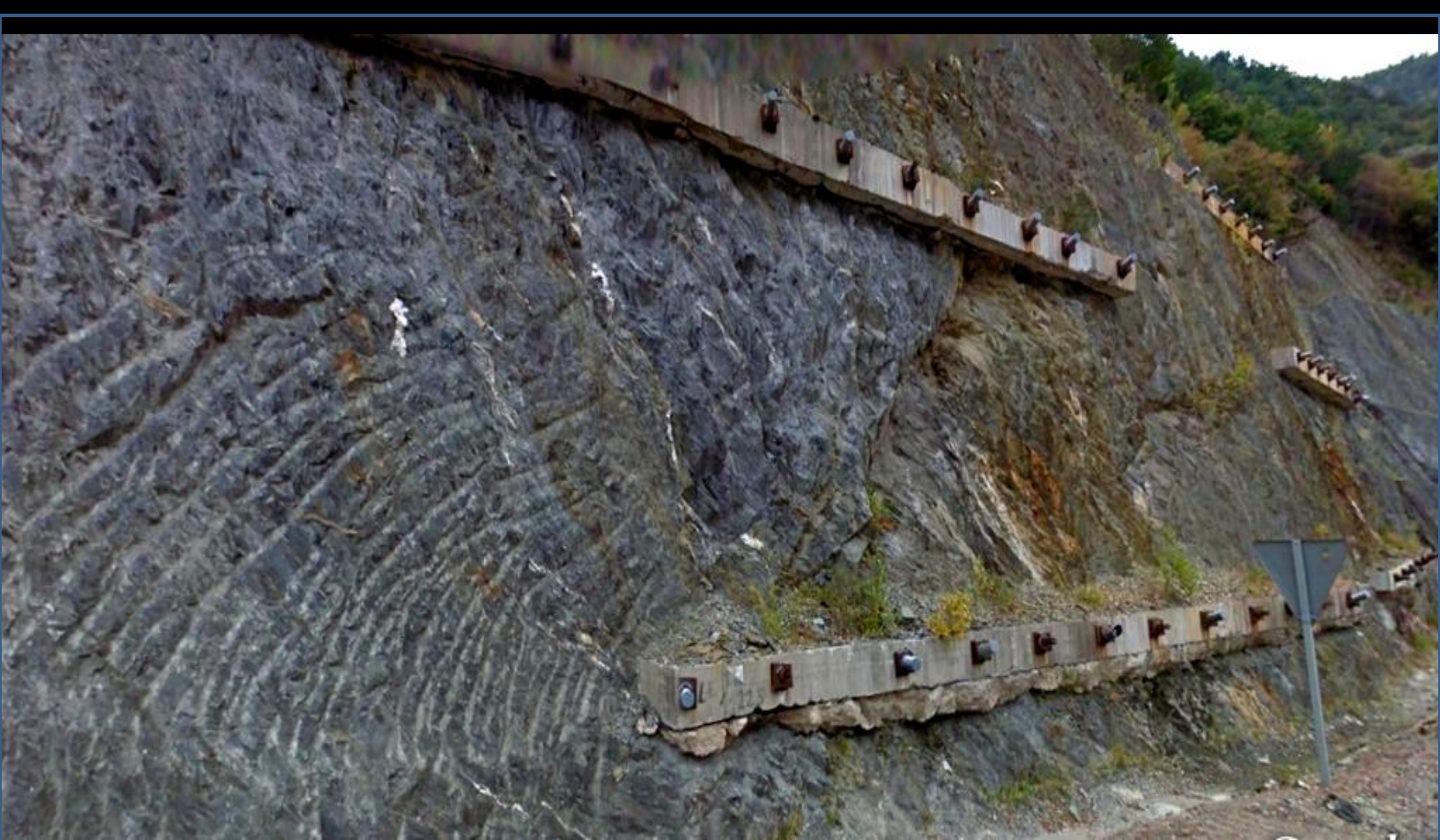
Detalle del cinchado de protección en materiales del Precámbrico de Narcea, junto Embalse de Las Rozas. E de Villarino del Sil. Centro Hoja de Villablino
